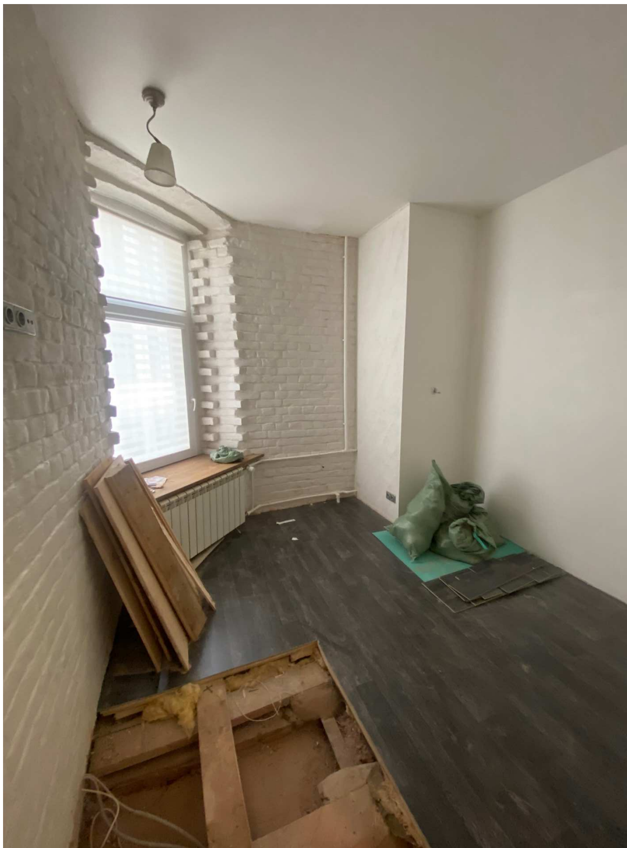
5. Фрагмент интерьера комнаты (помещение 2/24.6);
