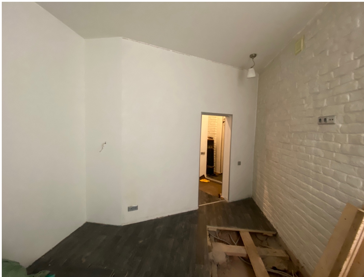
6. Фрагмент интерьера комнаты (помещение 2/24.6);
