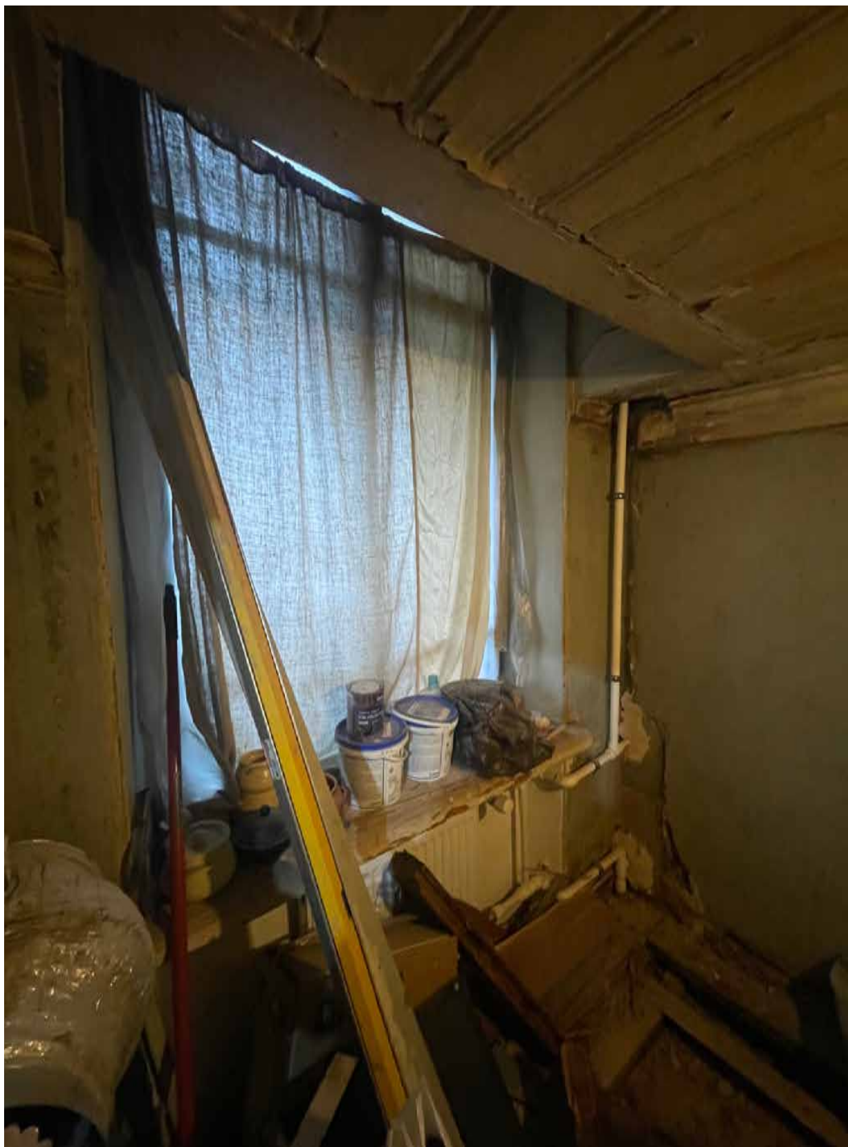
29.Фрагмент интерьера МОП (помещение 21/9.3);
