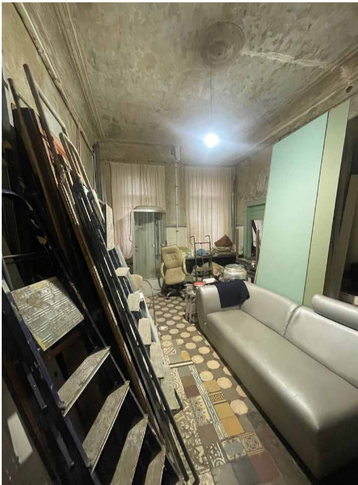
27.Фрагмент интерьера кухни (помещение 23/24.7);
