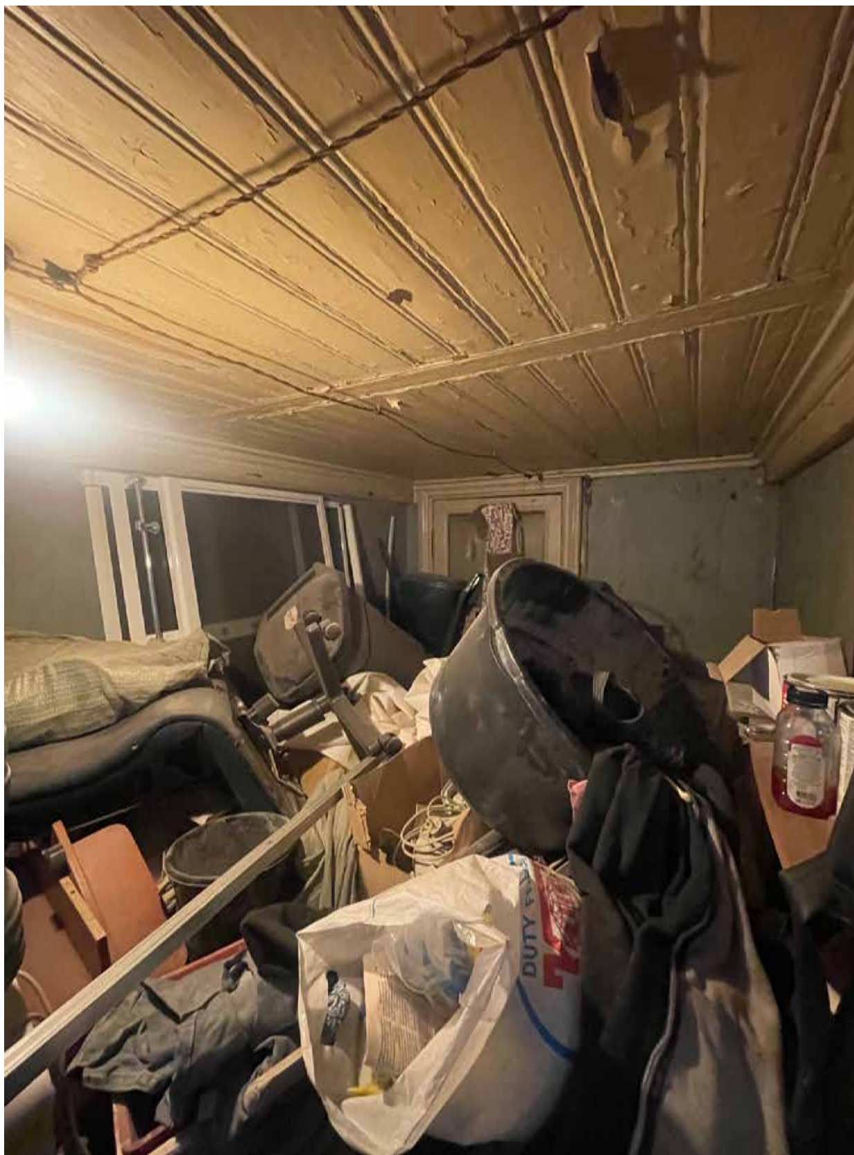
28.Фрагмент интерьера МОП (помещение 21/9.3);
