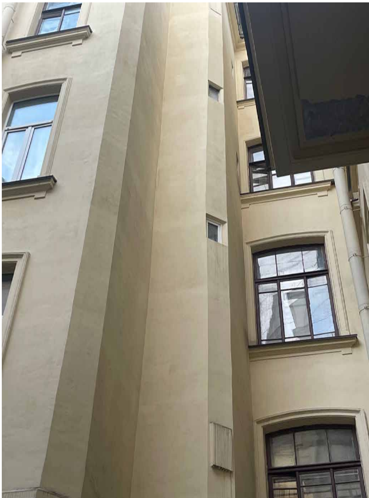
5. Вид на дворовой фасад выявленного объекта культурного наследия «Дом Ю.Б.Бака», расположенного по адресу г. Санкт-Петербург, Кирочная улица, дом 24, литера А (Кирочная ул., 24);
