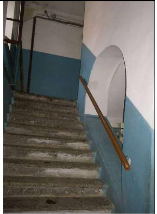
2-ЛК – местоположение (в уровне 1-4-го этажей), габариты, конфигурация, тип (одномаршевая), конструкция (на косоурах), материал ступеней и площадок (известняк);
