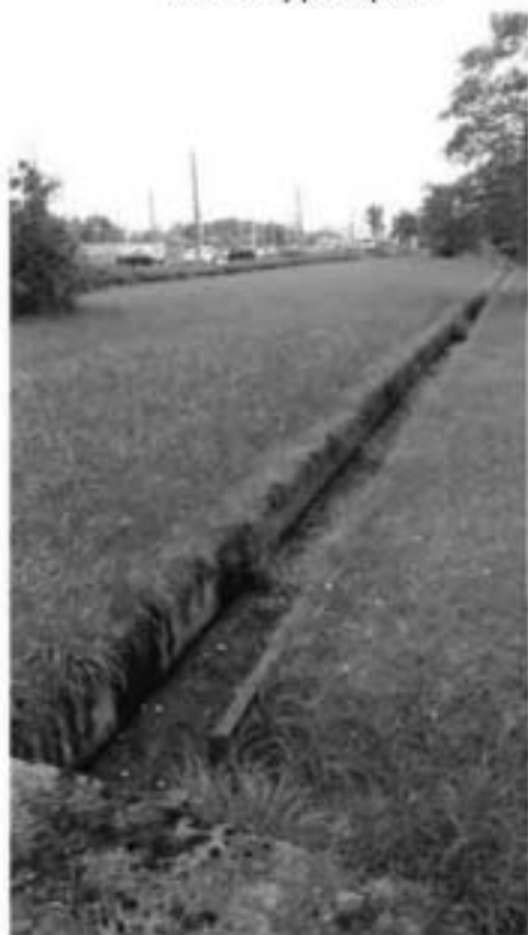
27. Водосбросный лоток в северной части территории
