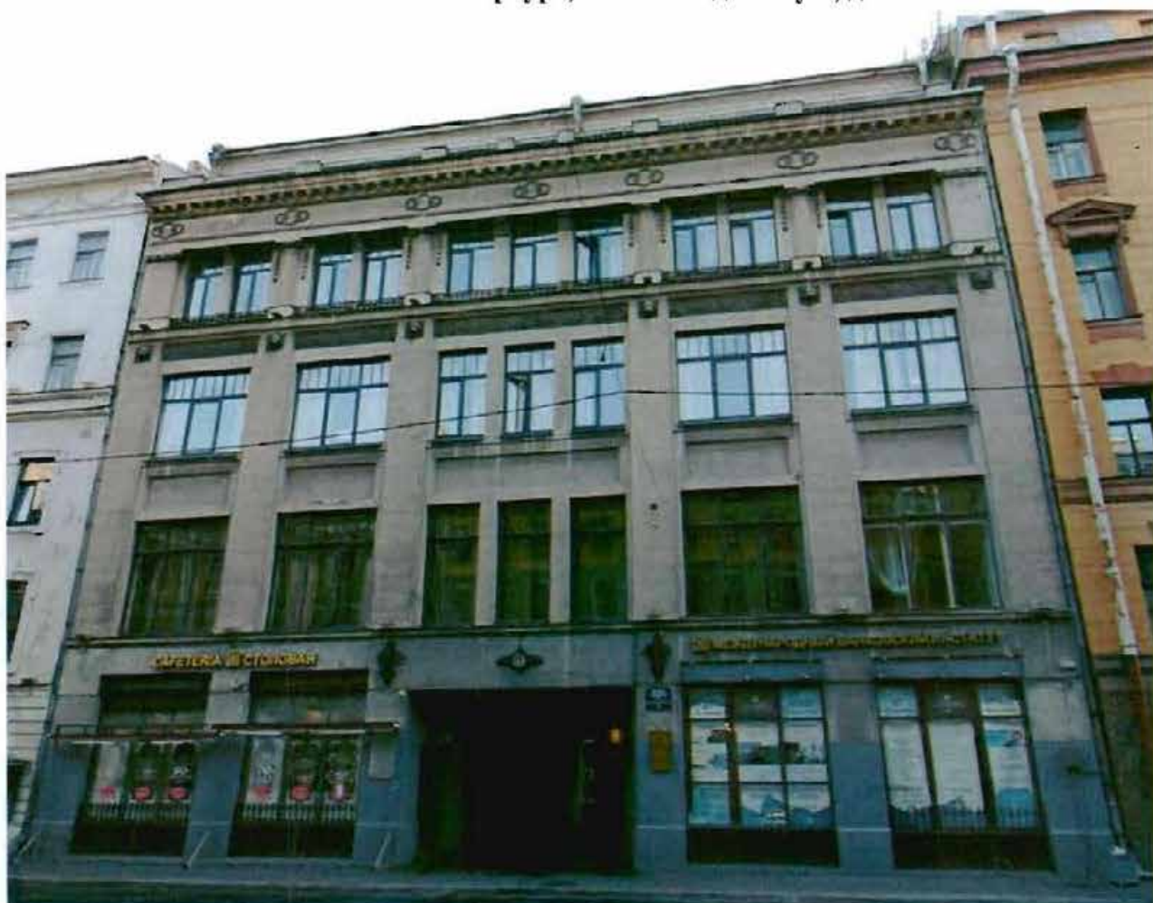
14. Фасад по Малой Садовой улице
