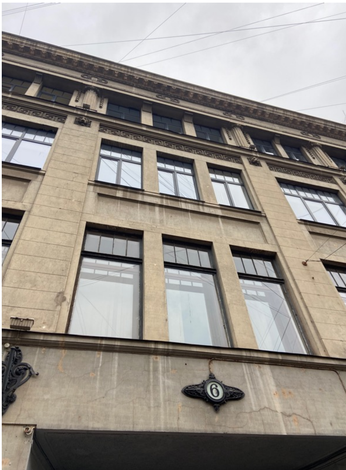
3. Фрагмент лицевого фасада
