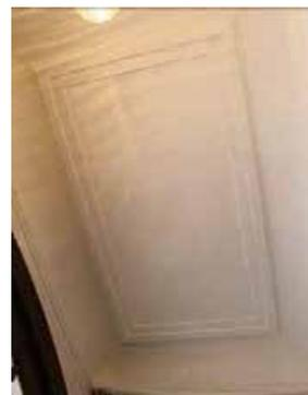
стены тамбура облицованы деревянными филёнчатыми панелями с профилированным карнизом в верхней части;
