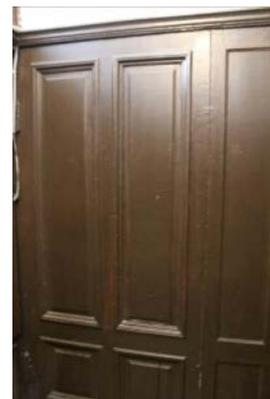
оформление дверного проема – деревянный профилированный наличник;
