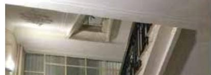
потолок лестничной клетки оформлен профилированной тягой по периметру; в верхних частях стен – профилированный карниз;
