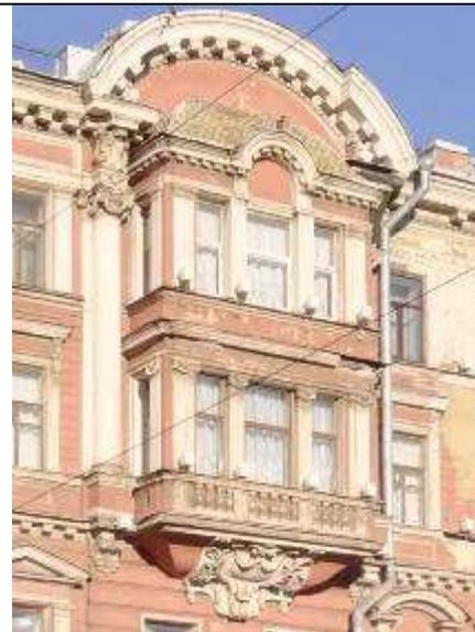
эркер с балконом в основании — местоположение (в уровне 3-4-го этажей угловой части здания), конфигурация (полуциркульный в плане), габариты;
