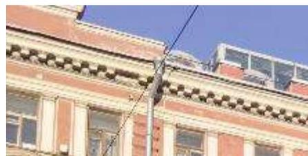
аттики с профилированным карнизом в завершении и прямоугольной филенкой в центральной части (утрачена), количество (четыре), местоположение, конфигурация (ступенчатые), габариты;
