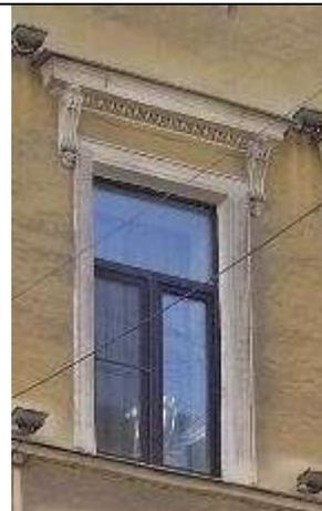
венчающий профилированный карниз на модульонах, с поясом иоников;
