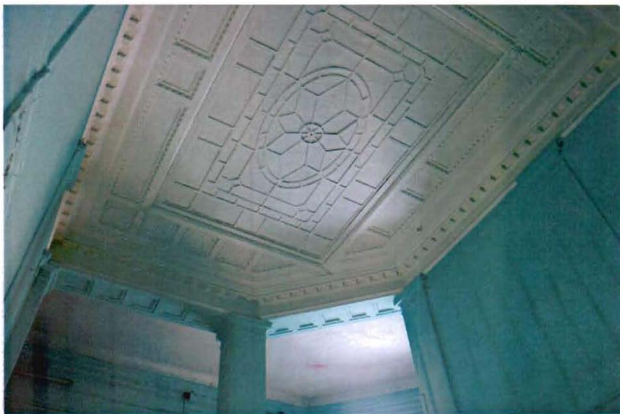
Фото № 22, 23, 24. Лестничная клетка Л-2 восточного корпуса.
