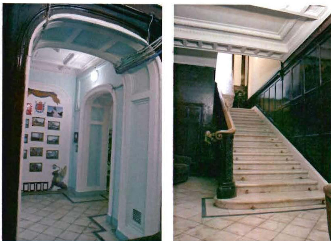
Фото № 7, 8. Проходная 1-го этажа пом. 2-Н(39).
