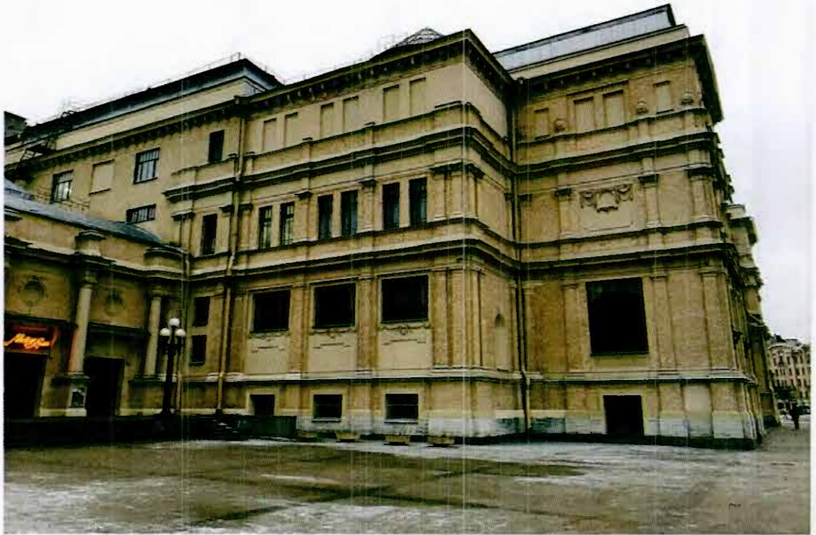
Фото 3. Восточный фасад (лицевой фасад).
