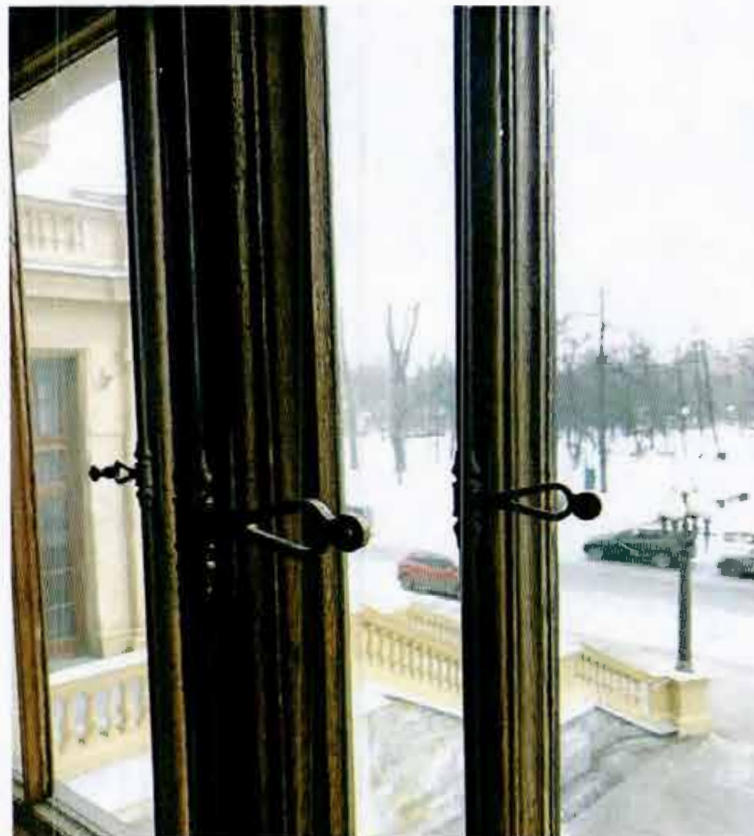
Фото 10. Шпингалеты оконного проема парадной лестницы.
