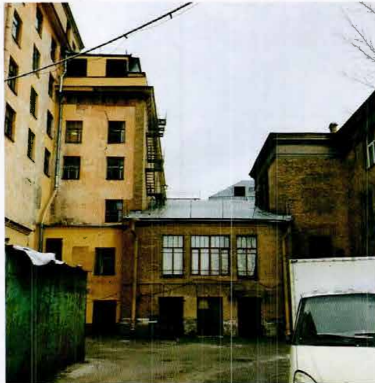
Фото 6. Фрагмент южного (дворового) фасада.
