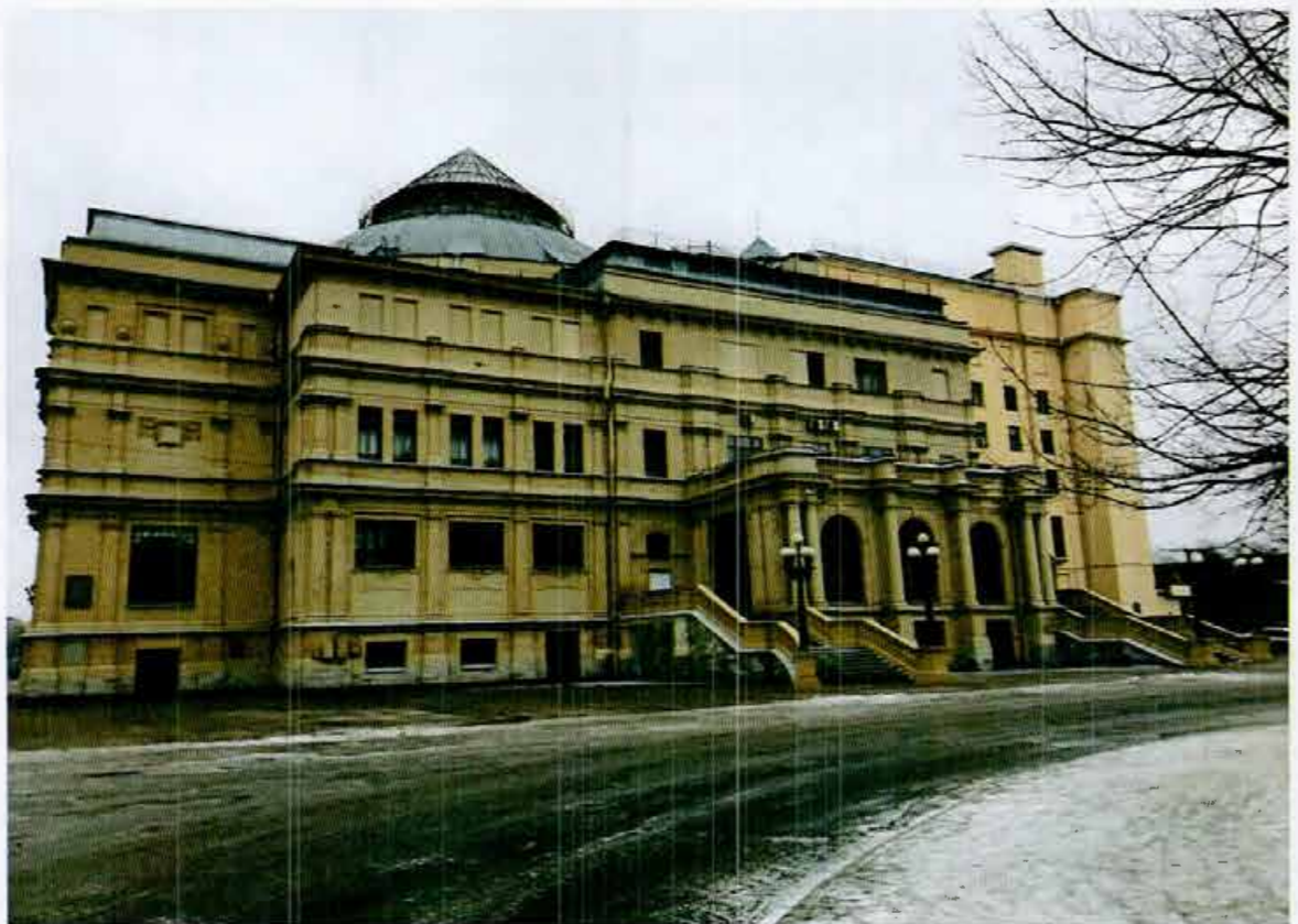
Фото 4. Западный фасад (лицевой фасад). Фрагмент.
