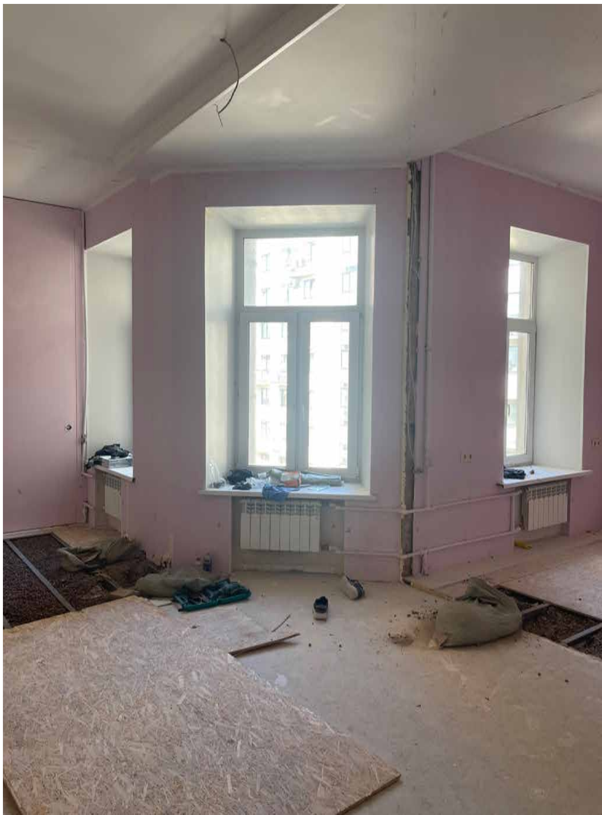
8. Фрагмент интерьера комнаты (помещение 7/22);
