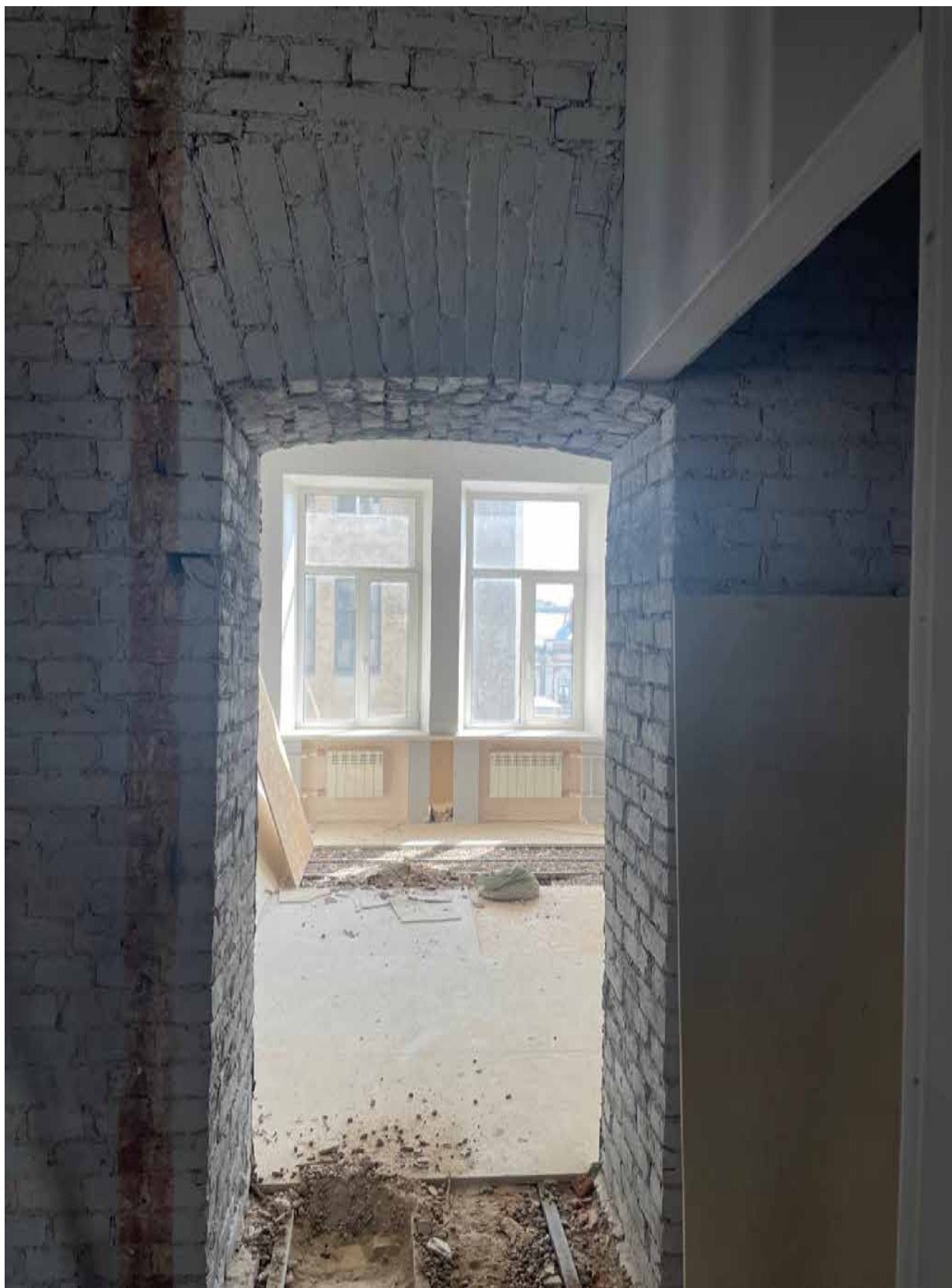
9. Фрагмент интерьера комнаты (помещение 8/19.6);
