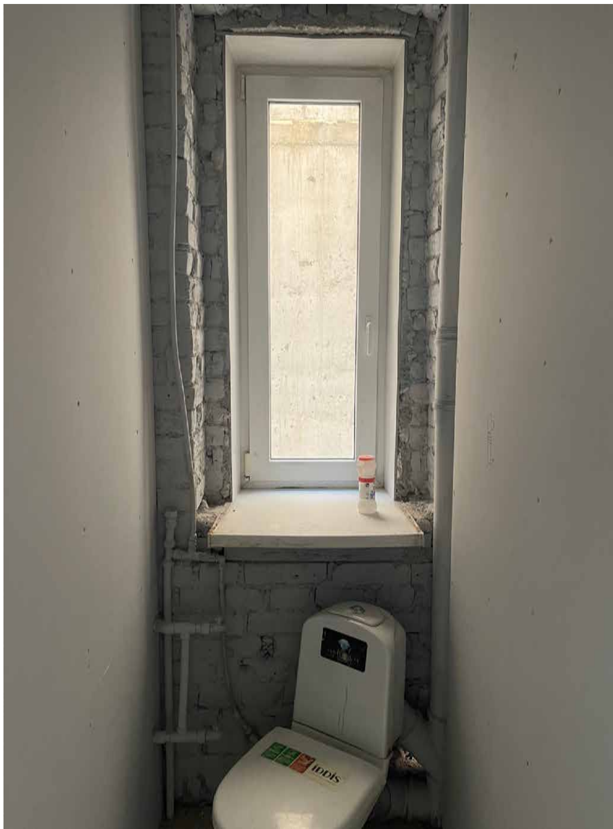
13.Фрагмент интерьера туалета (помещение 4/1.4);
