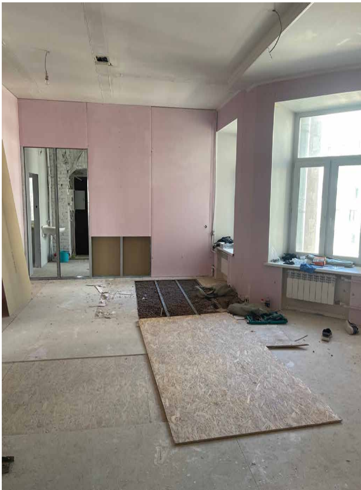
7. Фрагмент интерьера комнаты (помещение 7/22);
