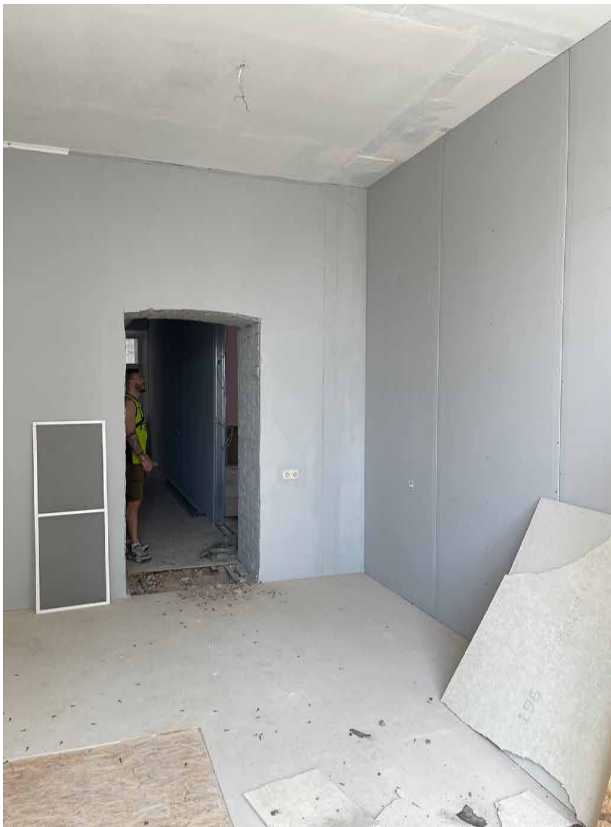
10.Фрагмент интерьера комнаты (помещение 8/19.6);
