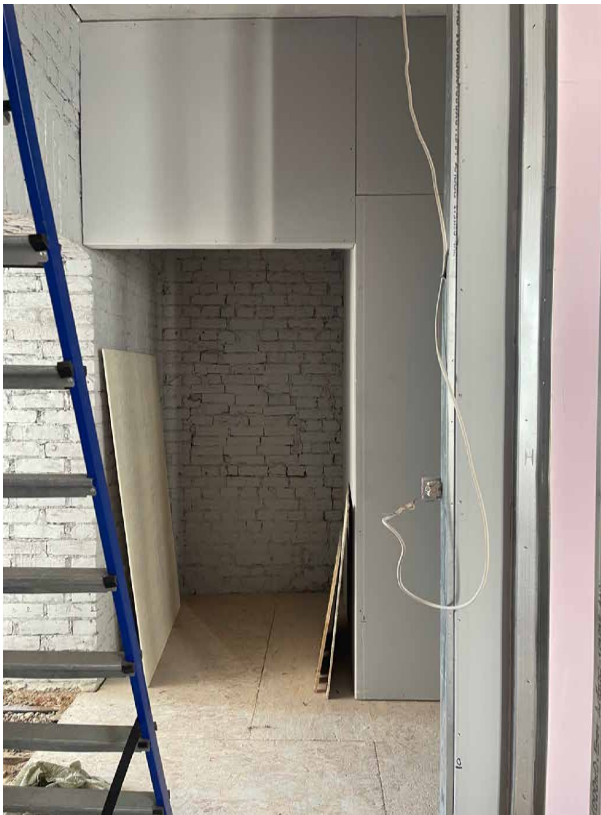
6. Фрагмент интерьера комнаты (помещение 11/14.7);
