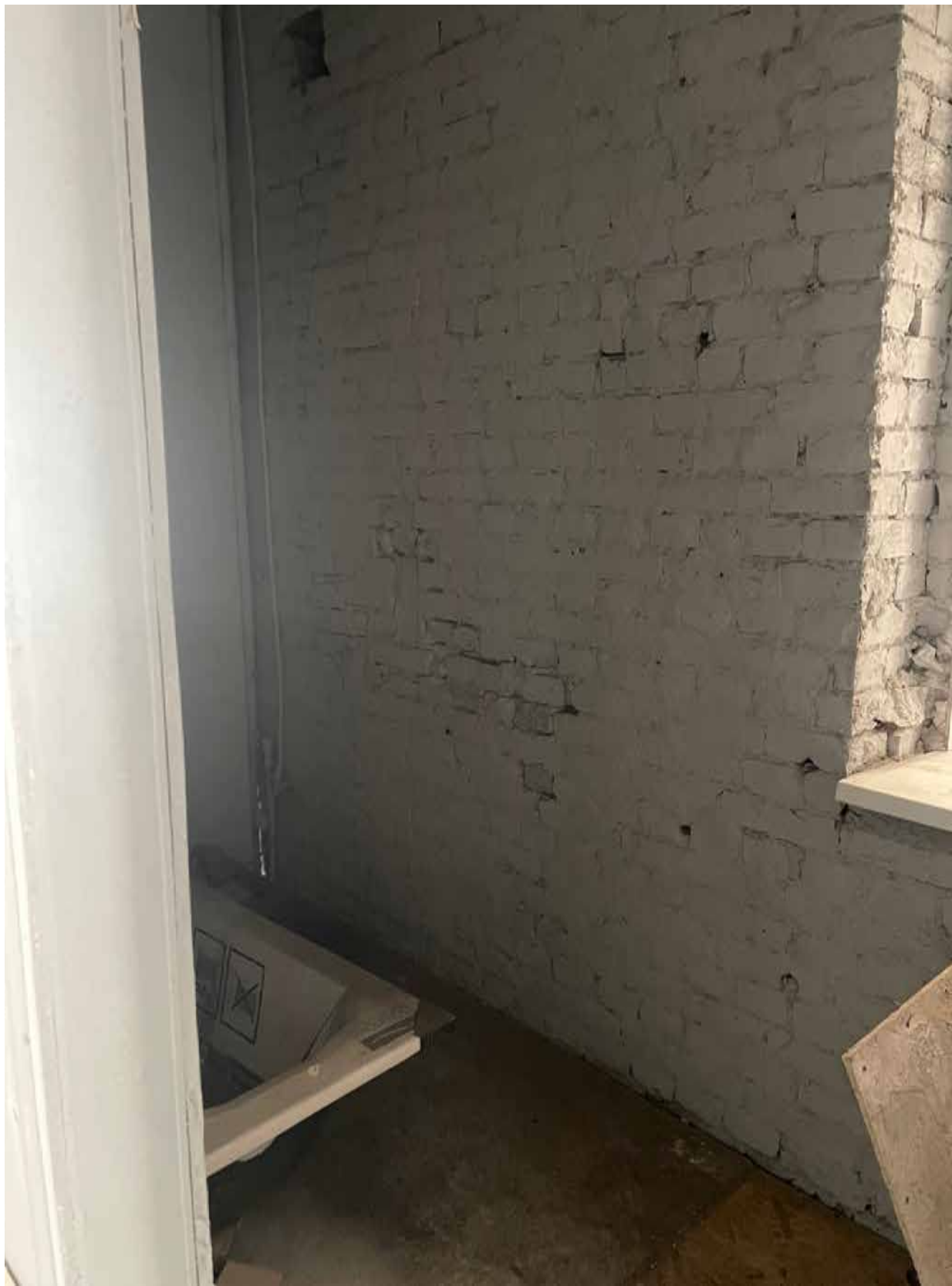
12.Фрагмент интерьера ванной (помещение 5/4.6);
