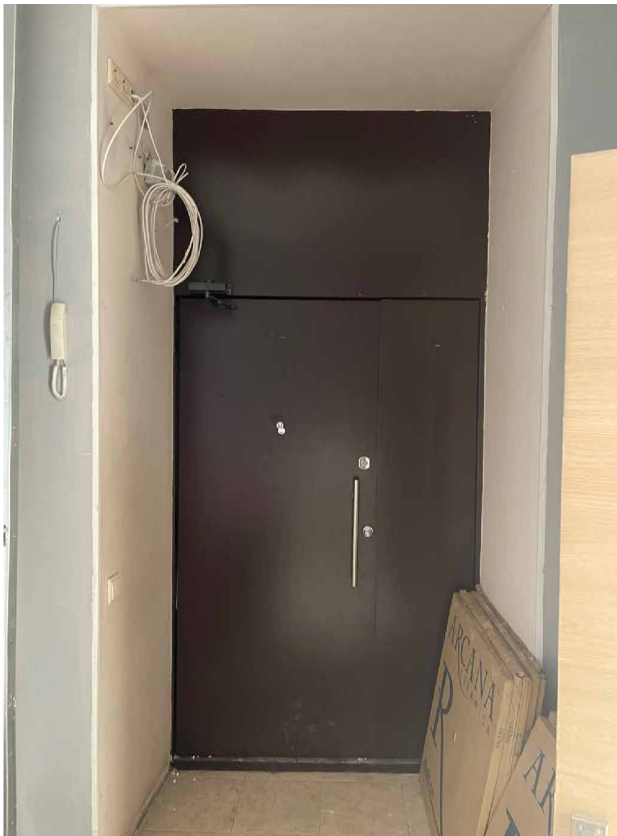
2. Вид на входную дверь в квартире;
