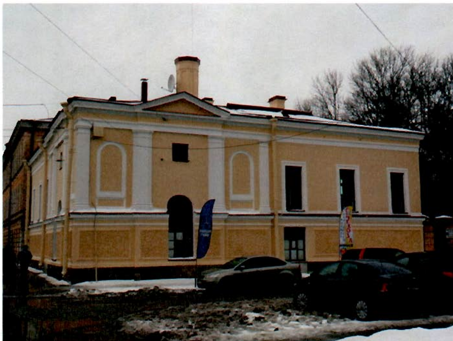
14. Восточный лицевой фасад здания.
