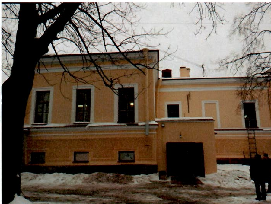
15. Северный дворовый фасад здания.
