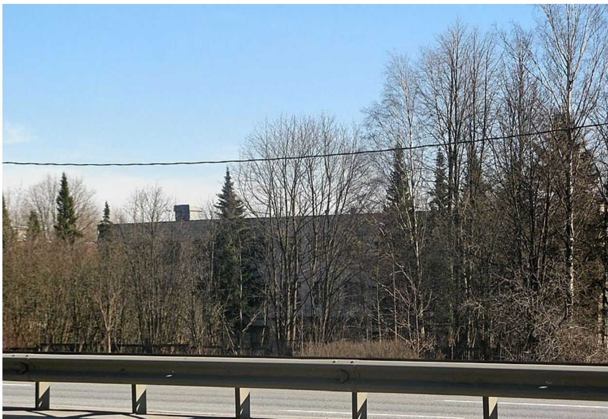
89. Лабораторный корпус. Фотография. Автор фото – Борисова Е. 2019 г. // Источник: [Электронный ресурс] - URL: https://commons.m.wikimedia.org/ (дата обращения: 09.07.2024).
