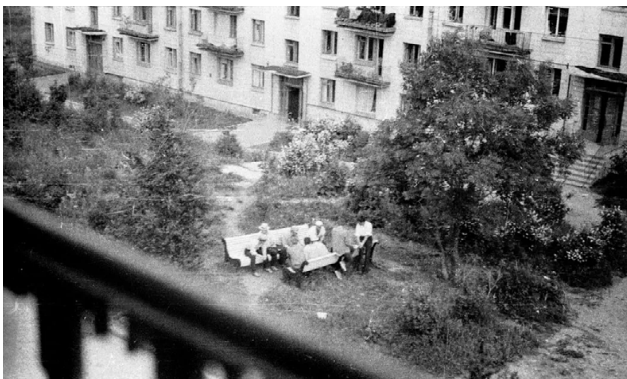
77. Пулково, двор между домами 12 и 13. Фотография. Автор фото – Кувырков И. В. 1973 г. // Источник: [Электронный ресурс] - URL: https://pastvu.com/p/123453 (дата обращения: 09.07.2024).
