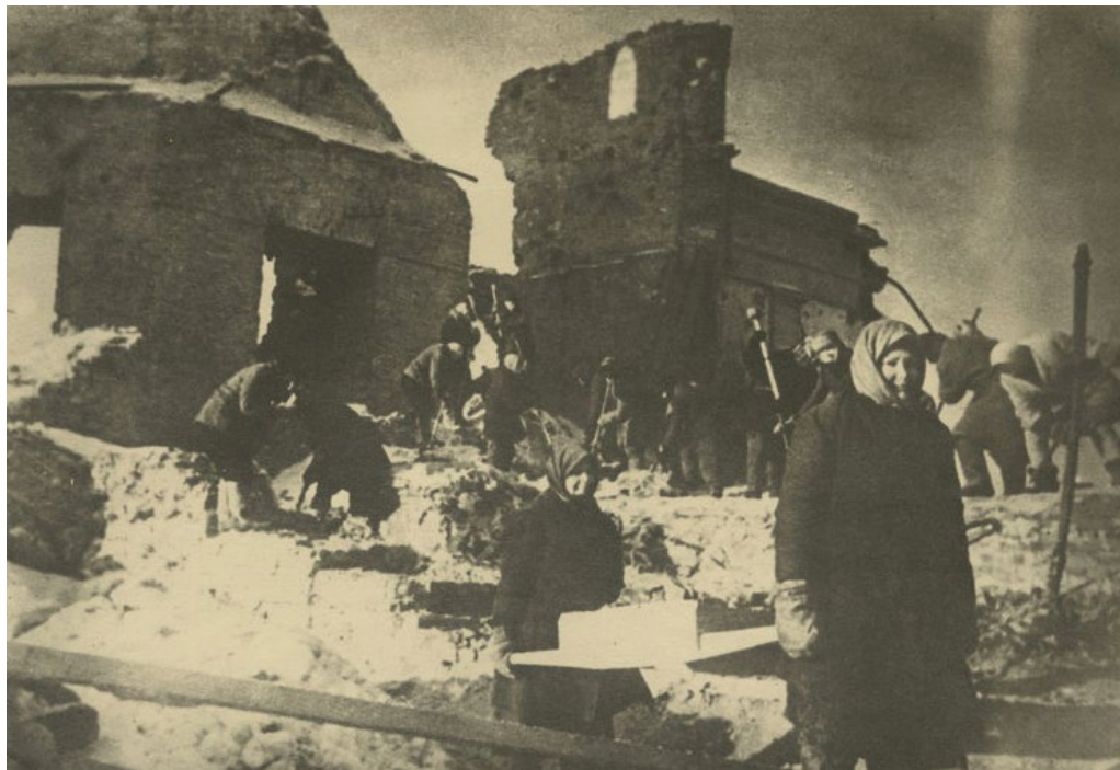
44. Начало работ по восстановлению Пулковской астрономической обсерватории. Фотография. Автор фото неизвестен. 1945 г. // Источник: [Электронный ресурс] - URL: https://goskatalog.ru/portal/#/collections?id=35868641 (дата обращения: 09.07.2024).
