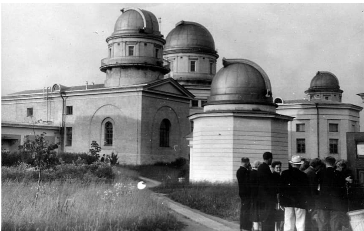
55. Пулковская обсерватория после восстановления и реконструкции. Фотография. Автор фото неизвестен. 1954 г. // Источник: [Электронный ресурс] - URL: https://www.kommersant.ru/doc/6713217#id2561873 (дата обращения: 09.07.2024).
