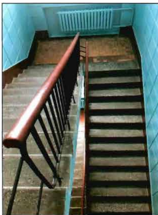
3. Центральная лестница. Общий вид.
