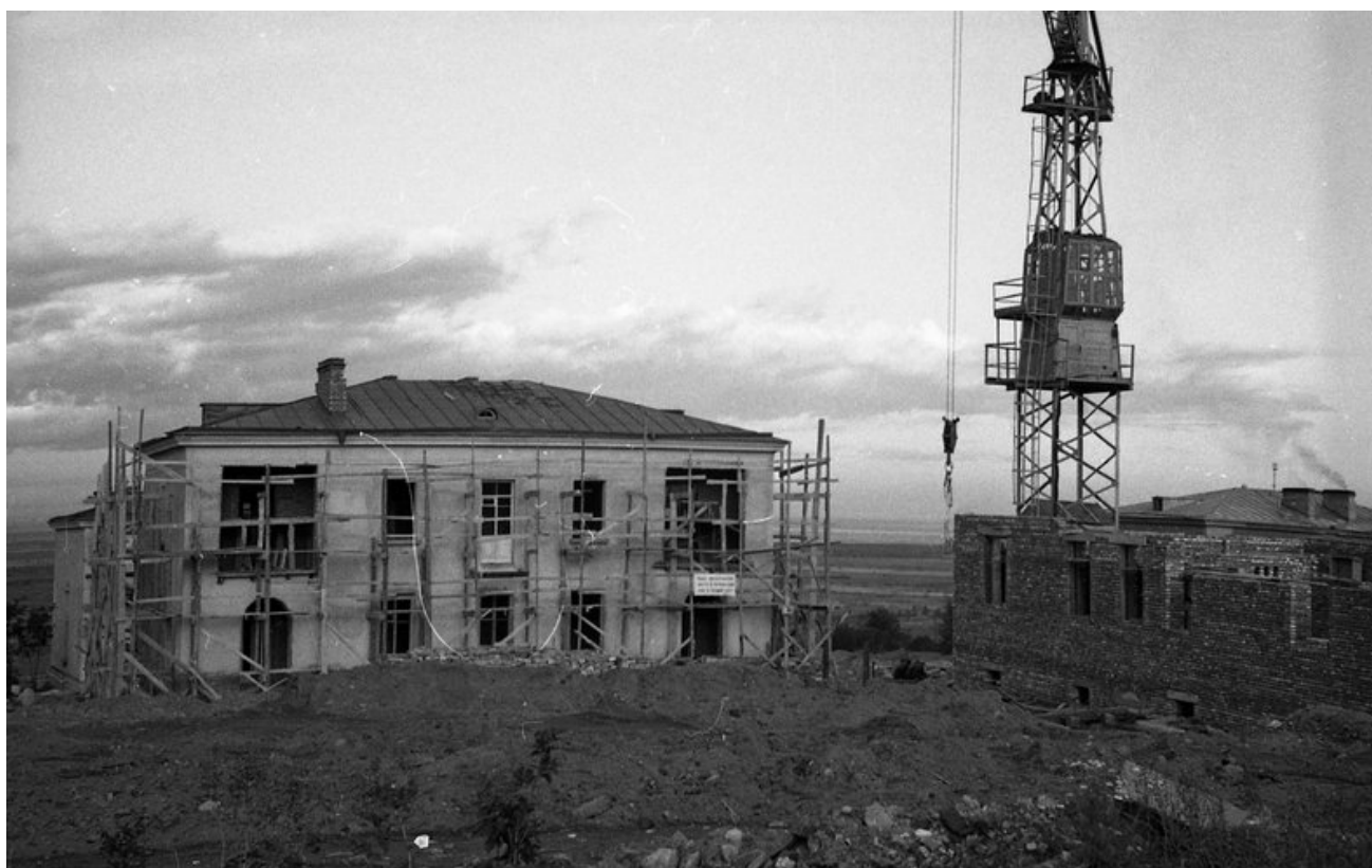
53. Строительство новых зданий в Пулковской обсерватории. Фотография. Автор фото – Луговой Г. И. 1953 г. // Источник: [Электронный ресурс] - URL: https://goskatalog.ru/portal/#/collections?id=39527246 (дата обращения: 09.07.2024).
