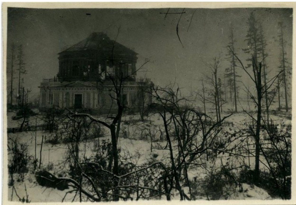
34. Разрушенная Пулковская обсерватория. 1941-1942 гг. // Источник: [Электронный ресурс] - URL: https://goskatalog.ru/portal/#/collections?id=28864468 (дата обращения: 09.07.2024).
