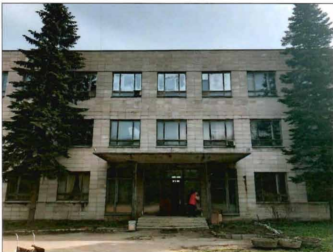
1. Западный фасад. Фрагмент.
