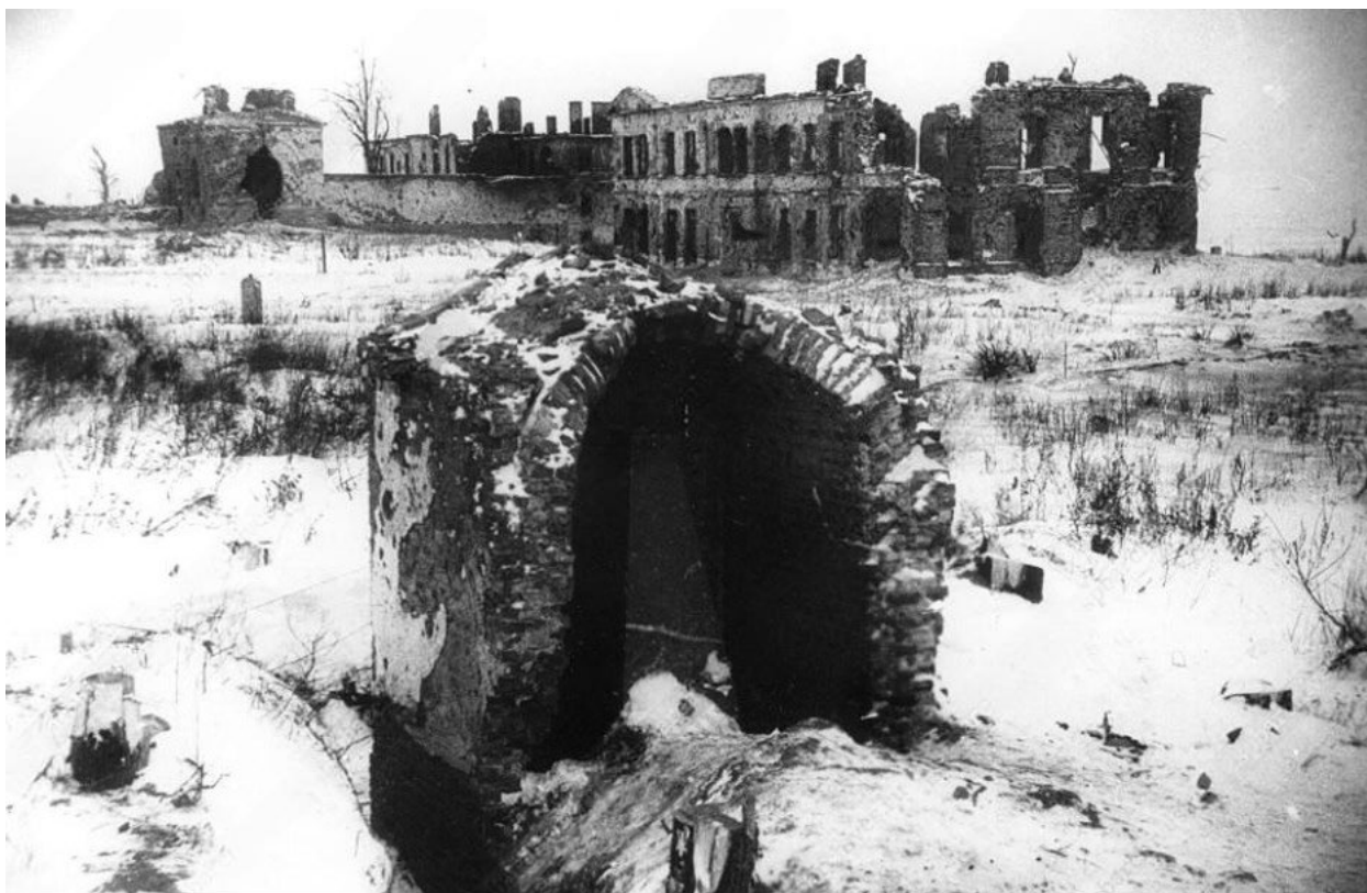
38. Здание Пулковской обсерватории, разрушенное немецкими вандалами. 14 января 1944 г. Фотография. Автор фото – Чертов Г. И. // Источник: ЦГАКФФД СПб. Фотодокументы. Опись 1АР-129. Ед.хр.174460.
