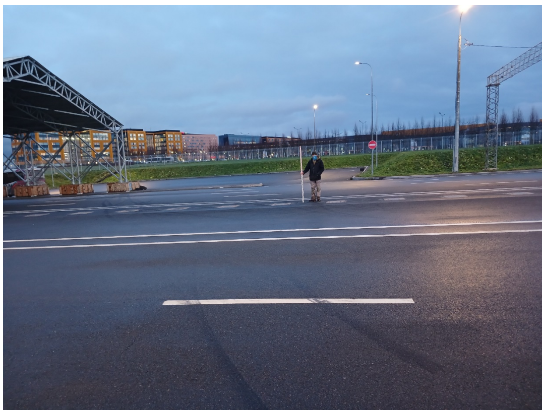
Рис. 34. Санкт-Петербург, ул. Соколиная, участок от КВЦ «Экспофорум» до северо-западной границы квартала №1. Общий вид участка обследования. Точка съемки 9. Вид на север
