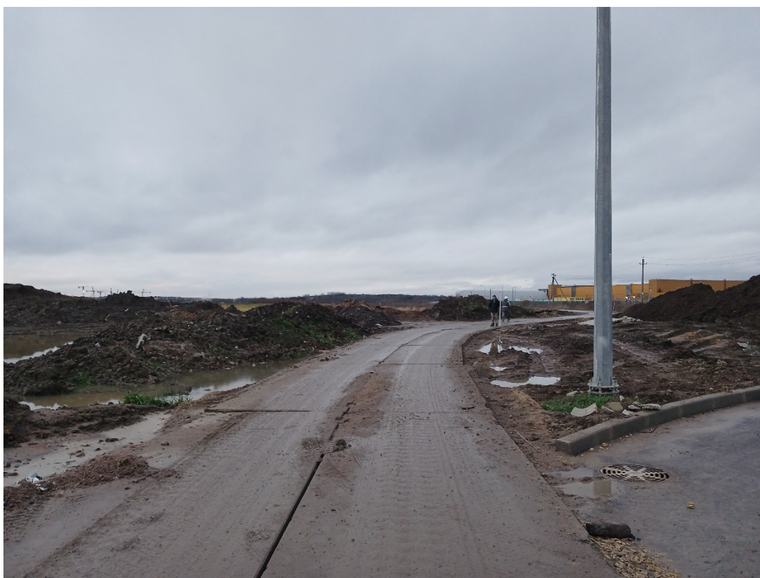
Рис. 26. Санкт-Петербург, ул. Соколиная, участок от КВЦ «Экспофорум» до северо-западной границы квартала №1. Общий вид участка обследования. Точка съемки 4. Вид на северо-запад
