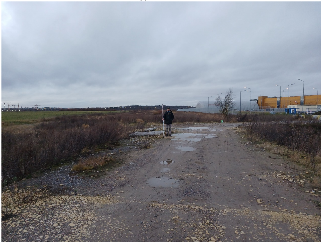
Рис. 27. Санкт-Петербург, ул. Соколиная, участок от КВЦ «Экспофорум» до северо-западной границы квартала №1. Общий вид участка обследования. Точка съемки 5. Вид на северо-запад
