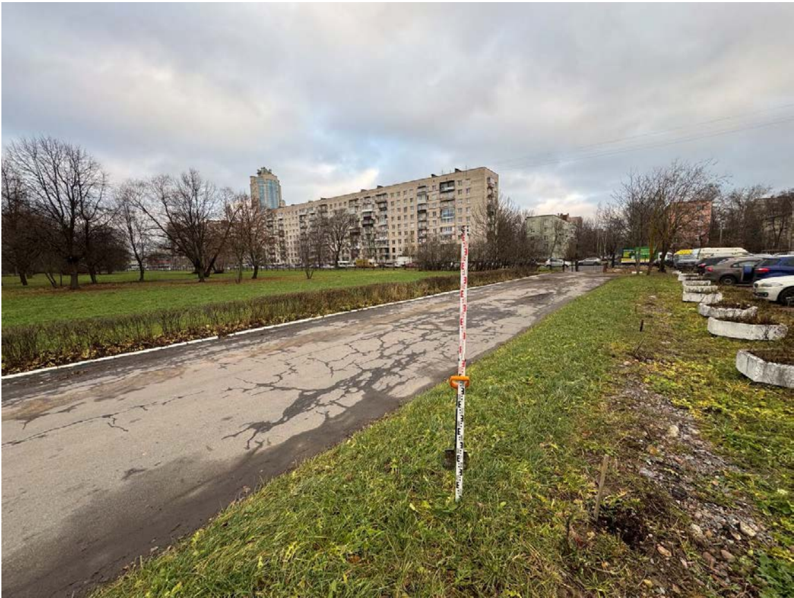
Рис. 68. Санкт-Петербург, Кировский район, м.о. Улянка. Точка съёмки 16. Общий вид участка обследования. Вид с Ю.
