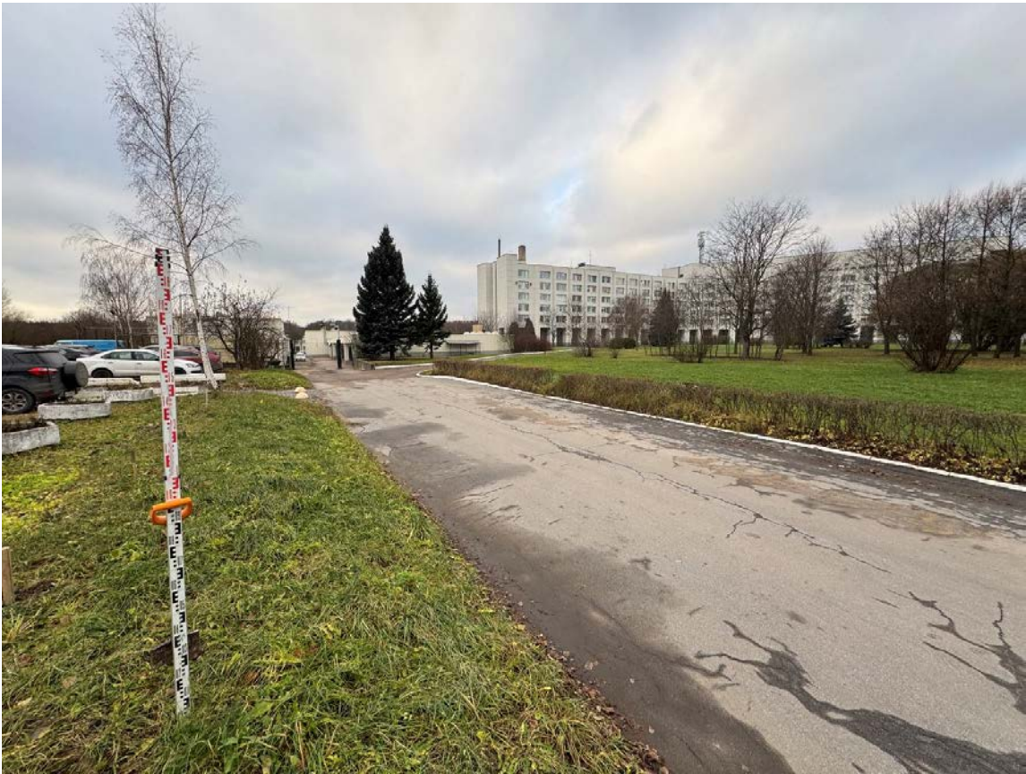
Рис. 66. Санкт-Петербург, Кировский район, м.о. Ульяновка. Точка съёмки 16. Общий вид участка обследования. Вид с СВ.
