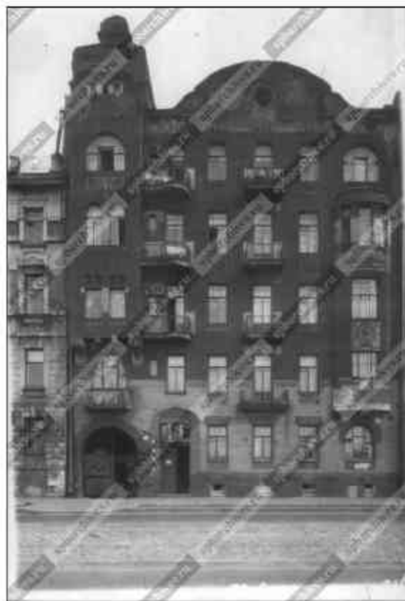
17. Натурная съёмка. Лицевой фасад дома №21а на проспекте Добролюбова. Архитектор Порубиновский Н.Я., 1961 г. // Архив ЦГА КФД. Гр 74035.
