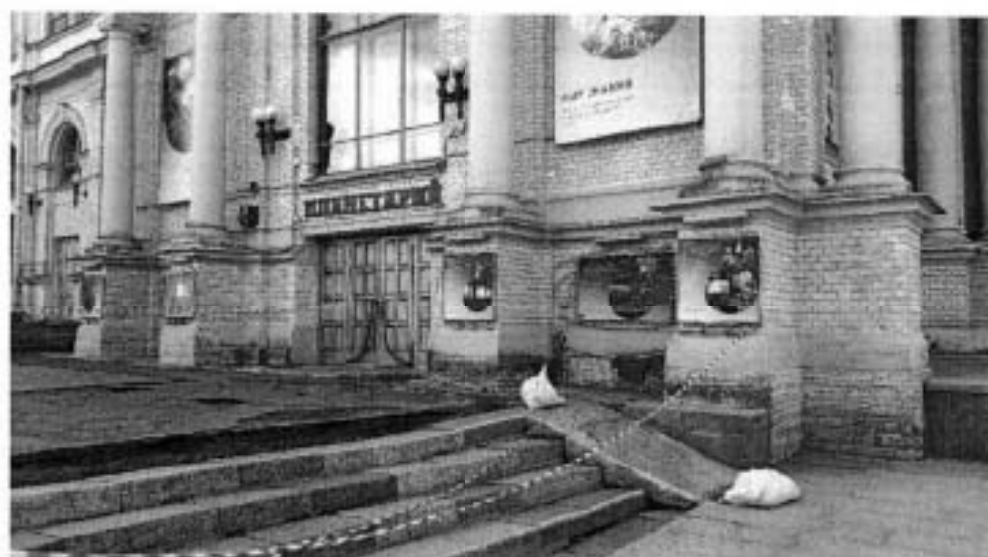
Фото 3. Стилюбат и лестница на входе со стороны ризалита северного фасада объекта культурного наследия
