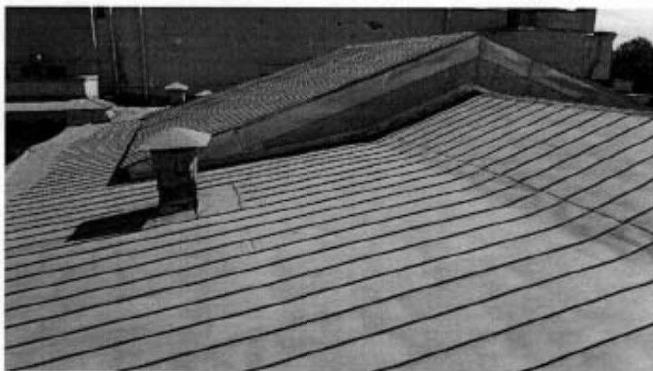
Фото 8. Крыша объекта культурного наследия
