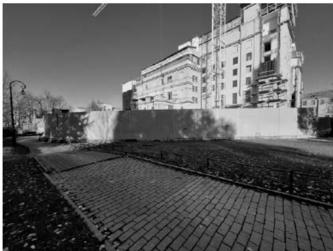
Фото 19. Вид со стороны Александровского парка на западный фасад здания - объекта культурного наследия федерального значения «Народный дом, где в мае 1917 г. состоялся 1-й Всероссийский съезд крестьянских депутатов. Здесь в Оперном зале выступали певцы Собинов Л. В., Шаляпин Ф. И.».
