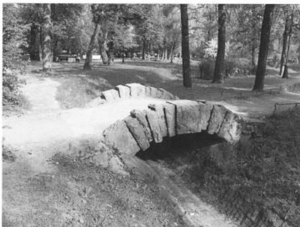
17. Мостик с гранитным фасадом арки в восточной части парка.
