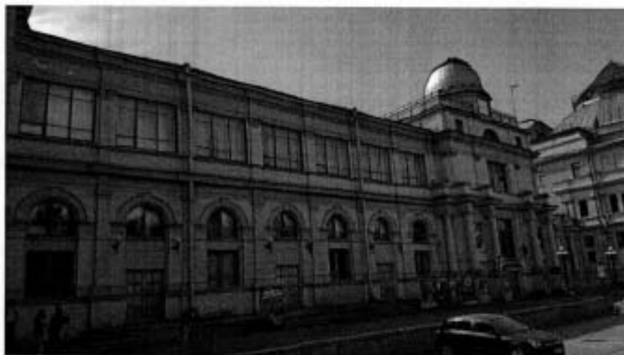
Фото 1. Северный фасад объекта культурного наследия
