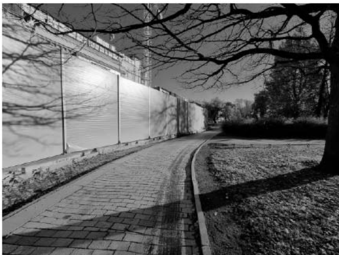
Фото 16. Вид со стороны Александровского парка на западный фасад здания – объекта культурного наследия федерального значения «Народный дом, где в мае 1917 г. состоялся 1-й Всероссийский съезд крестьянских депутатов. Здесь в Оперном зале выступали певцы Собинов Л. В., Шаляпин Ф. И.».
