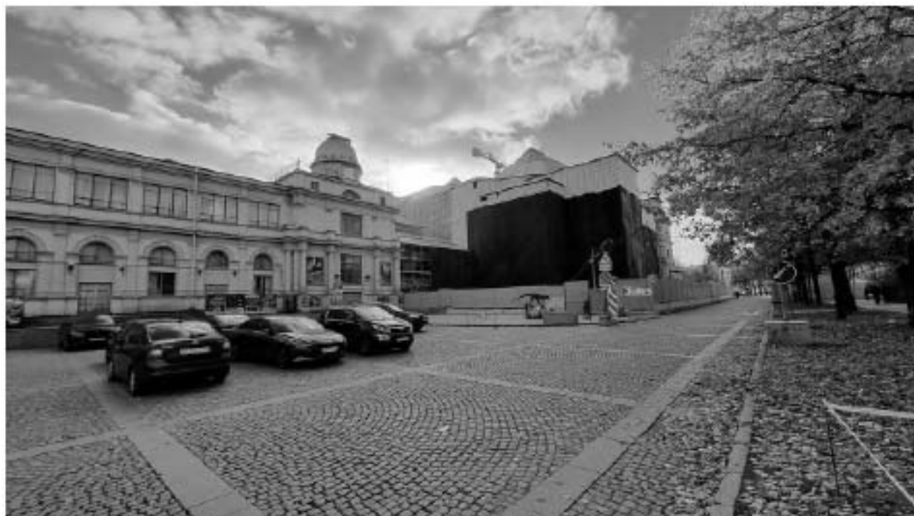
Фото 7. Вид со стороны Александровского парка на северный фасад здания – объекта культурного наследия регионального значения «Корпус с залом для увеселений и чтений ("Железный зал")» (слева), на северо-восточную часть здания – объекта культурного наследия федерального значения «Народный дом, где в мае 1917 г. состоялся 1-й Всероссийский съезд крестьянских депутатов. Здесь в Оперном зале выступали певцы Собинов Л. В., Шаляпин Ф. И.» (справа). Фото от 10.10.2024 г.
