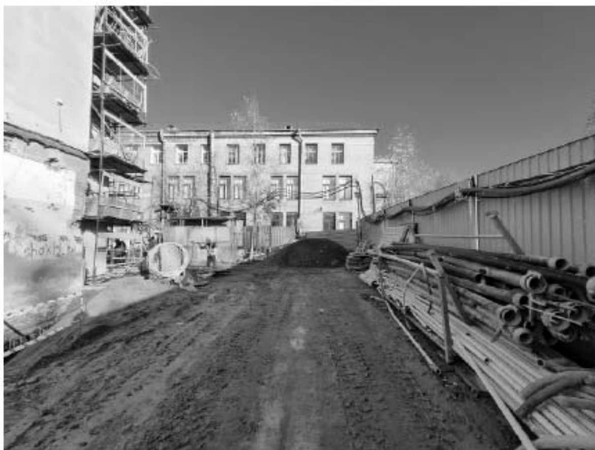
Фото 21. Вид на южный фасад здания - объекта культурного наследия федерального значения «Народный дом, где в мае 1917 г. состоялся 1-й Всероссийский съезд крестьянских депутатов. Здесь в Оперном зале выступали певцы Собинов Л. В., Шаляпин Ф. И.» (на переднем плане), на юго-западную часть здания - объекта культурного наследия регионального значения «Корпус со столовой и кухней» (на заднем плане), расположенные вдоль Кронверкского канала. Фото от 10.10.2024 г.
