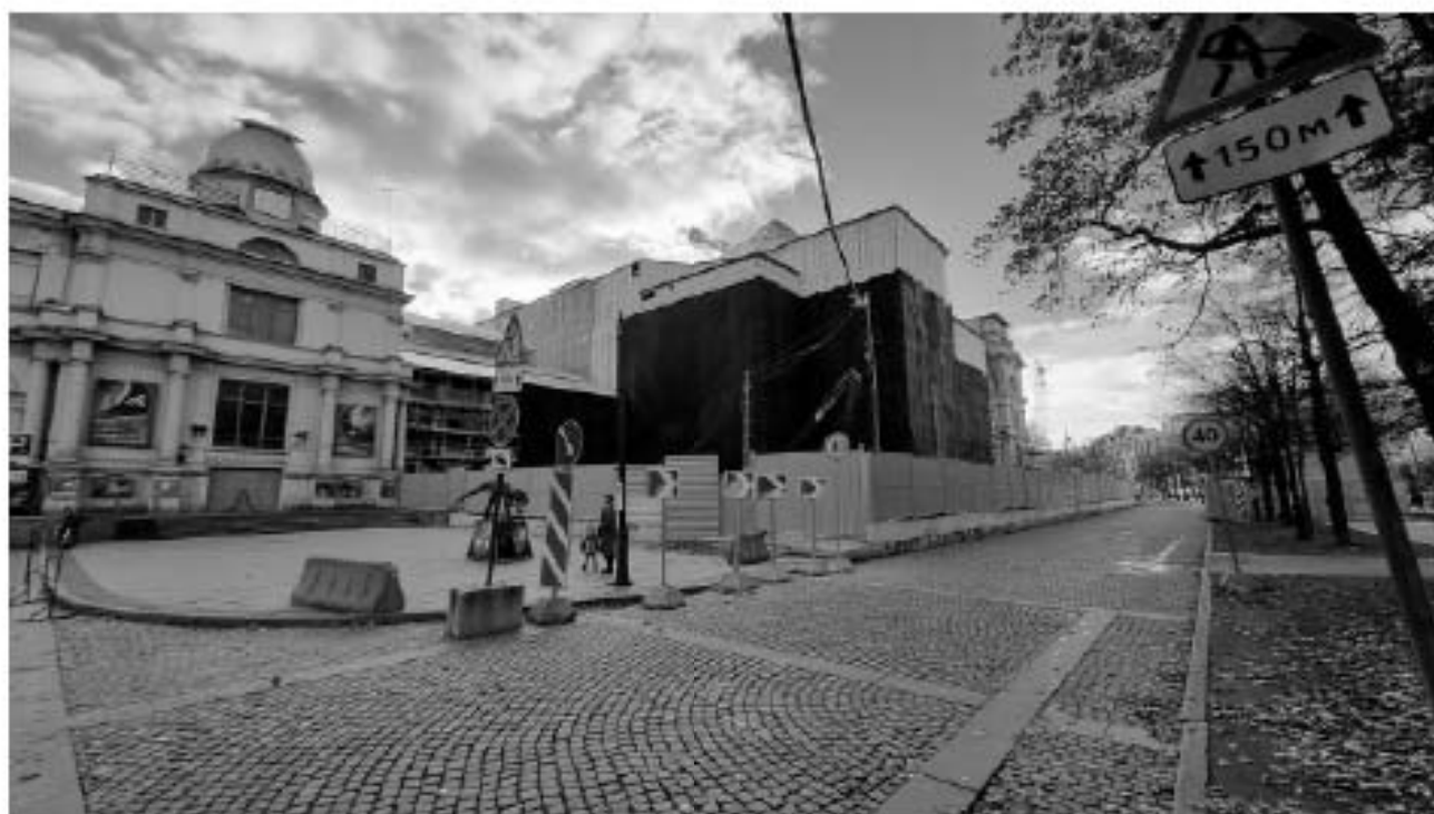
Фото 9. Вид со стороны Александровского парка на северный фасад здания – объекта культурного наследия регионального значения «Корпус с залом для увеселений и чтений ("Железный зат")» (слева), на северо-восточную часть здания – объекта культурного наследия федерального значения «Народный дом, где в мае 1917 г. состоялся 1-й Всероссийский съезд крестьянских депутатов. Здесь в Оперном зале выступали певцы Собинов Л. В., Шаляпин Ф. И.» (справа). Фото от 10.10.2024 г.
