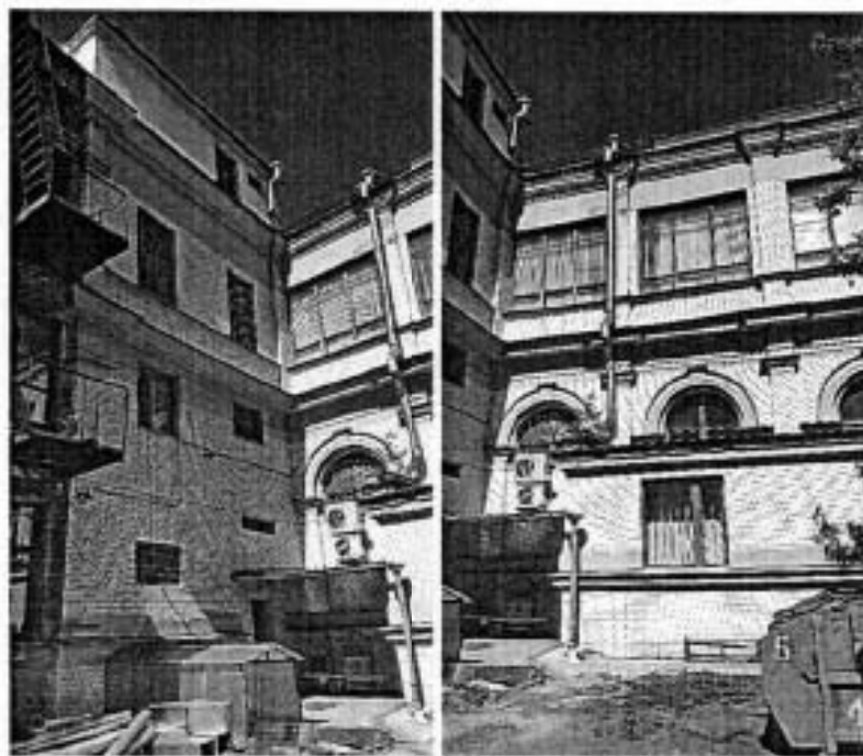
Фото 11, 12. Дворовой фасад объекта культурного наследия
