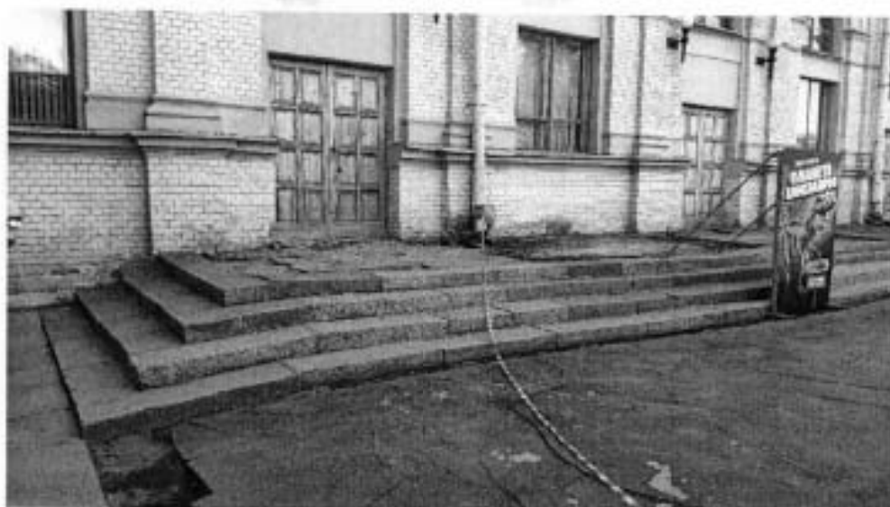
Фото 2. Стилюбат и лестница на входе со стороны северного фасада объекта культурного наследия
