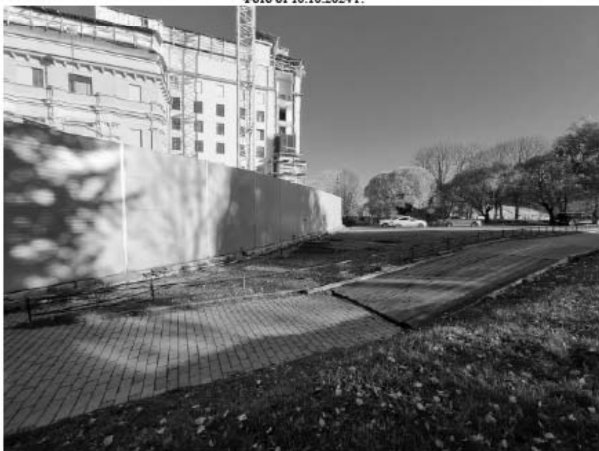
Фото 18. Вид со стороны Александровского парка на западный фасад здания - объекта культурного наследия федерального значения «Народный дом, где в мае 1917 г. состоялся 1-й Всероссийский съезд крестьянских депутатов. Здесь в Оперном зале выступали певцы Собинов Л. В., Шаляпин Ф. И.».
