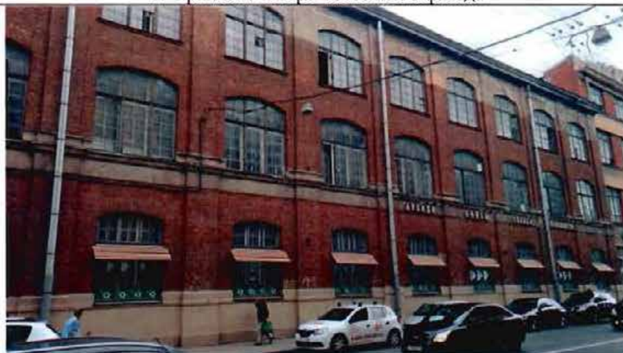
2. Фрагмент северо-западного фасада
