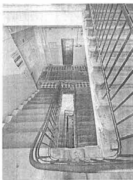
21. Служебная лестница объекта культурного наследия
