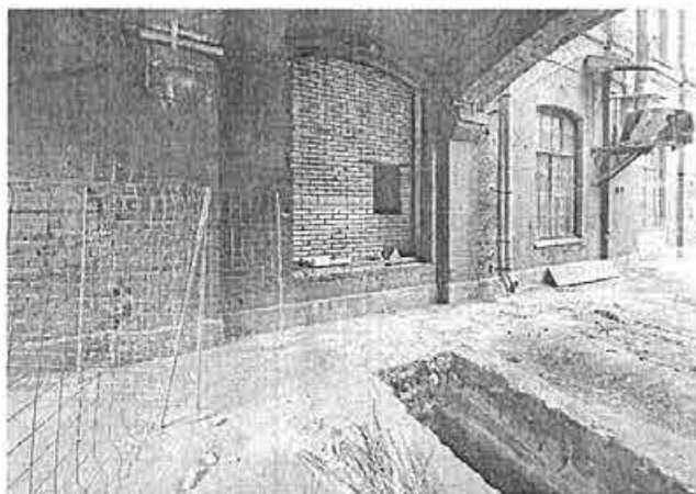
8. Северный проезд (между трехэтажным и двухэтажным корпусом)
