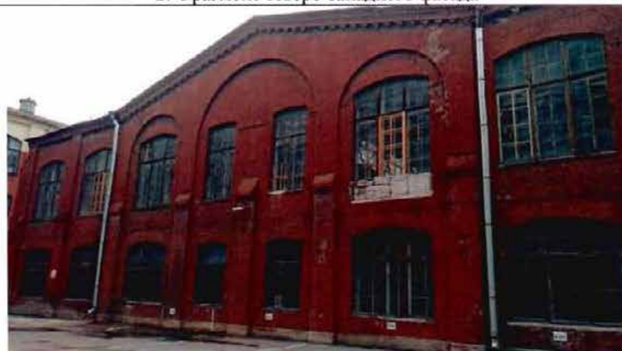
3. Фрагмент юго-западного фасада
