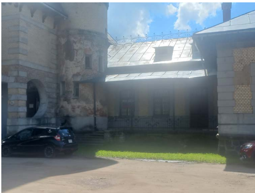
Фото 12. ОКН «Больница общины Святого Георгия» по адресу: г. Санкт-Петербург, г. Красное Село, пр. Двадцать Пятого Октября, д. 105, лит.А, Северный фасад. Дата съемки 10.09.2024
