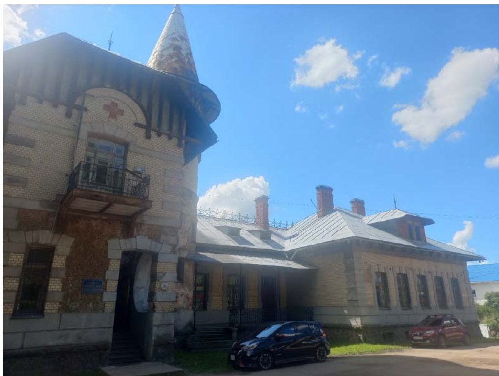
Фото 9. ОКН «Больница общины Святого Георгия» по адресу: г. Санкт-Петербург, г. Красное Село, пр. Двадцать Пятого Октября, д. 105, лит.А, Северный фасад. Дата съемки 10.09.2024
