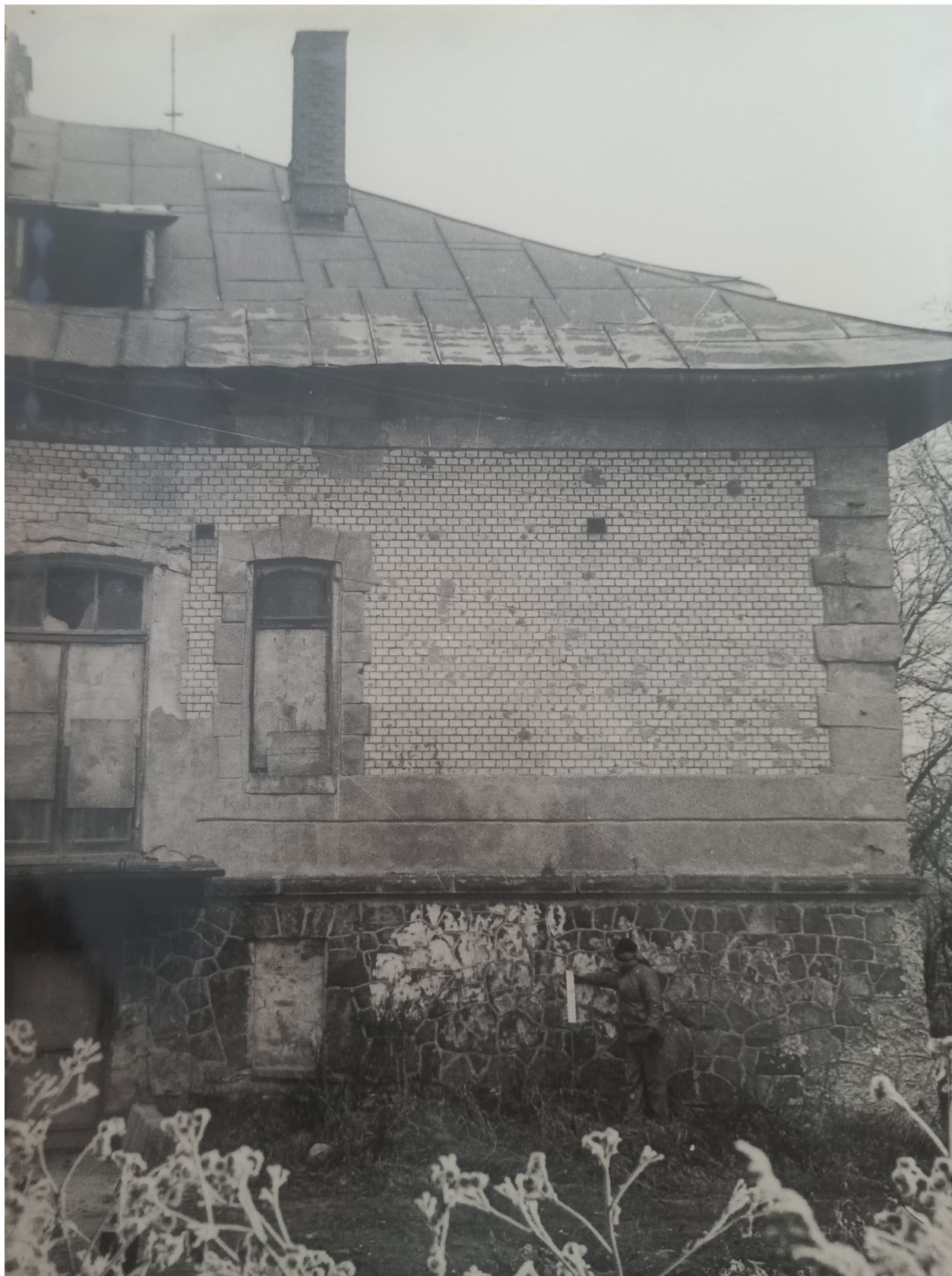
16.8 Западный фасад. Фрагмент.
