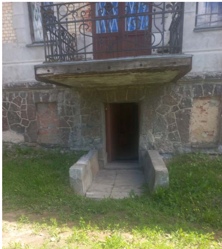
Фото 3. ОКН «Больница общины Святого Георгия» по адресу: г. Санкт-Петербург, г. Красное Село, пр. Двадцать Пятого Октября, д. 105, лит.А, Западный фасад, вход в подвал. Дата съемки 10.09.2024
