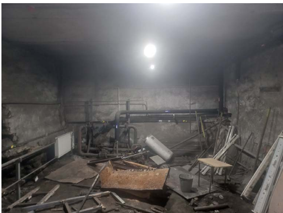
Фото 15. ОКН «Больница общины Святого Георгия» по адресу: г. Санкт-Петербург, г. Красное Село, пр. Двадцать Пятого Октября, д. 105, лит.А, Помещение 2-Н . Дата съемки 10.09.2024
