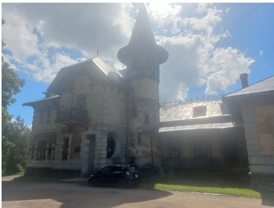
Фото 10. ОКН «Больница общины Святого Георгия» по адресу: г. Санкт-Петербург, г. Красное Село, пр. Двадцать Пятого Октября, д. 105, лит.А, Северный фасад. Дата съемки 10.09.2024
