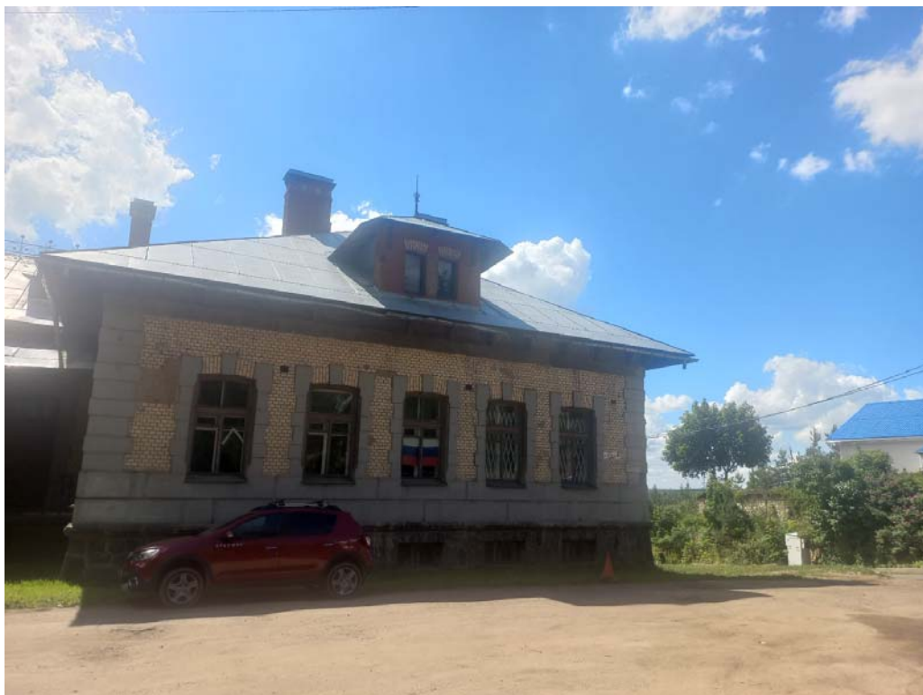
Фото 11. ОКН «Больница общины Святого Георгия» по адресу: г. Санкт-Петербург, г. Красное Село, пр. Двадцать Пятого Октября, д. 105, лит.А, Западный фасад. Дата съемки 10.09.2024
