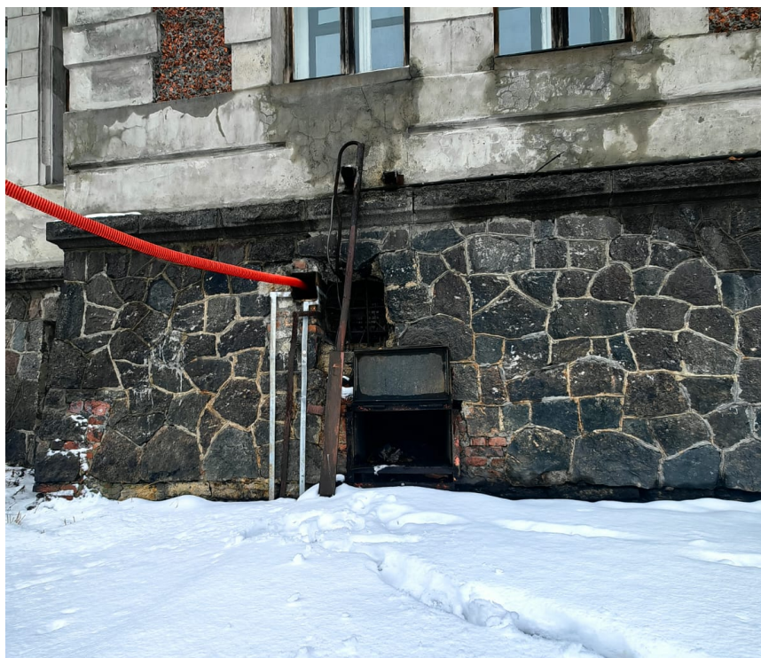
Фото 16. ОКН «Больница общины Святого Георгия» по адресу: г. Санкт-Петербург, г. Красное Село, пр. Двадцать Пятого Октября, д. 105, лит.А, Южный фасад. Дата съемки 09.01.2025
