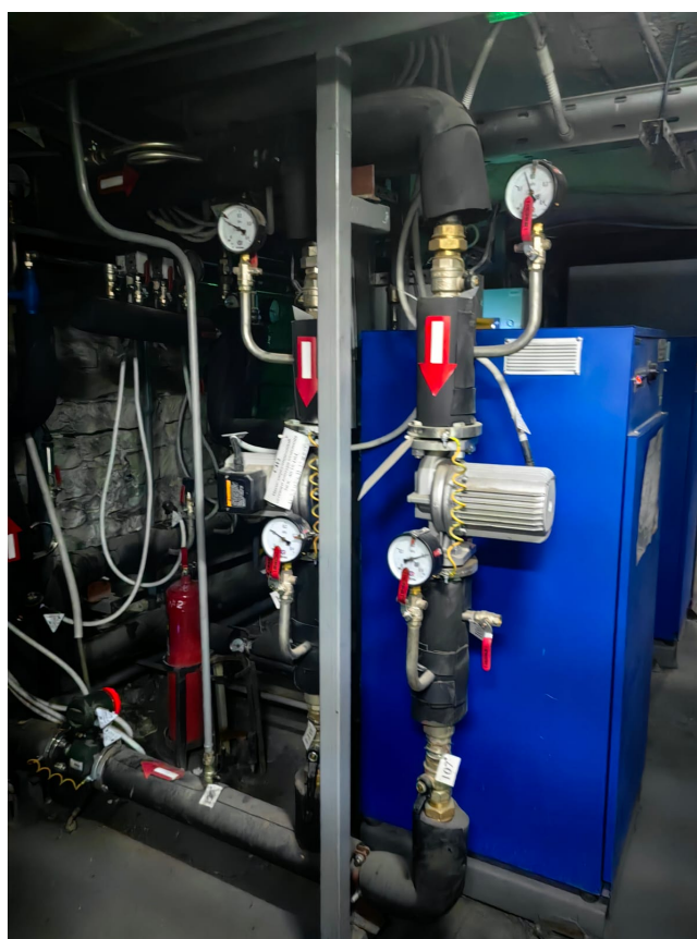
Фото 24. ОКН « Больница общины Святого Георгия» по адресу: г. Санкт-Петербург, г. Красное Село, пр. Двадцать Пятого Октября, д. 105, лит.А, помещение 1-Н. Дата съемки 09.01.2025
