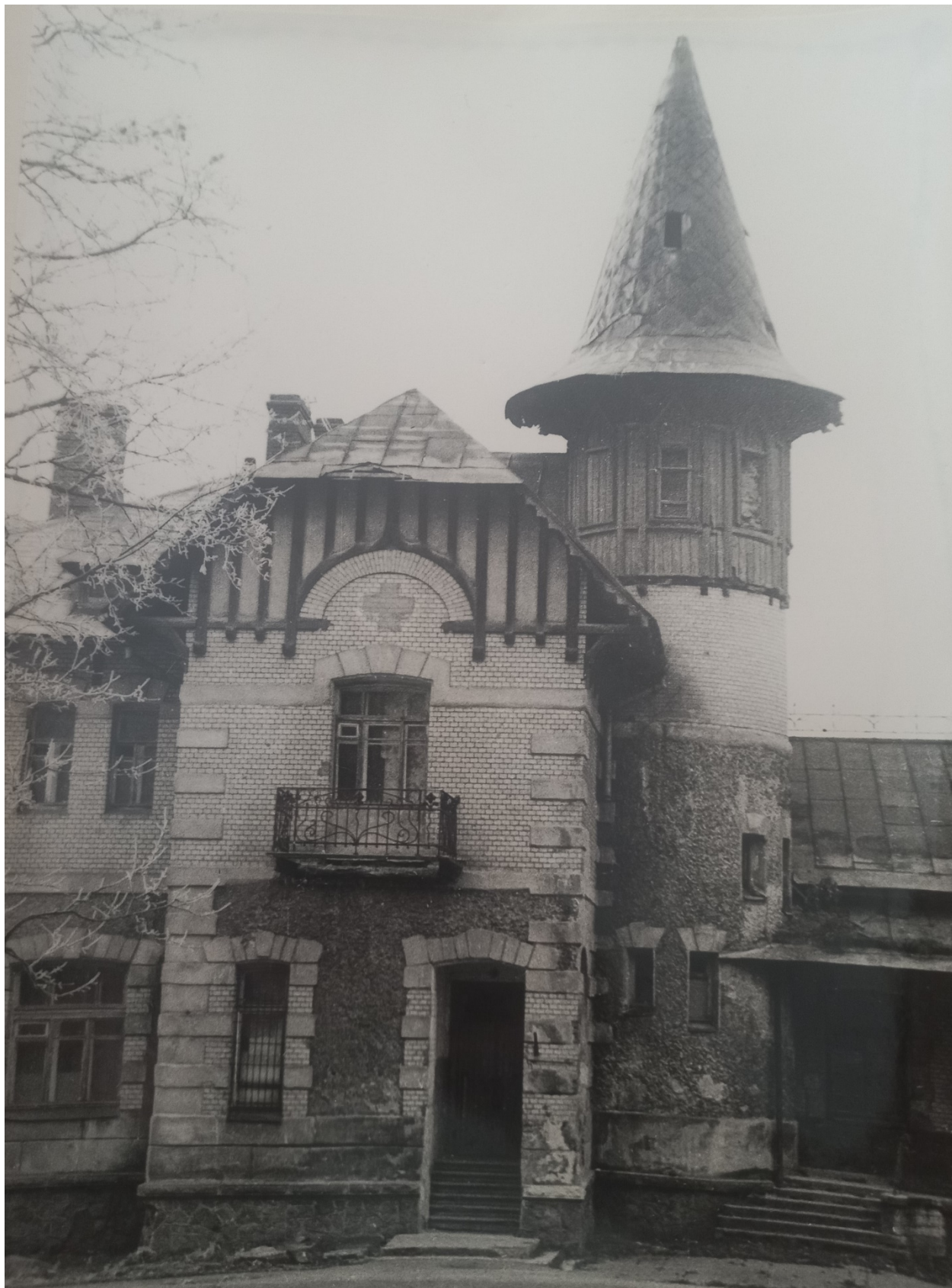
16.3 Северный фасад. Главный вход.
