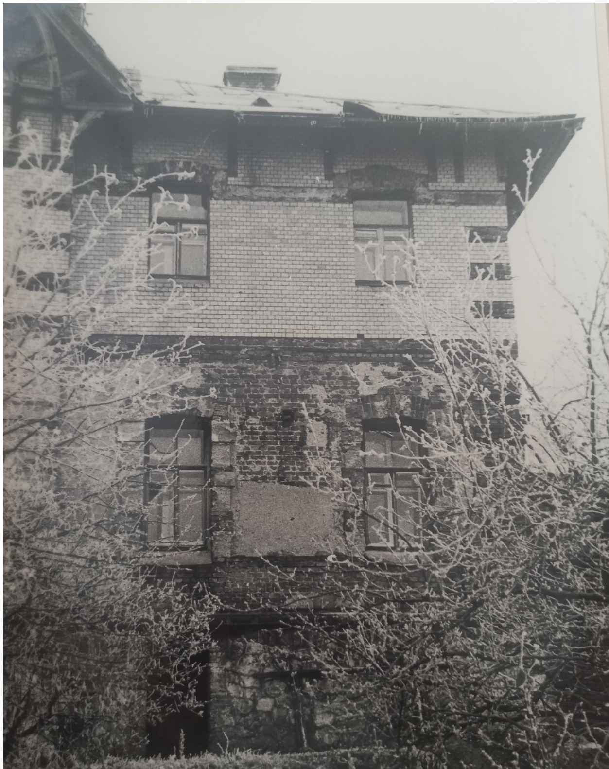
16.7 Южный фасад. Фрагмент.
