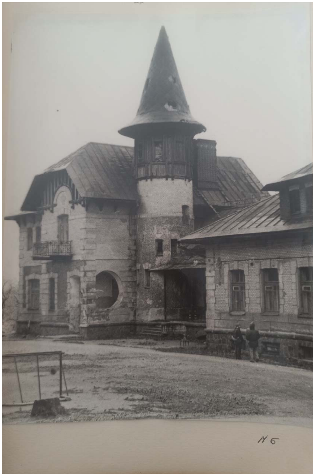
16.1 Общий вид северного фасада (начало)
