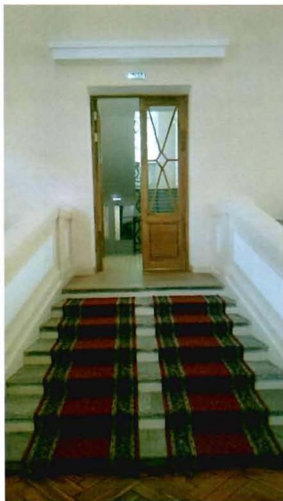
9. Дверной проем декорированный линейным сандриком в актовом зале.
