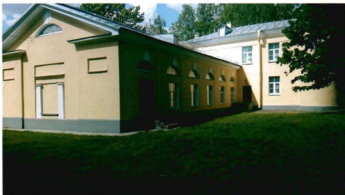
7. Северный лицевой фасад западного флигеля.
