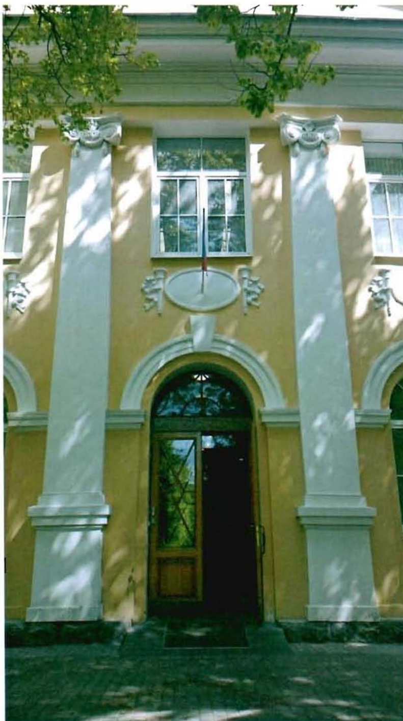
1. Дверной проем центрального ризалита южного лицевого фасада.
