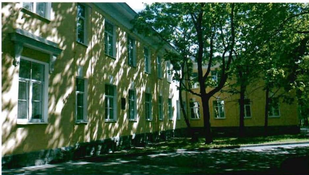
2. Фрагмент южного лицевого фасада.
