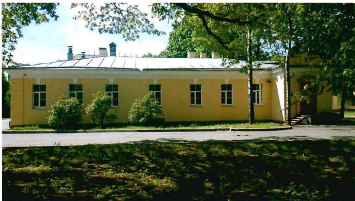
6. Северный лицевой фасад восточного флигеля.
