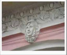
оформление оконных проемов 1-4 этажей: замковые камни с маскаронами. профилированные наличники, межэтажные филенки второго-третьего и третьего-четвертого этажей в оконных осях с лепными композициями в характере модерна, прямые сандрики оконных проемов третьего этажа;
