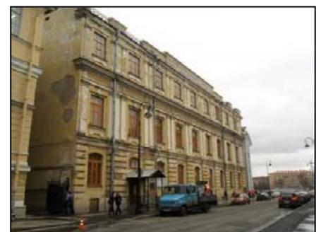
простенках окон; над вторым и третьим этажами – антаблемента с профилированными карнизами; оконные проемы оформлены заглубленными филенками снизу и замковыми камнями сверху; широкий оштукатуренный аттик над венчающим карнизом, по сторонам от него – парапетное ограждение в виде ажурной кованой ограды геометрического рисунка (круги);
