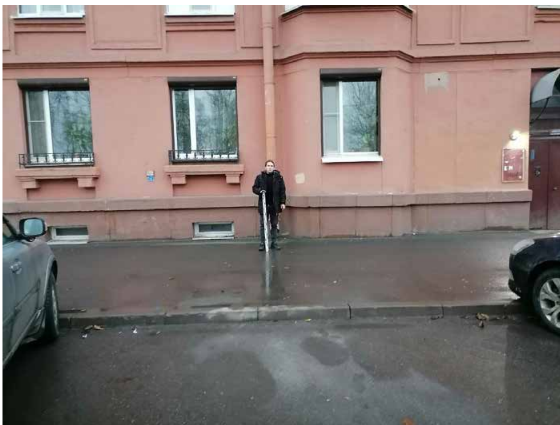
Рис. 16. Санкт-Петербург, Московский район, Бассейная улица, дом 59, корп. 2, лит. А. Точка фотофиксации № 6.
