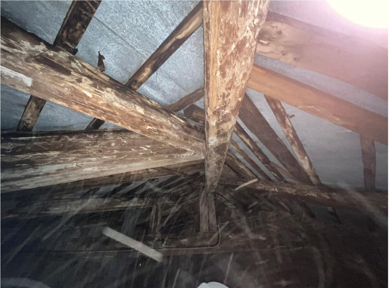
**Фото №9.** Чердачное пространство, фрагмент стропильной системы.
