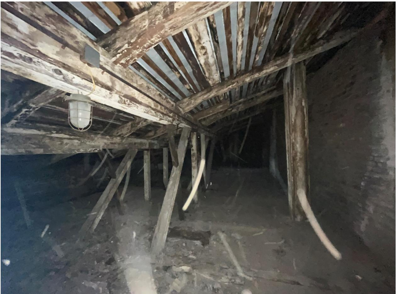
Фото №8. Чердачное пространство, фрагмент стропильной системы.
