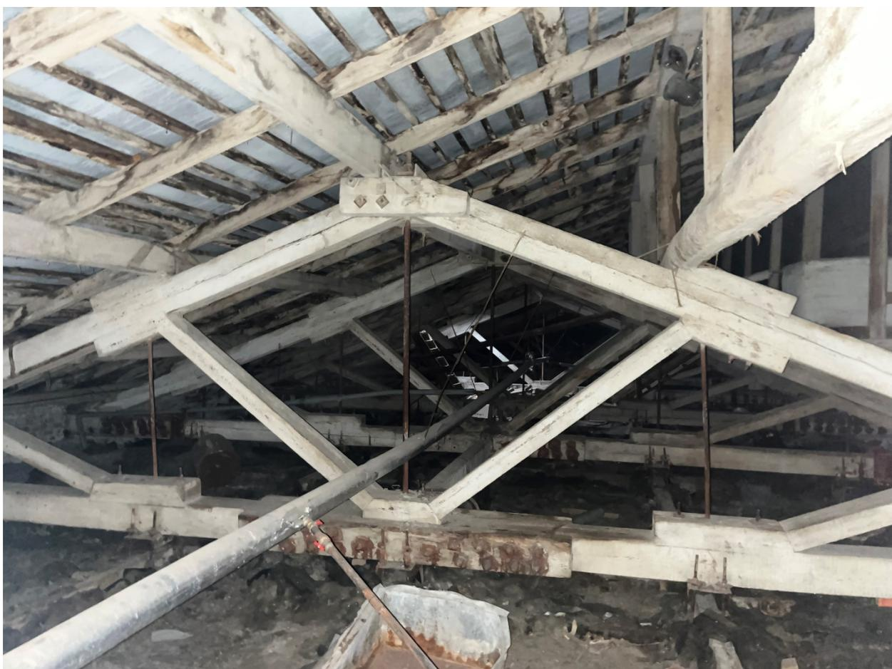
Фото №17. Чердачное пространство, фрагмент стропильной системы.
