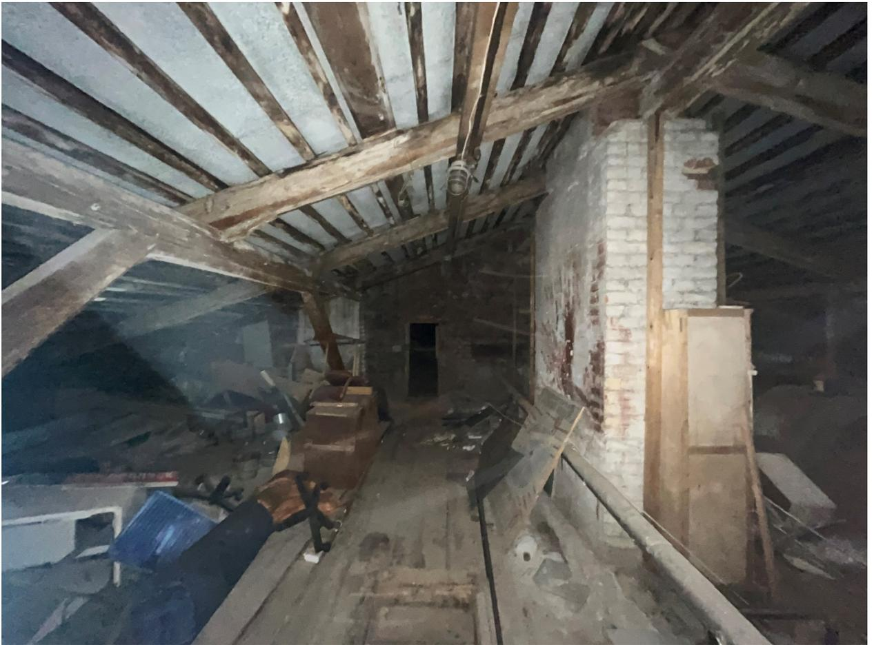
Фото №20. Чердачное пространство, фрагмент стропильной системы.
