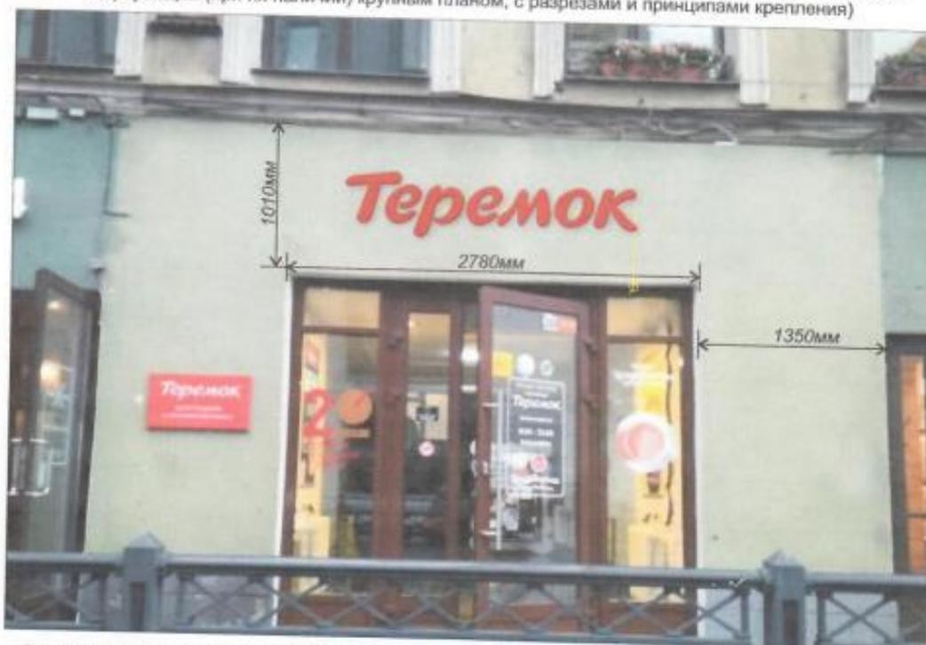
Световые объемные буквы, светится лицевая панель. Лицо - акрил 3 мм, пленка Оракал 8500; боковины - пластик пвх 3мм, пленка Оракал 641, задник - пвх 5мм. Подсветка осуществляется светодиодными кластерами. Монтаж элементов осуществляется через металлоконструкцию на шпильки вплотную к фасаду.
