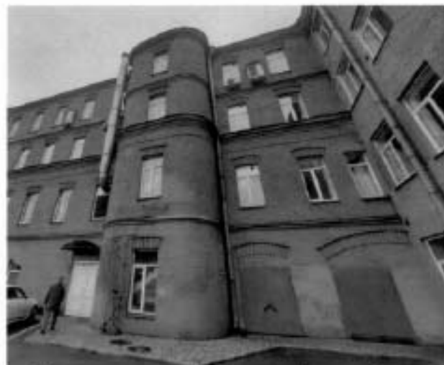
6. Фрагмент дворового южного фасада объекта культурного наследия
