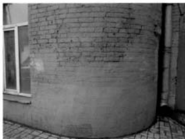
10. Фрагмент дворового южного фасада объекта культурного наследия
