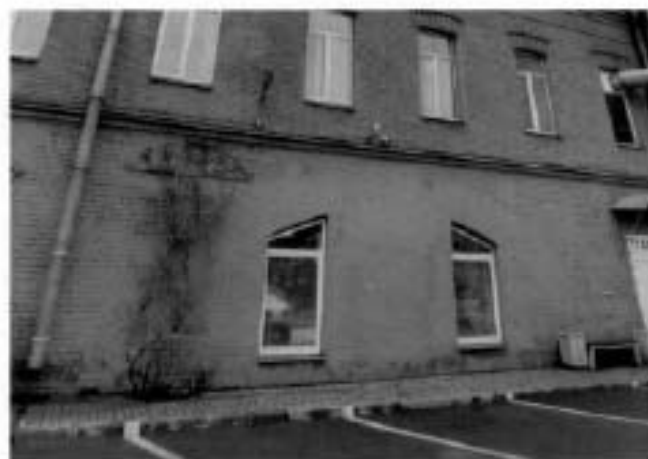
8. Фрагмент дворового южного фасада объекта культурного наследия
