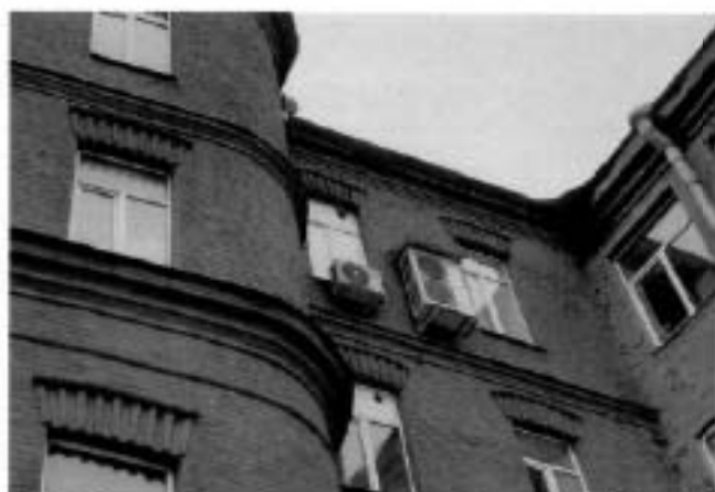
11. Фрагмент дворового южного фасада объекта культурного наследия. Дополнительное оборудование
