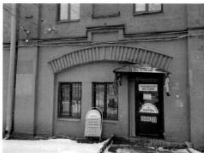
3. Фрагмент лицевого северного фасада объекта культурного наследия
