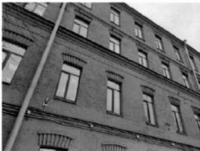
5. Фрагмент лицевого северного фасада объекта культурного наследия
