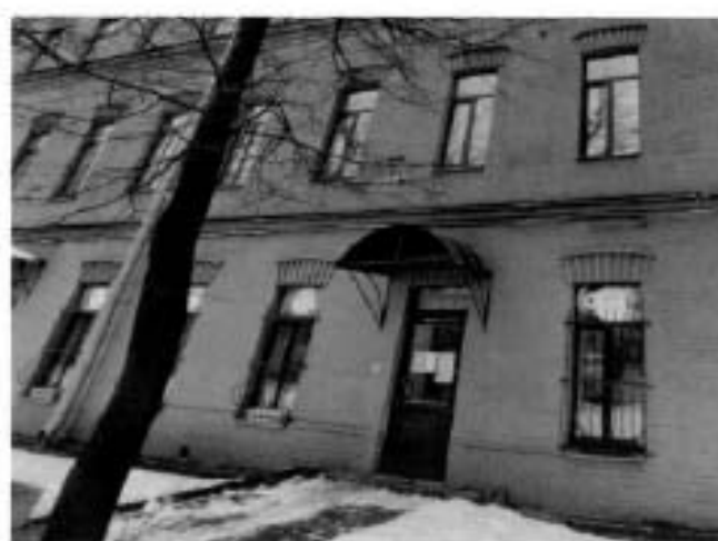
4. Фрагмент лицевого северного фасада объекта культурного наследия
