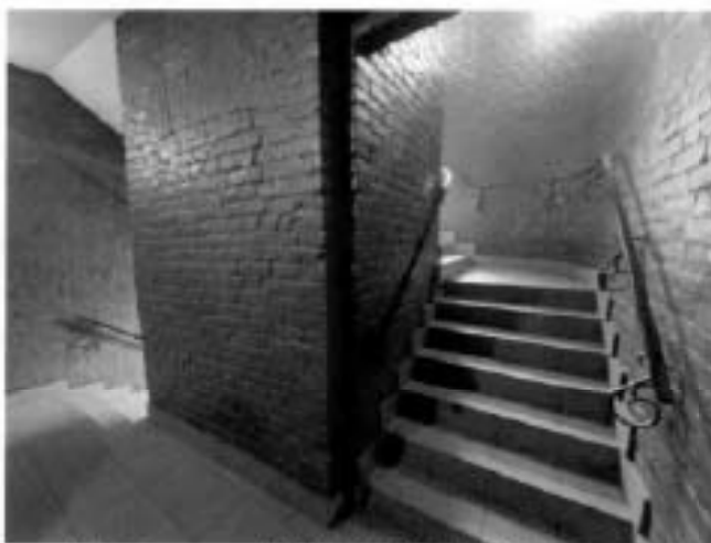
19. Лестница 1ЛК (II, IV, V, VI) объекта культурного наследия
