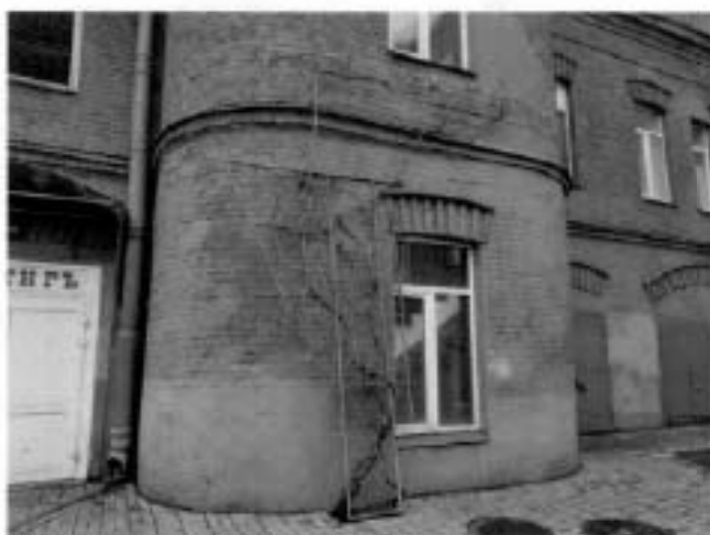
9. Фрагмент дворового южного фасада объекта культурного наследия
