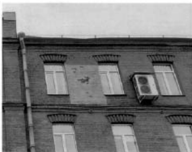
7. Фрагмент дворового южного фасада объекта культурного наследия. Дополнительное оборудование
