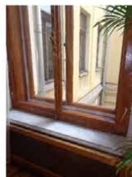
оконные приборы (четыре) – материал (бронза), конструкция (шпингалеты длинные, поворотные, с круглой ручкой-кнопкой, в форме розетты);
