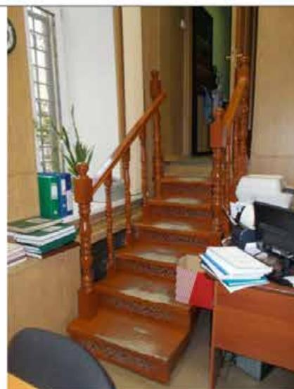
с деревянными профилированными ступенями; подступенки с ажурными резными композициями из завитков стеблей аканта;
