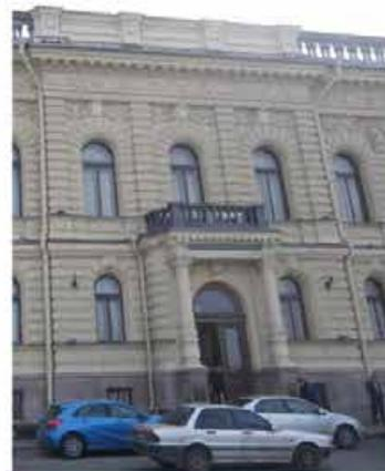
исторический дверной проем – местоположение (по 5-й световой оси), габариты, конфигурация (полуциркулярный), оформление (портал: колонны коринфского ордера с профилированным раскрепованным карнизом с модульонами, на парных кронштейнах; входной проем: профилированный архивольт с каннелированным замковым камнем с венком, в антресолях лепные композиции растительного рисунка);
