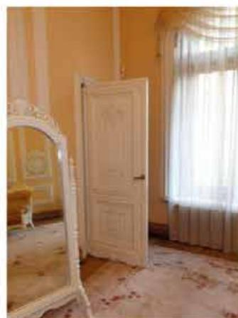
заполнение дверного проема в подсобное помещение – материал (дерево), конструкция (двери одностворчатые), оформление (профилированные прямоугольные и фигурные филенки, в верхней части с резными рокайлями и акантами);
