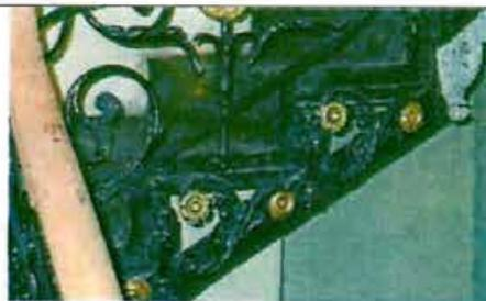
с ажурным металлическим ограждением из завитков стебля аканта с розетками; в центральных частях секций со стилизованными бутонами аканта; с профилированным деревянным поручнем;
