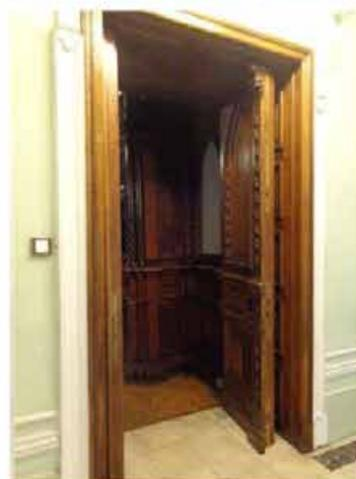
заполнение дверных проемов – двери (орех, резьба) двухстворчатые, оформление идентично оформлению шкафов и стен; двери со стороны зала подачи заявлений фанерованы красным деревом; откосы обшиты деревянными панелями с профилированными филенками;
