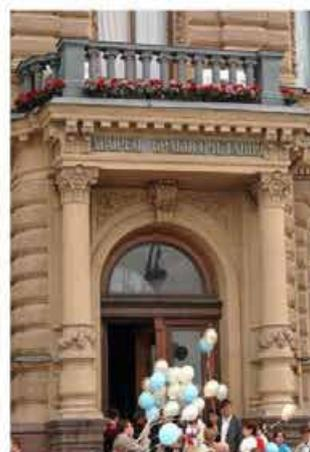
заполнение дверного проема – материал (дуб), конструкция – двери двухстворчатые, с полуциркулярной остекленной фрамугой, оформление (профилированные филенки с порезкой акантом по периметру, по три на каждой створке, верхние – остекленные, нащельник в форме пилястры);
