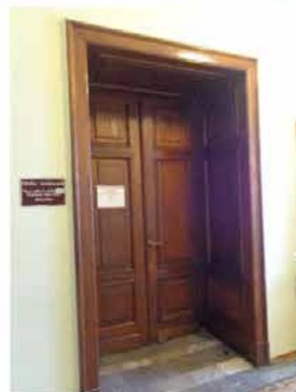
заполнение дверного проема – двери деревянные (фанеровка красным деревом), двухстворчатые, с профилированными филенками по три на каждом полотне, со стороны зеленой приемной – фанеровка орехом (?);
