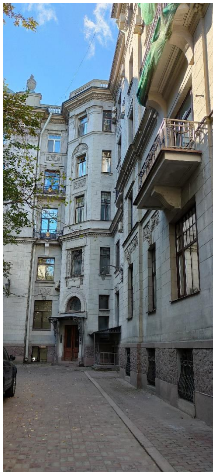
Фото 10. Фрагмент дворового фасада
