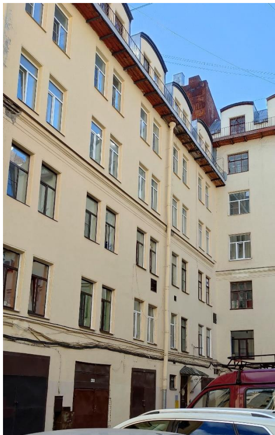
Фото 26. Фрагмент юго-западного дворового фасада
