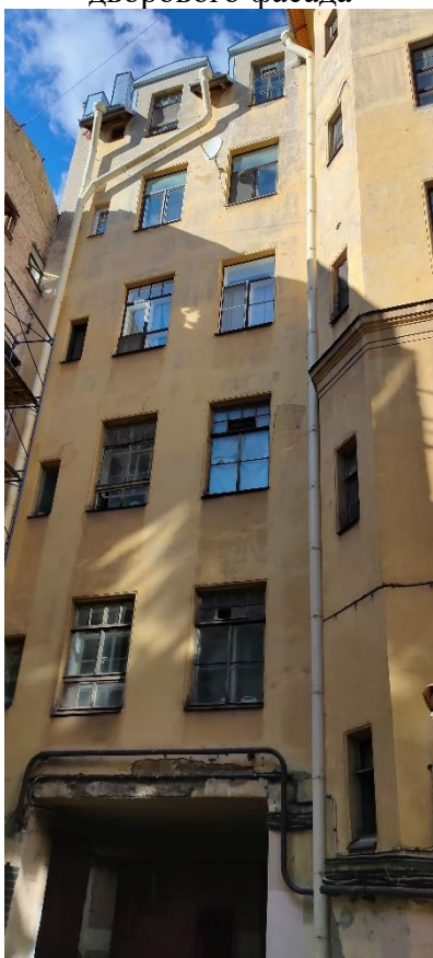
Фото 39. Фрагмент юго-восточного дворового фасада
