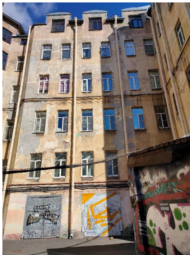
Фото 30. Фрагмент юго-западного дворового фасада
