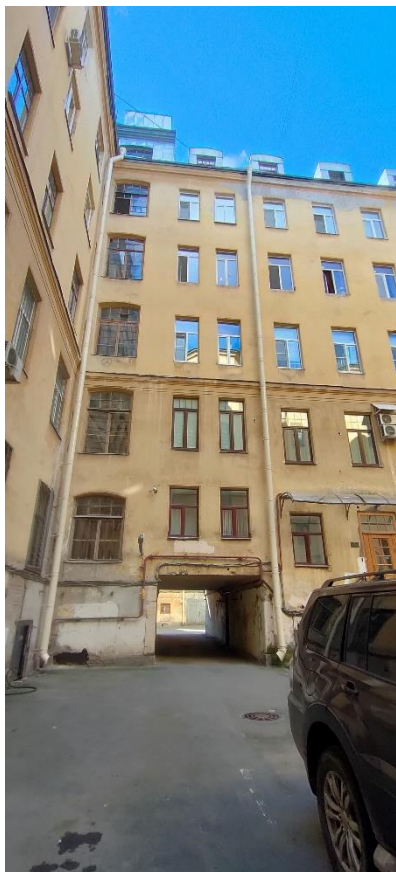
Фото 37. Фрагмент юго-восточного дворового фасада
