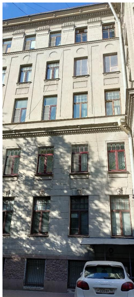
Фото 9. Фрагмент дворового фасада
