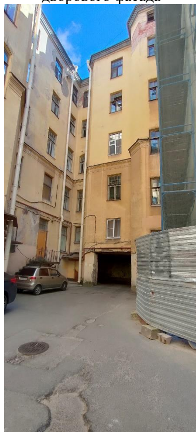
Фото 40. Фрагмент юго-восточного дворового фасада
