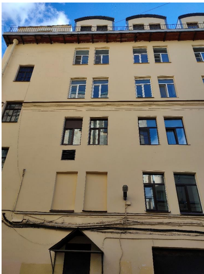
Фото 27. Фрагмент юго-западного дворового фасада
