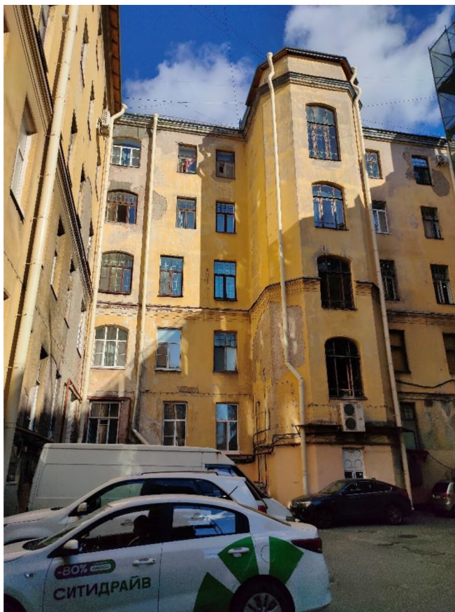
Фото 41. Фрагмент юго-восточного дворового фасада
