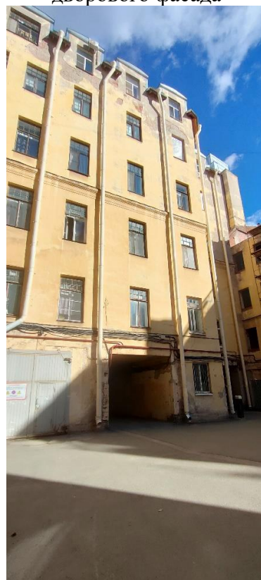
Фото 36. Фрагмент юго-восточного дворового фасада
