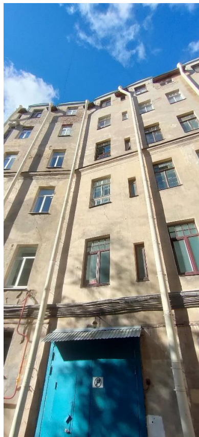
Фото 33. Фрагмент юго-восточного дворового фасада
