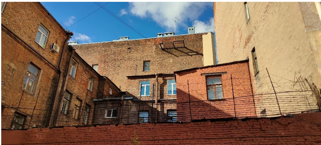
Фото 31. Фрагмент юго-западного дворового фасада
