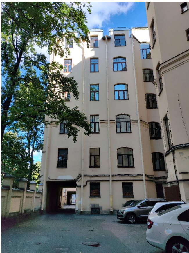
Фото 21 Фрагмент северо-западного фасада
