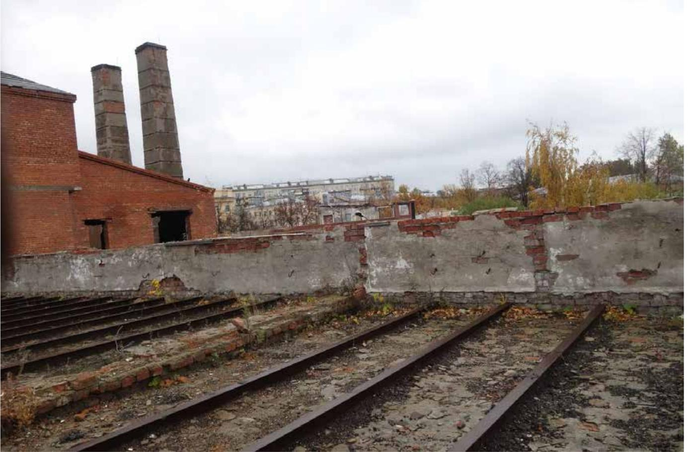
33. Кровля 3-го этажа. Надстроенный исторический парапет, аварийное перекрытие по металлическим балкам.
