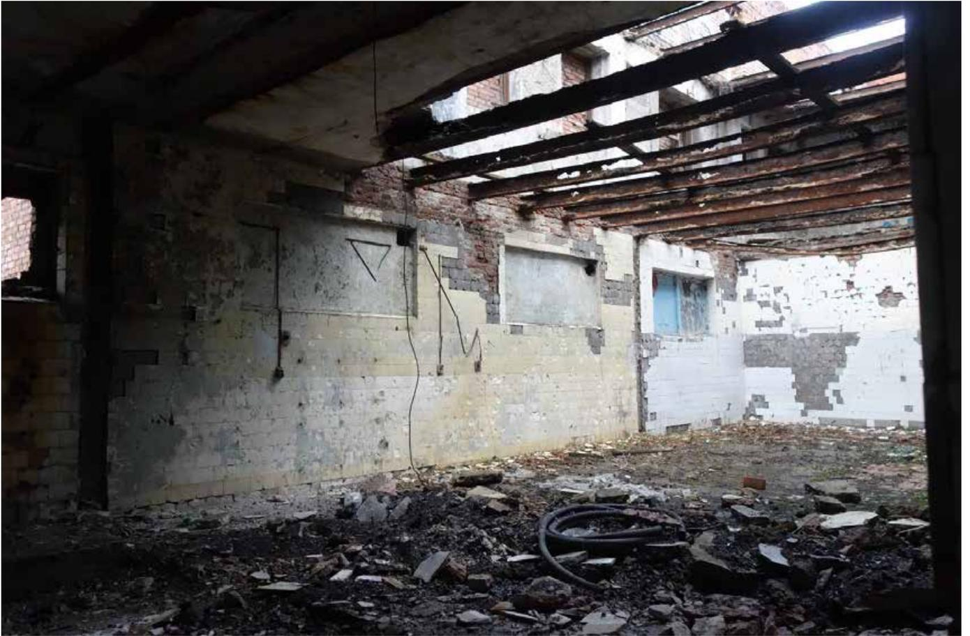
28. Помещение 2-го этажа. Несущие колонны. Деформированные аварийные балки перекрытия с обрушившимся межбалочным заполнением.
