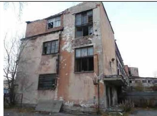
два козырька над входами в здание – местоположение (северный и восточный фасады), габариты, конфигурация (прямоугольный), тип конструкции (консольный);
