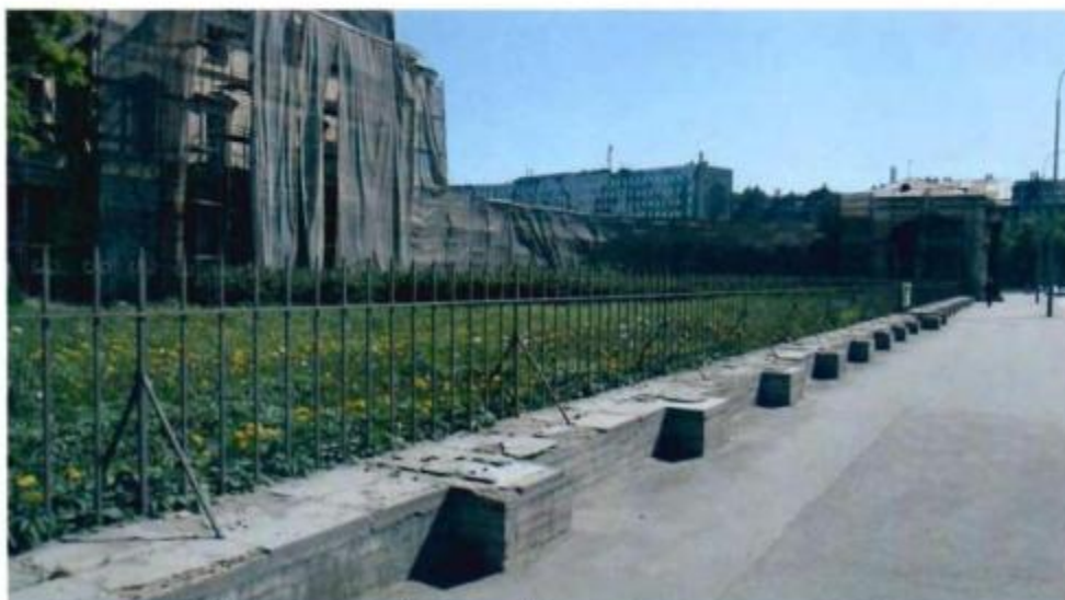
1. Известняковый цоколь объекта культурного наследия.
