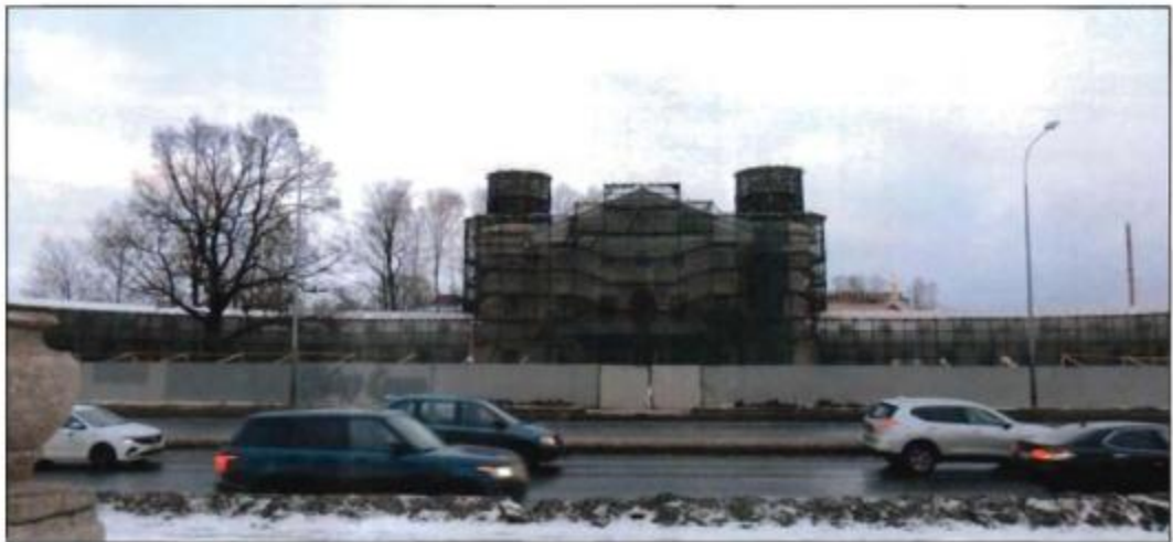
1. Южный фасад объекта культурного наследия.
