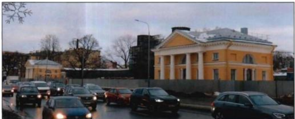
2. Общий вид объекта культурного наследия с юго-востока.
