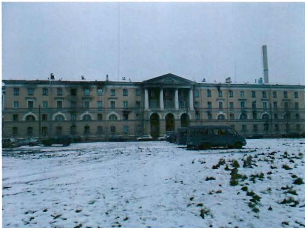
1. Лицевой фасад. Вид с юго-запада.
