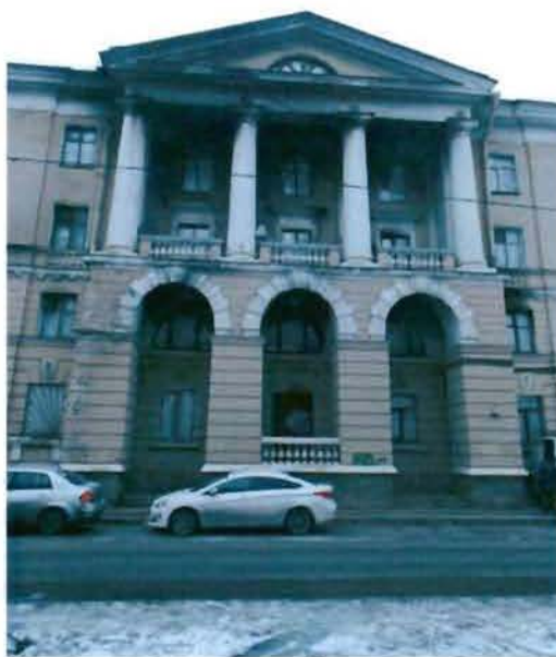
10. Портик западного фасада.
