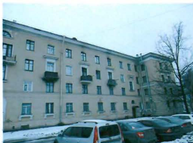
8. Фрагмент фасада. Вид с северо-востока.
