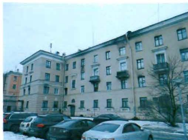
7. Фрагмент фасада. Вид с севера.
