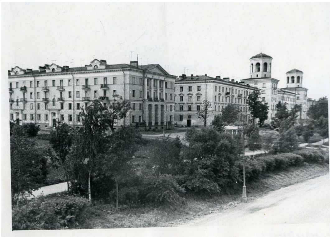
Иллюстрация 11. Фотография 1963-1965 гг. Жилые дома для работников Кировского завода. На переднем плане – рассматриваемое здание по современному адресу: г. Санкт-Петербург, Кировский район, проспект Стачек, дом 140, литера А. Госкаталог. № 16434886. ГЦМСИР ГИК 35824/521а.
