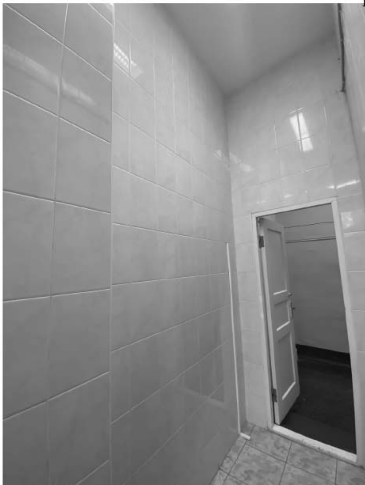
Фото 69. Помещение санузла в уровне 2-го этажа. Дата фотофиксации: 02.12.2024г.
