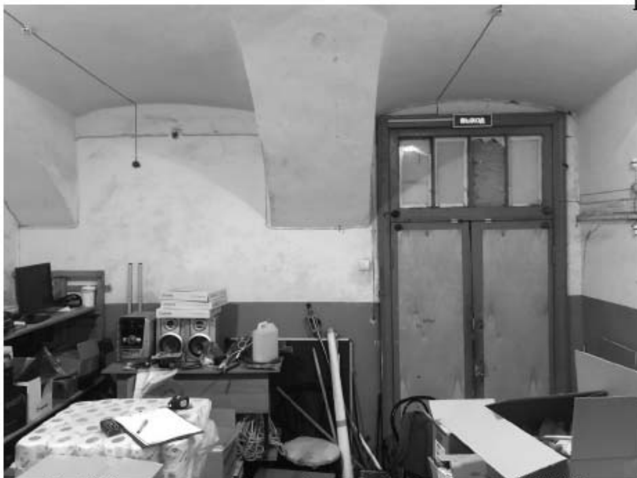
Фото 35. Помещение кладовой в уровне 1-го этажа. Дата фотофиксации: 02.12.2024г.
