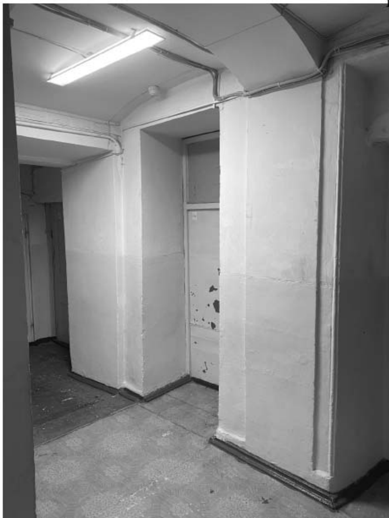
Фото 40. Помещение холла в уровне 1-го этажа. Дата фотофиксации: 02.12.2024г.
