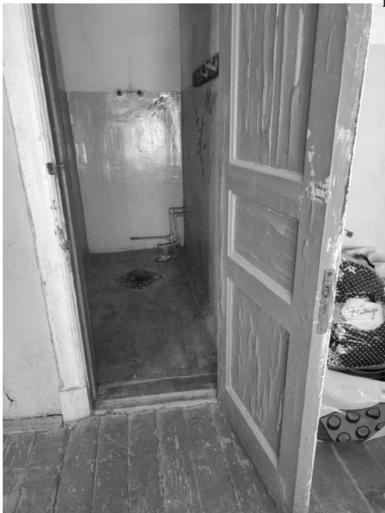
Фото 83. Помещение кладовой в уровне 3-го этажа. Дата фотофиксации: 02.12.2024г.
