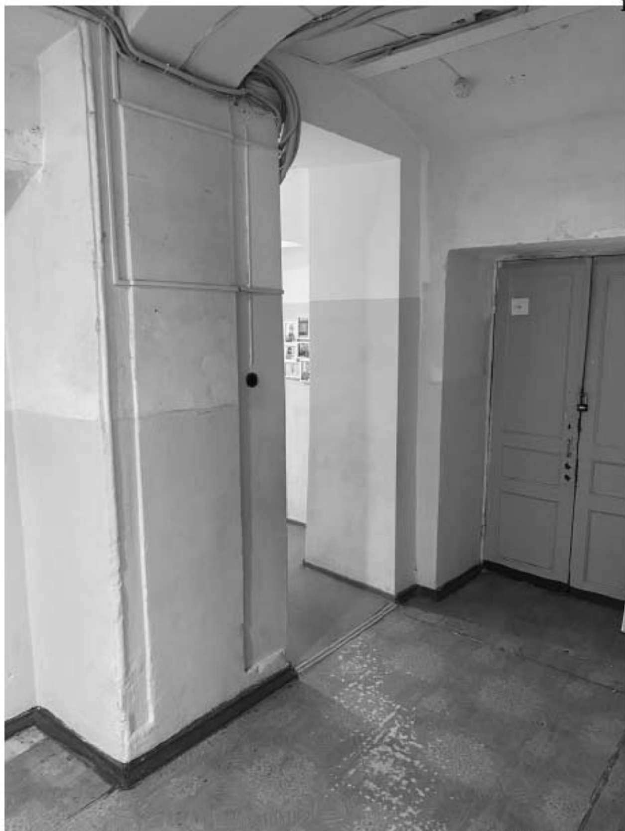
Фото 41. Помещение холла в уровне 1-го этажа. Дата фотофиксации: 02.12.2024г.
