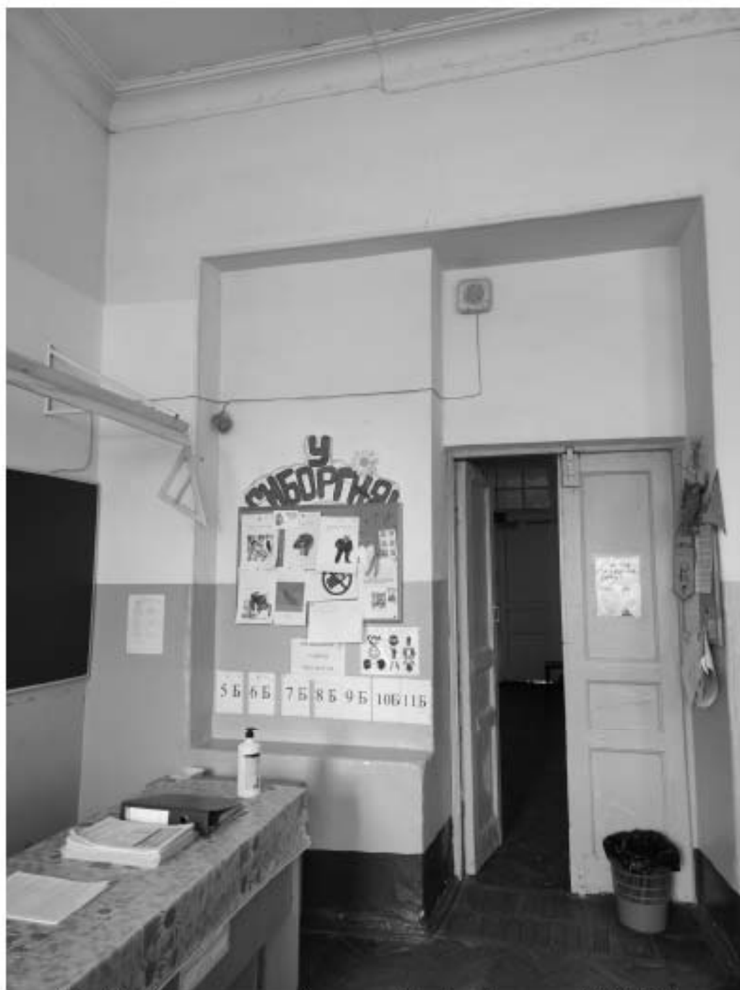
Фото 64. Кабинет в уровне 2-го этажа. Дата фотофиксации: 02.12.2024г.
