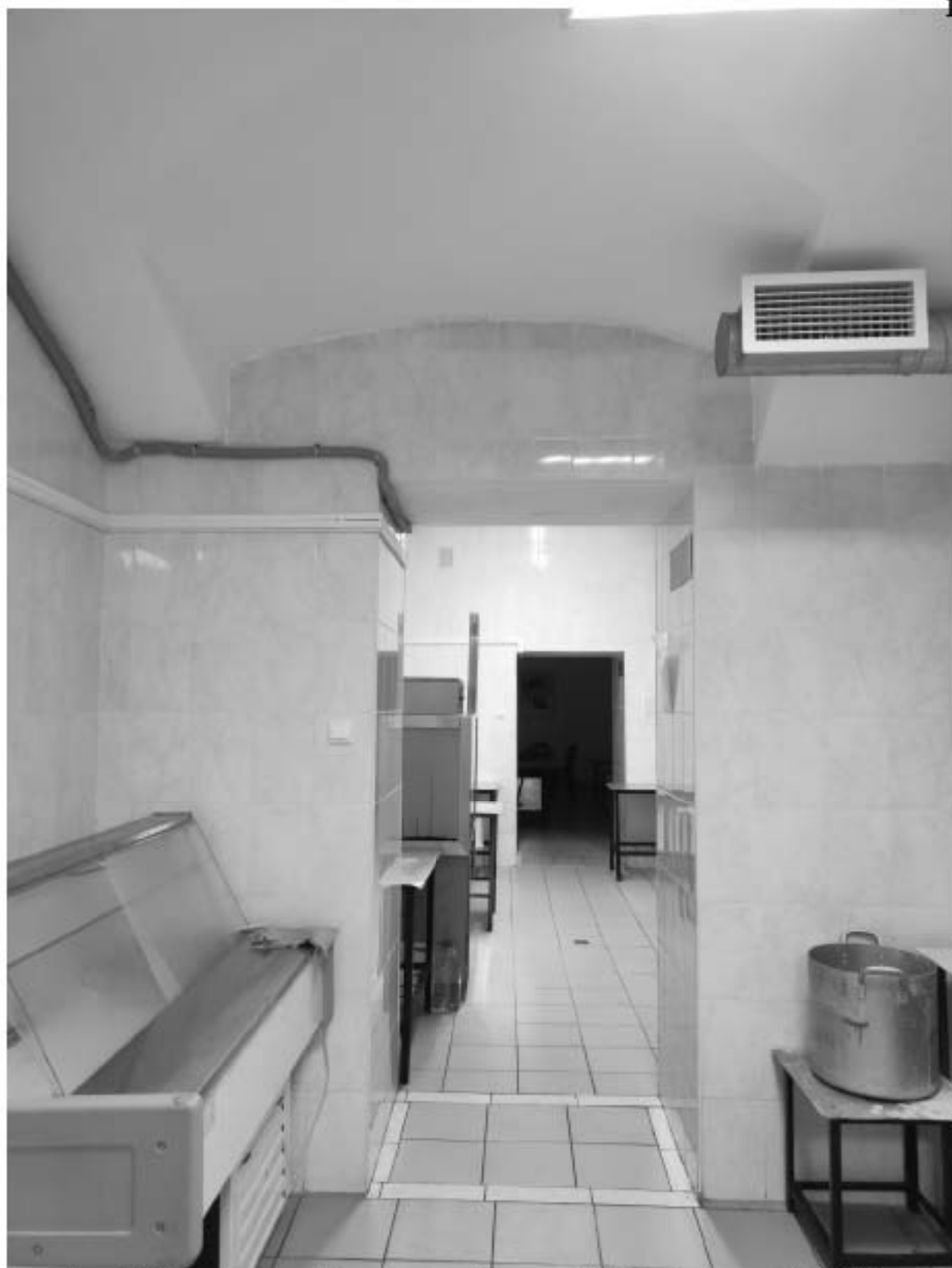
Фото 53. Помещение пищеблока в уровне 1-го этажа. Дата фотофиксации: 02.12.2024г.
