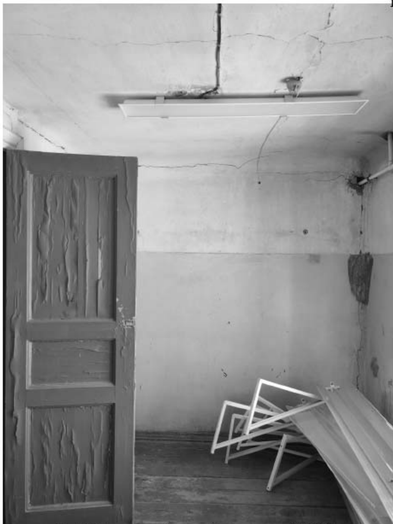
Фото 82. Кабинет в уровне 3-го этажа. Дата фотофиксации: 02.12.2024г.
