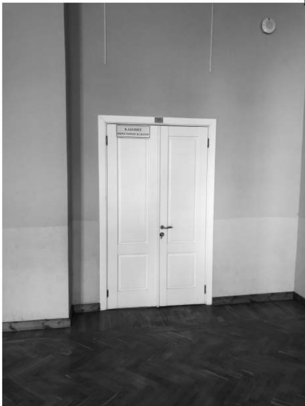
Фото 77. Помещение холла в уровне 2-го этажа. Дата фотофиксации: 02.12.2024г.
