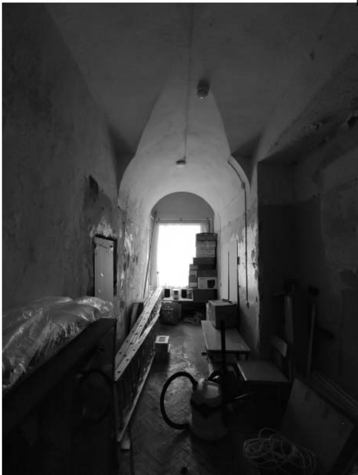
Фото 38. Помещение кладовой в уровне 1-го этажа. Дата фотофиксации: 02.12.2024г.
