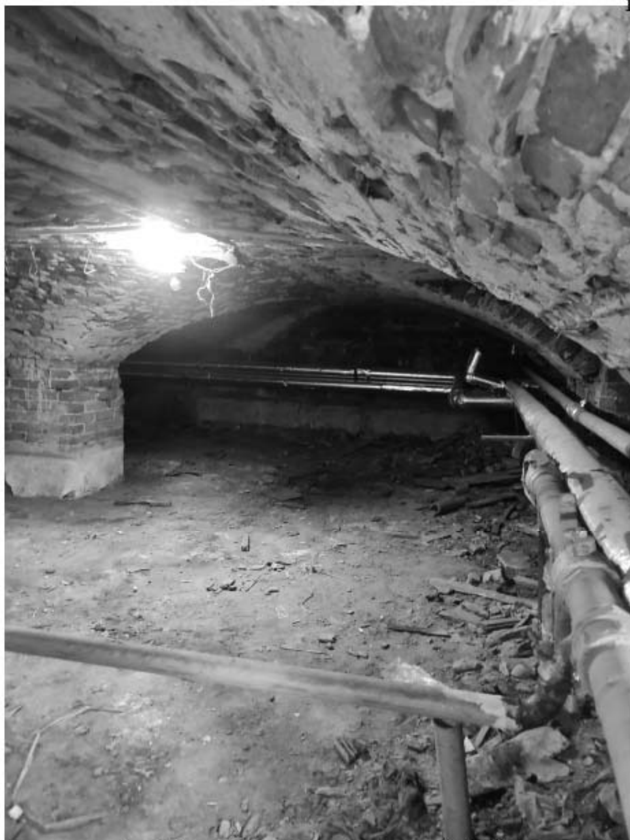
Фото 21. Помещения подвала. Дата фотофиксации: 02.12.2024г.
