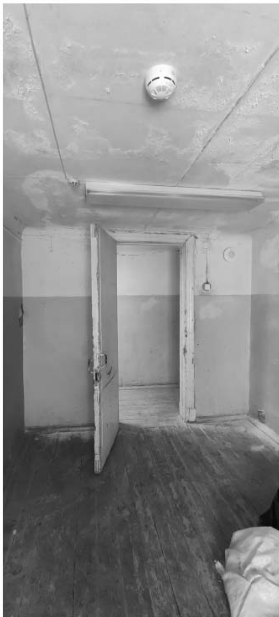
Фото 85. Кабинет в уровне 3-го этажа. Дата фотофиксации: 02.12.2024г.
