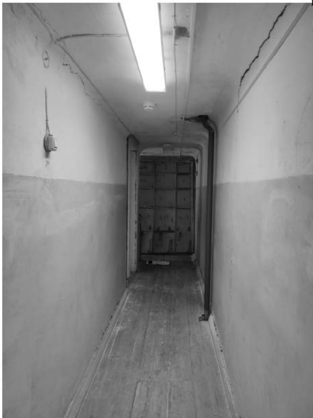
Фото 84. Коридор в уровне 3-го этажа. Дата фотофиксации: 02.12.2024г.
