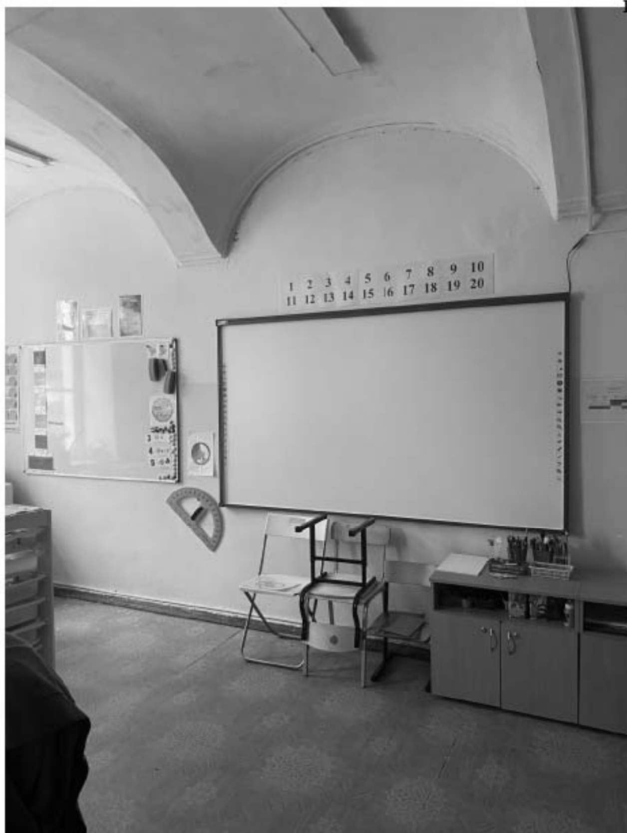
Фото 37. Помещение класса в уровне 1-го этажа. Дата фотофиксации: 02.12.2024г.
