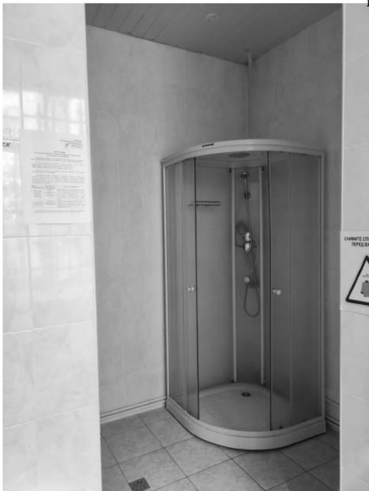
Фото 59. Помещение ванны в уровне 1-го этажа. Дата фотофиксации: 02.12.2024г.
