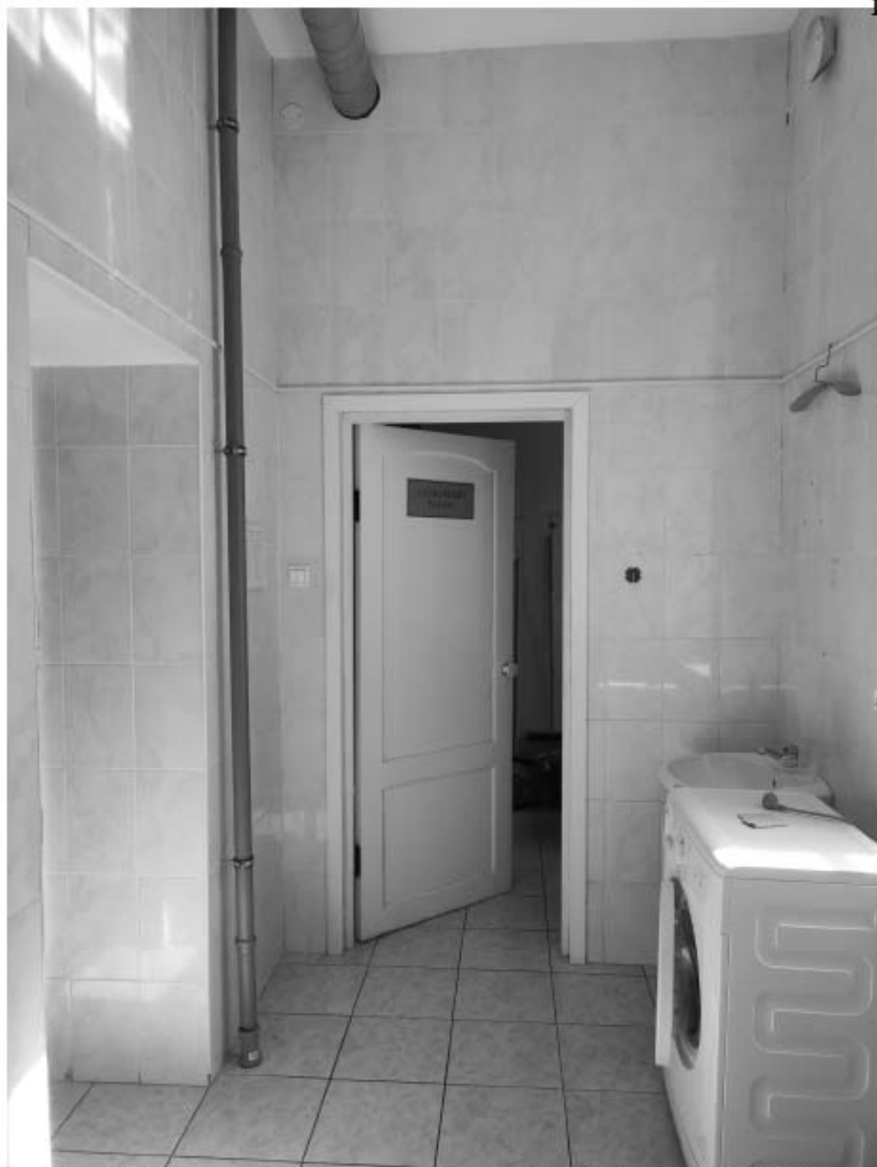
Фото 58. Помещение пищеблока в уровне 1-го этажа. Дата фотофиксации: 02.12.2024г.
