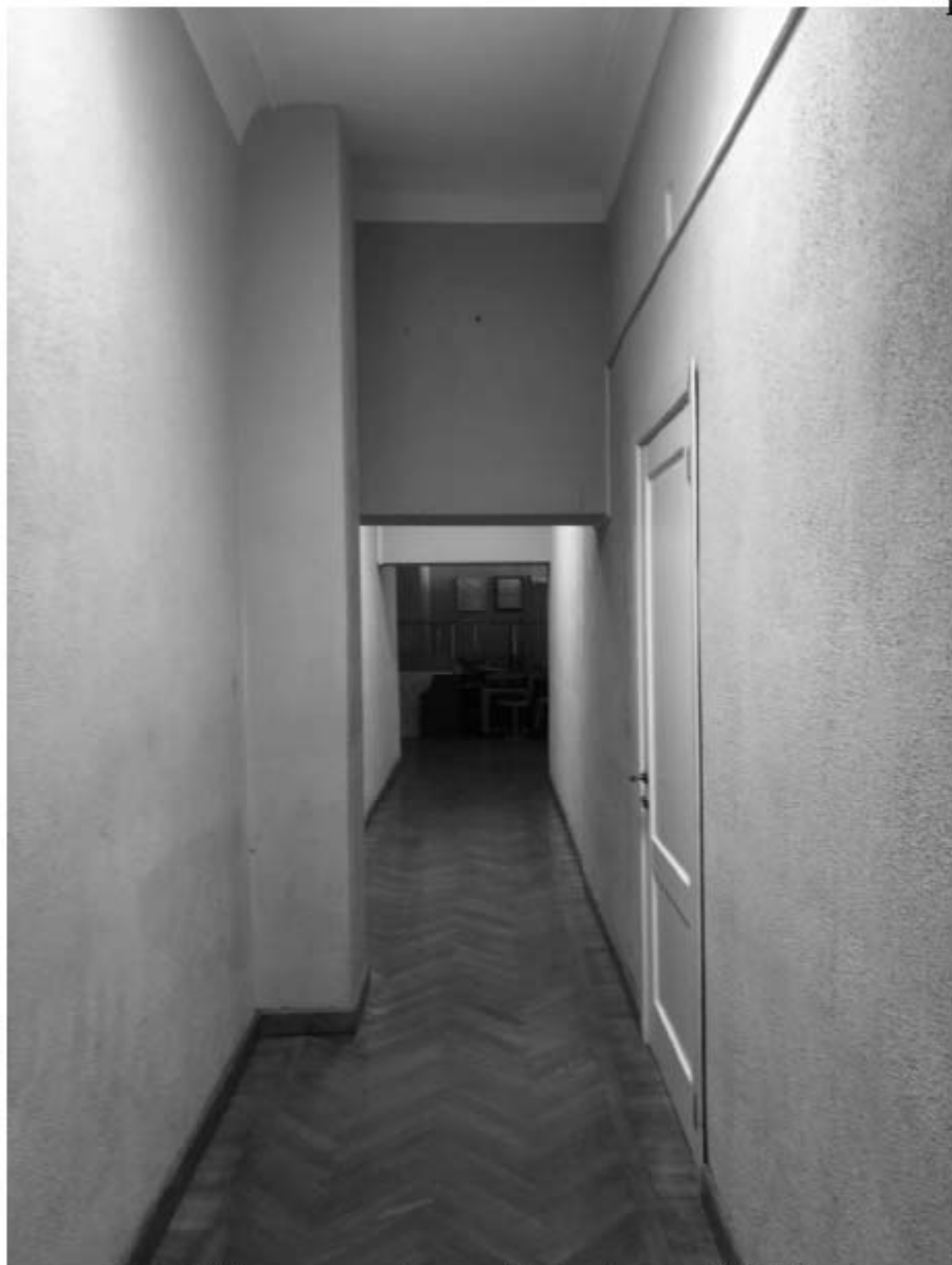
Фото 87. Коридор в уровне 3-го этажа. Дата фотофиксации: 02.12.2024г.
