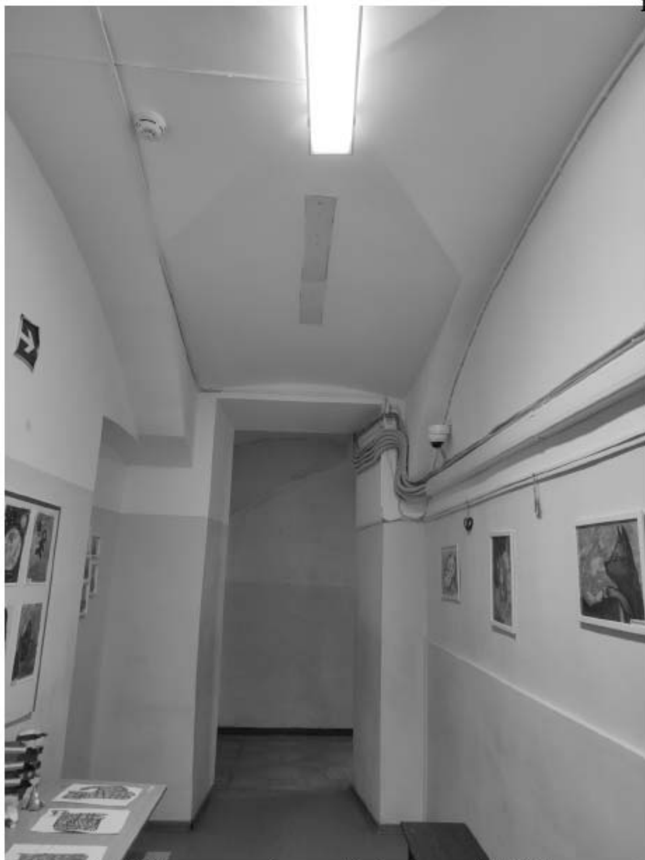
Фото 30. Коридор в уровне 1-го этажа. Дата фотофиксации: 02.12.2024г.
