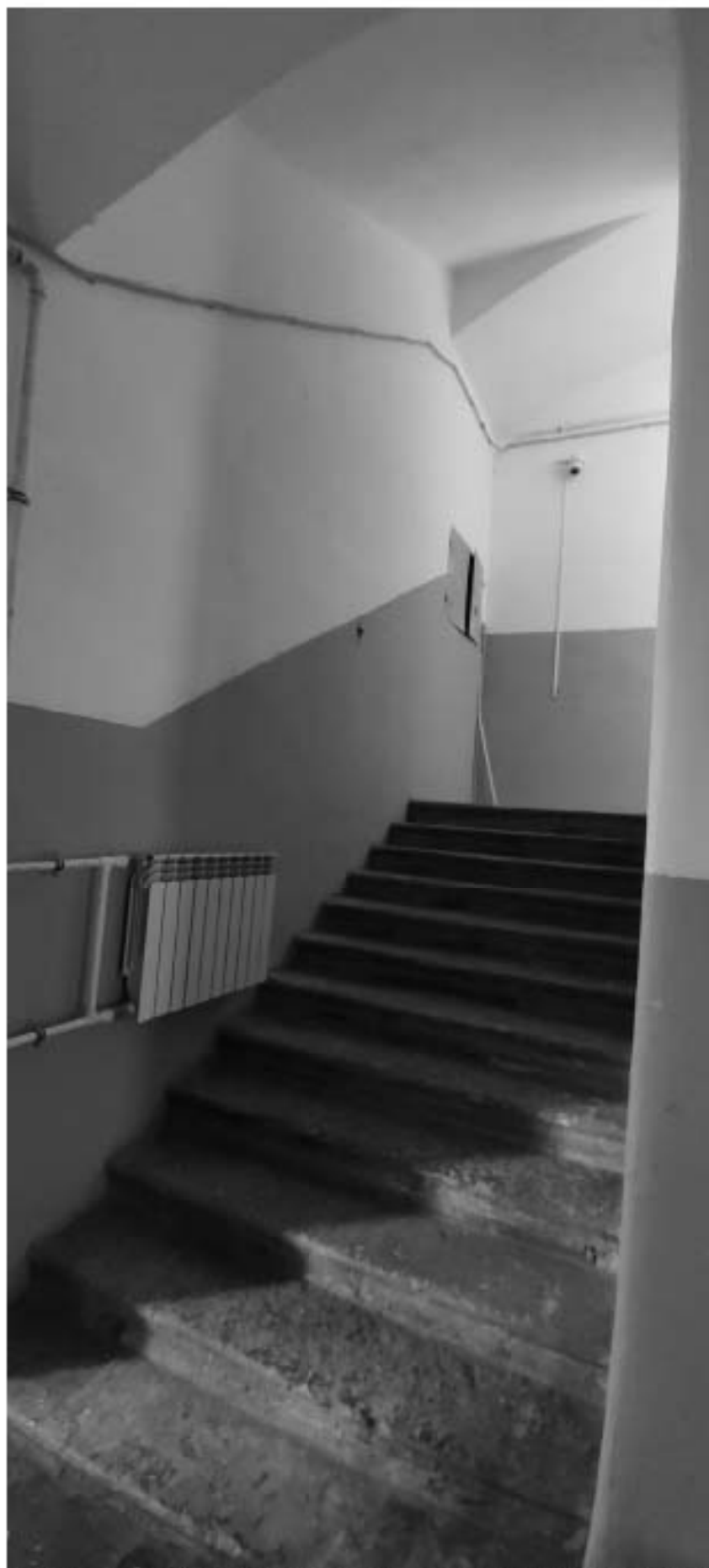
Фото 93. Помещение ЛК-3 в уровне 1-го этажа. Дата фотофиксации: 02.12.2024г.
