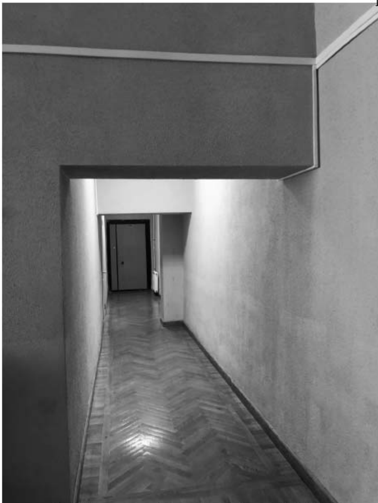
Фото 88. Коридор в уровне 3-го этажа. Дата фотофиксации: 02.12.2024г.
