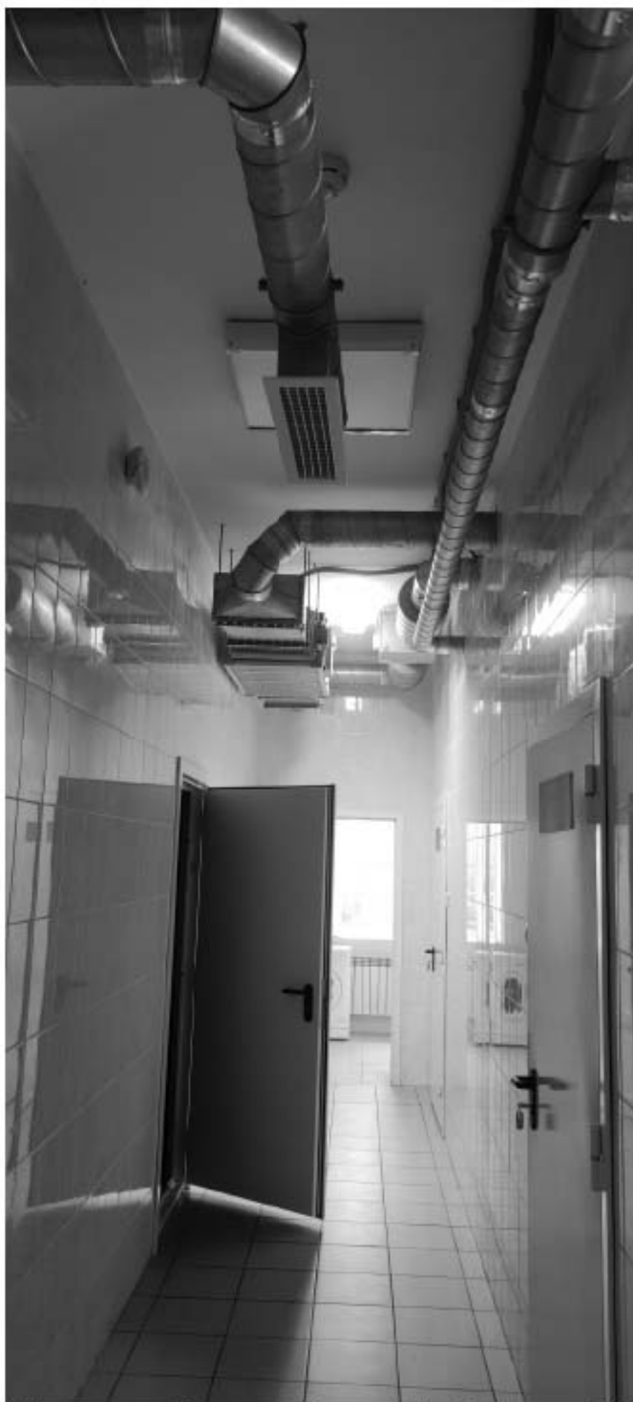
Фото 61. Помещение пищеблока в уровне 1-го этажа. Дата фотофиксации: 02.12.2024г.
