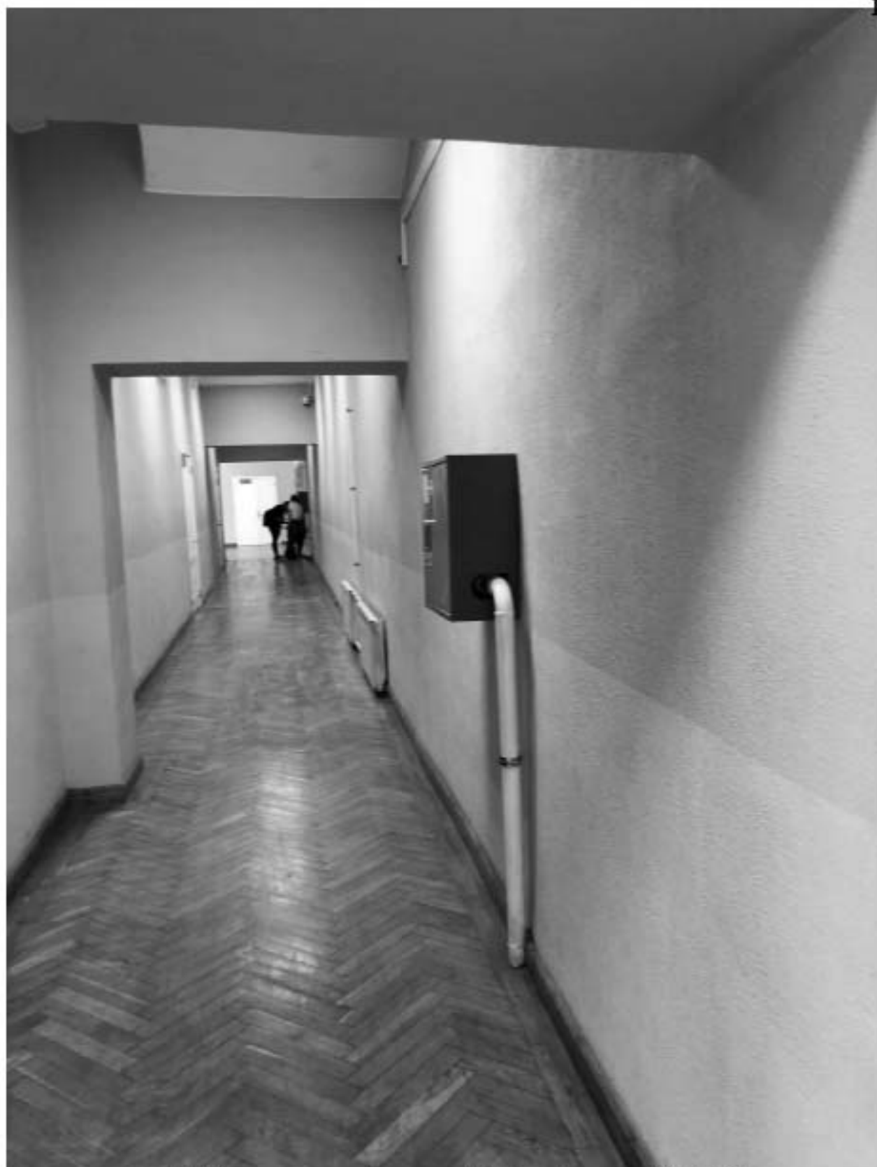
Фото 91. Коридор в уровне 3-го этажа. Дата фотофиксации: 02.12.2024г.
