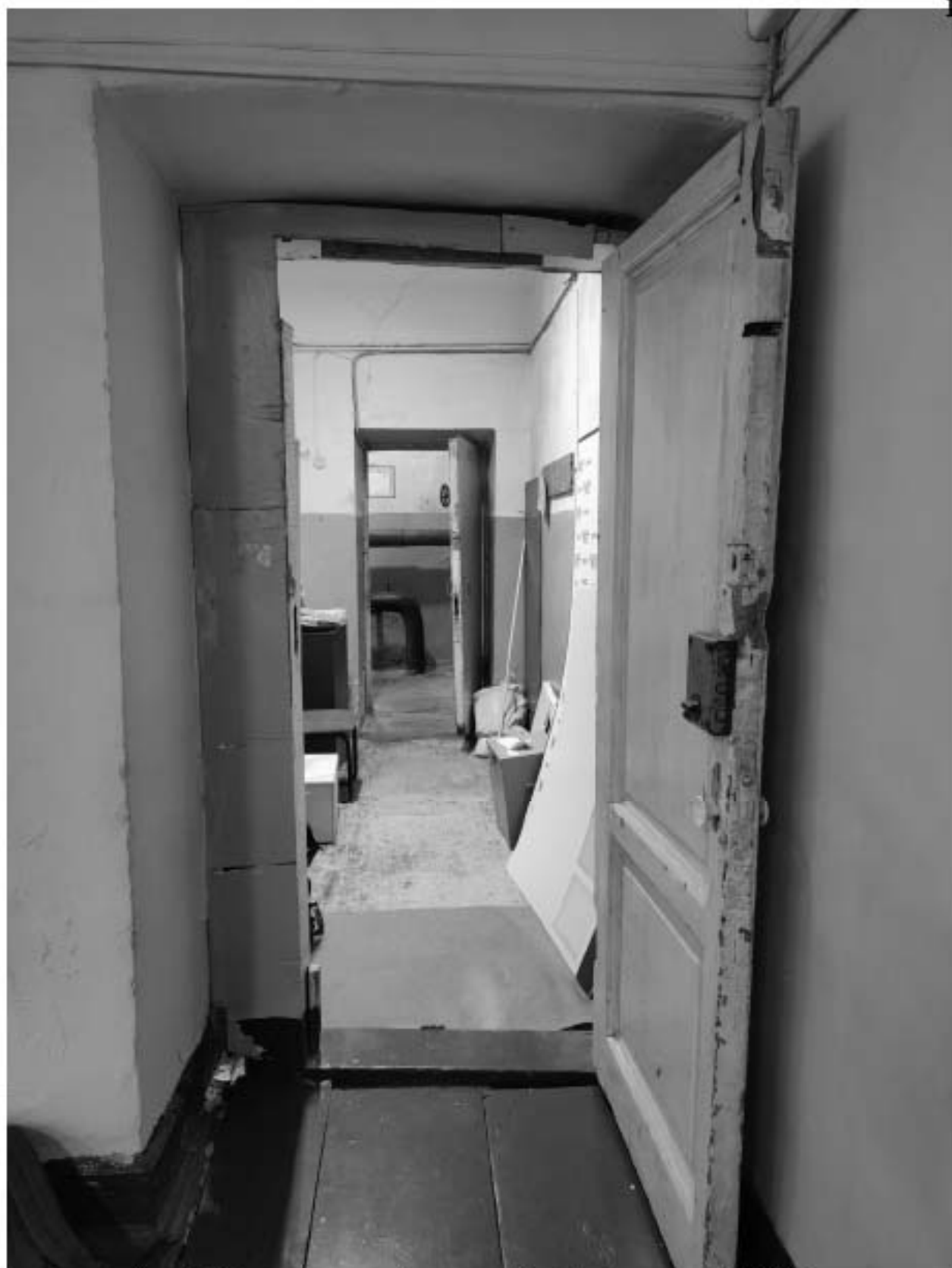
Фото 47. Кладовая в уровне 1-го этажа. Дата фотофиксации: 02.12.2024г.
