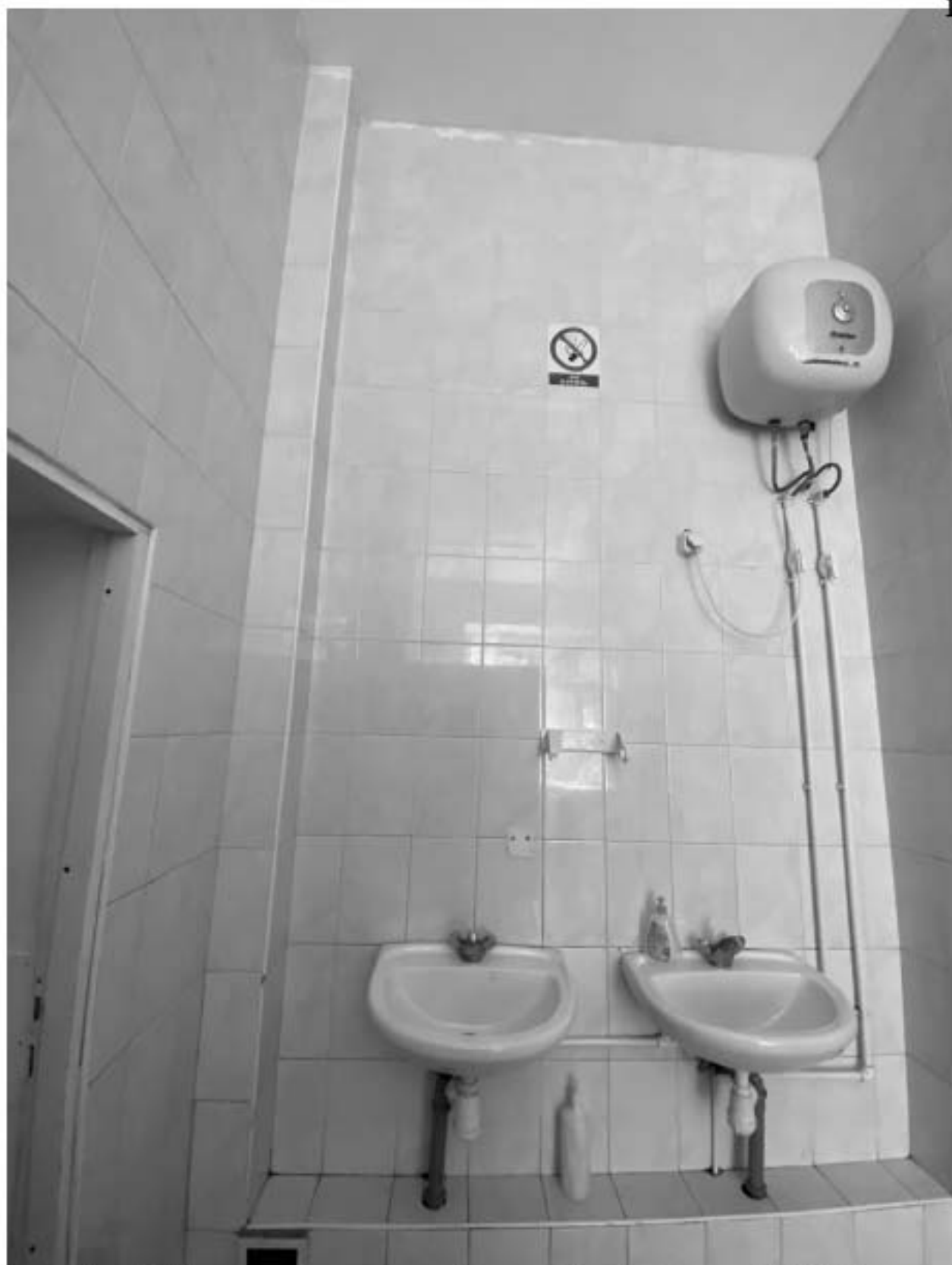
Фото 86. Помещение санузла в уровне 3-го этажа. Дата фотофиксации: 02.12.2024г.
