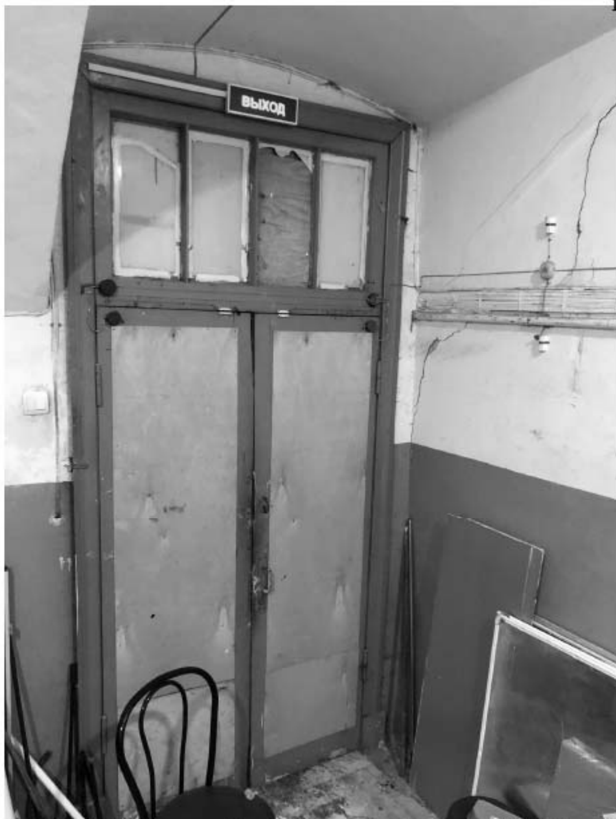
Фото 34. Помещение кладовой в уровне 1-го этажа. Дата фотофиксации: 02.12.2024г.
