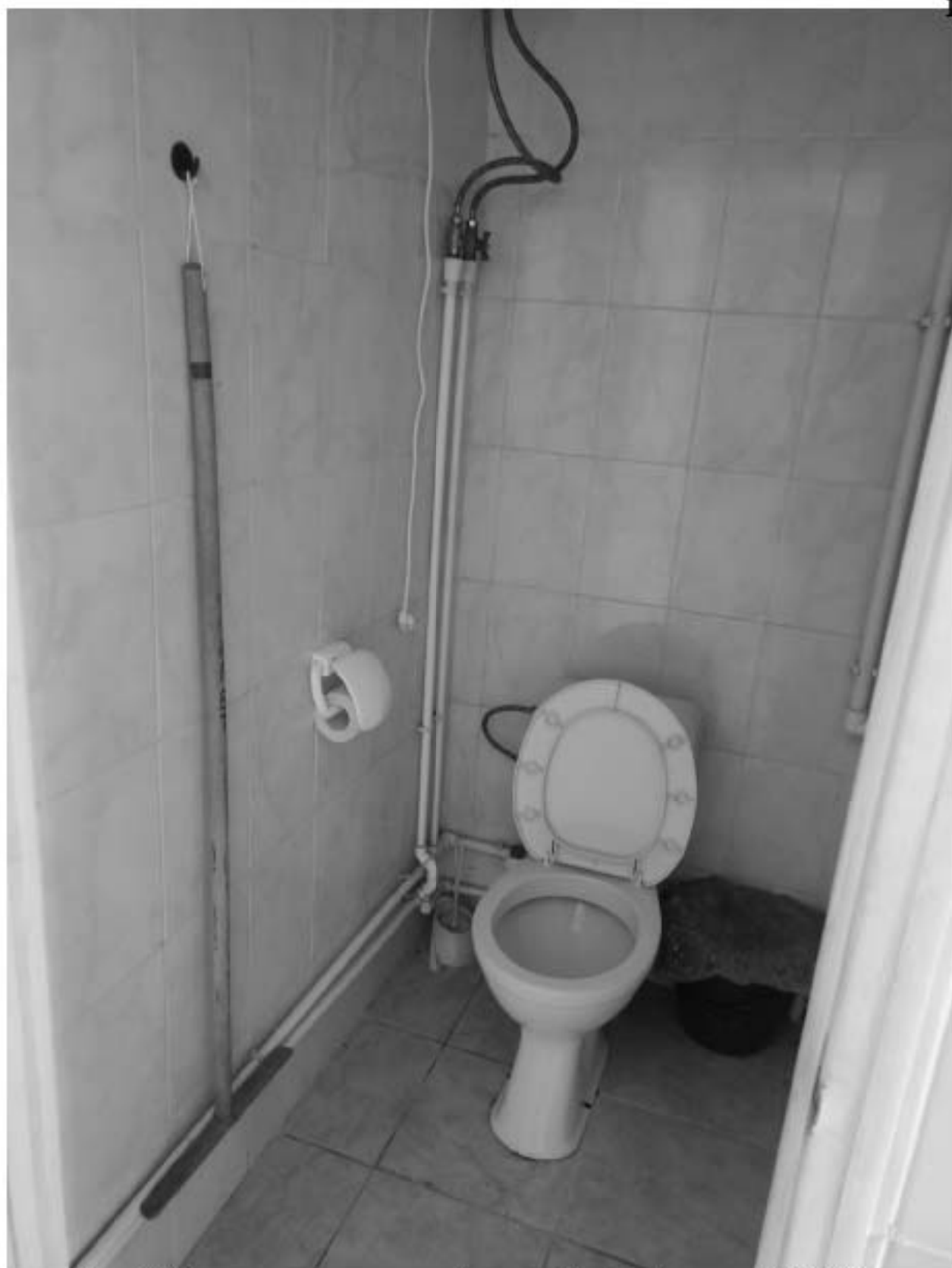
Фото 60. Помещение санузла в уровне 1-го этажа. Дата фотофиксации: 02.12.2024г.
