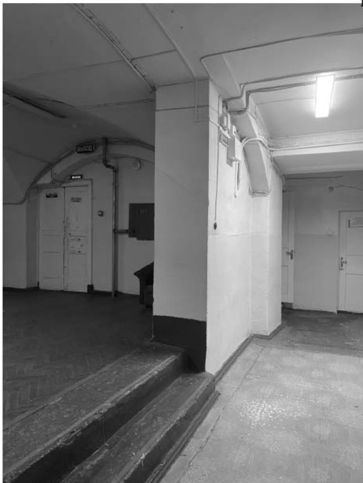
Фото 39. Помещение холла в уровне 1-го этажа. Дата фотофиксации: 02.12.2024г.
