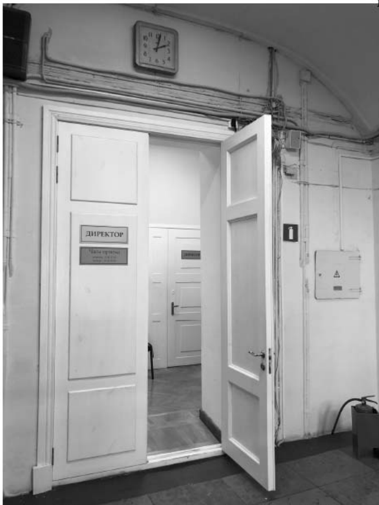
Фото 73. Кабинет директора в уровне 2-го этажа. Дата фотофиксации: 02.12.2024г.
