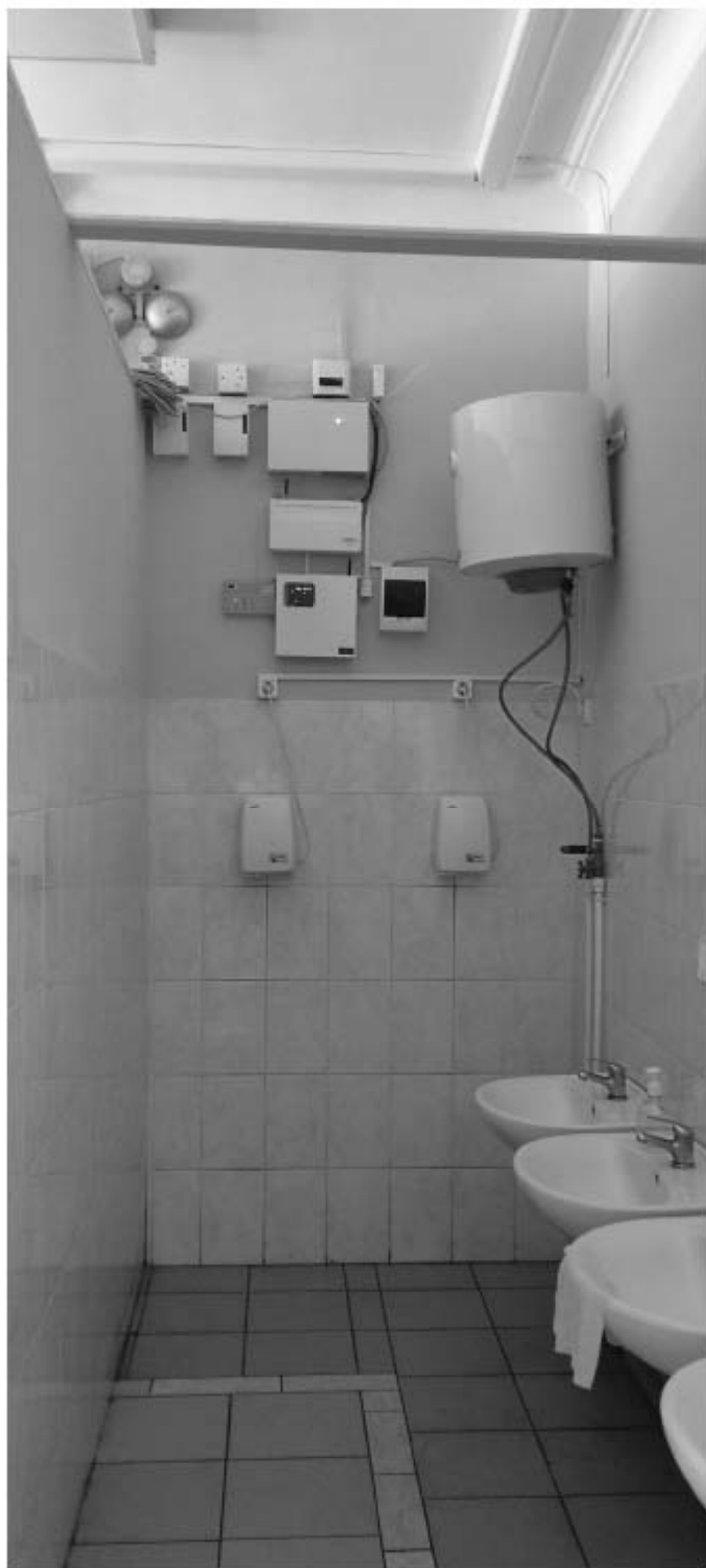
Фото 51. Помещение для мытья рук в уровне 1-го этажа. Дата фотофиксации: 02.12.2024г.
