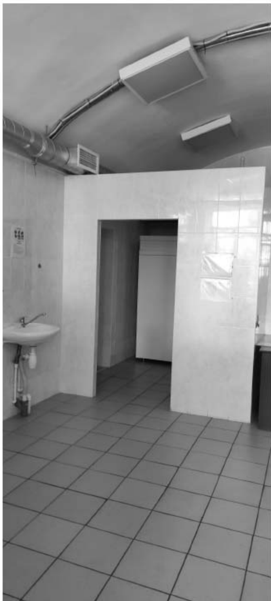
Фото 55. Помещение пищеблока в уровне 1-го этажа. Дата фотофиксации: 02.12.2024г.
