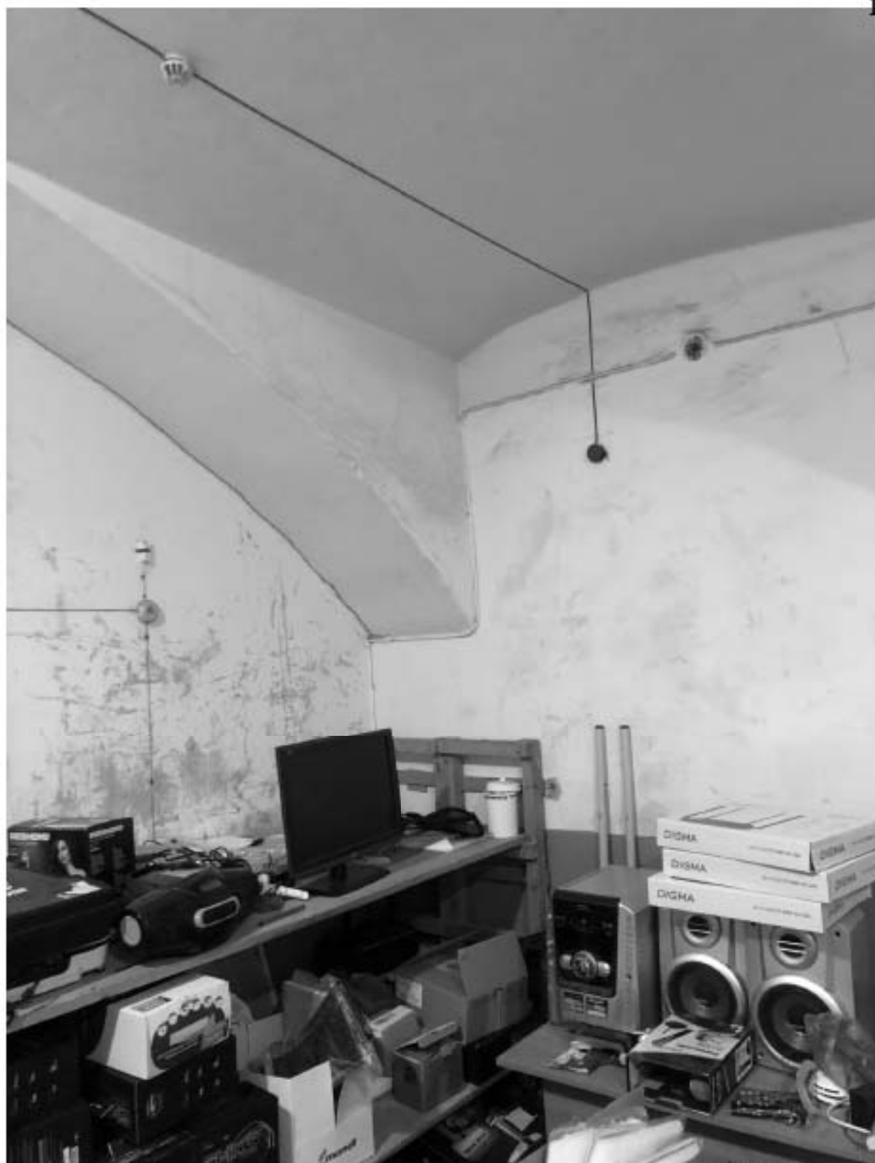
Фото 33. Помещение кладовой в уровне 1-го этажа. Дата фотофиксации: 02.12.2024г.
