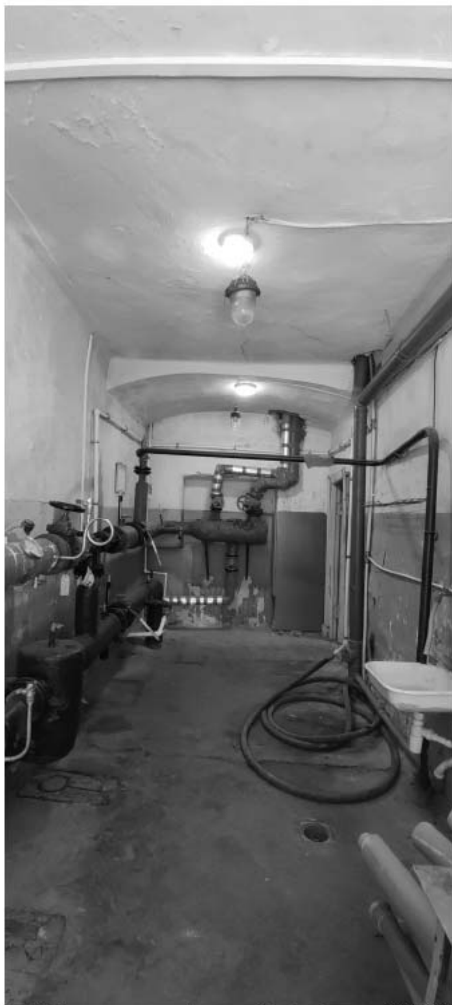
Фото 46. Теплоцентр в уровне 1-го этажа. Дата фотофиксации: 02.12.2024г.
