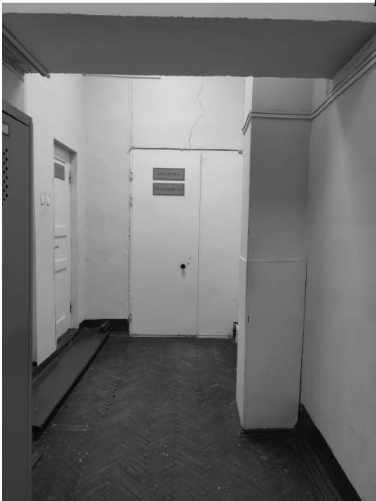
Фото 70. Коридор в уровне 2-го этажа. Дата фотофиксации: 02.12.2024г.
