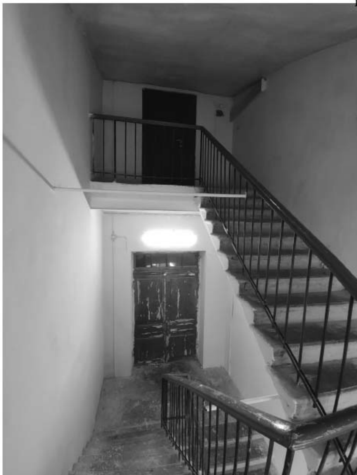
Фото 92. Помещение ЛК-1 в уровне 3-го этажа. Дата фотофиксации: 02.12.2024г.
