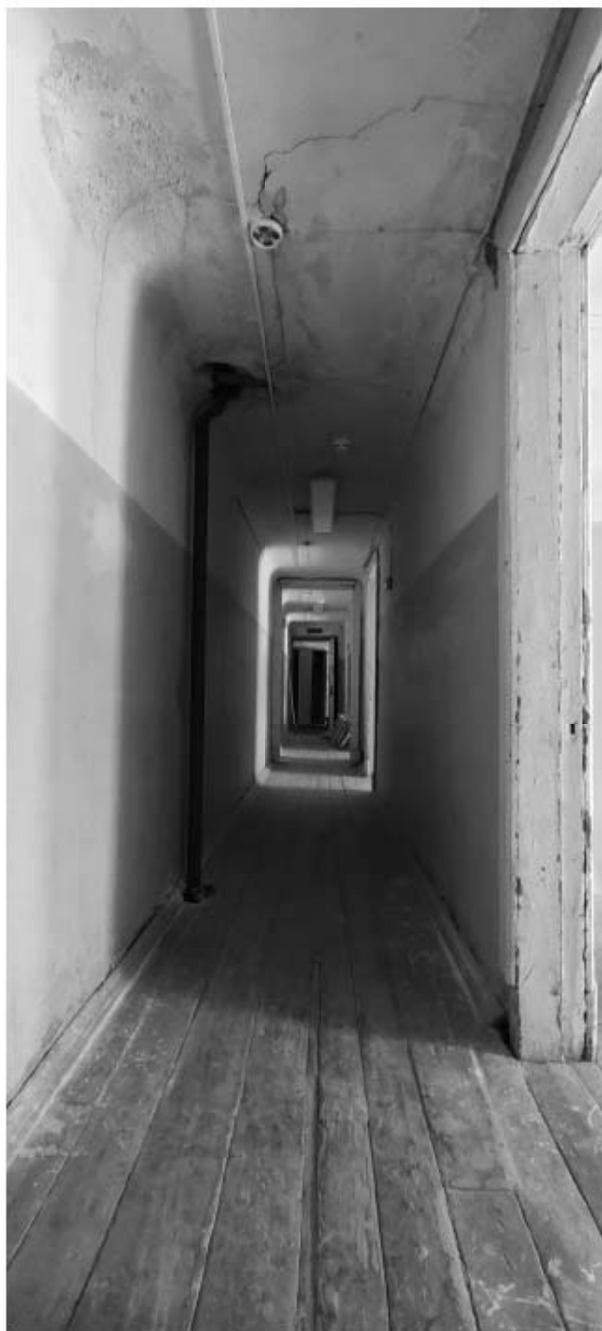
Фото 81. Коридор в уровне 3-го этажа. Дата фотофиксации: 02.12.2024г.
