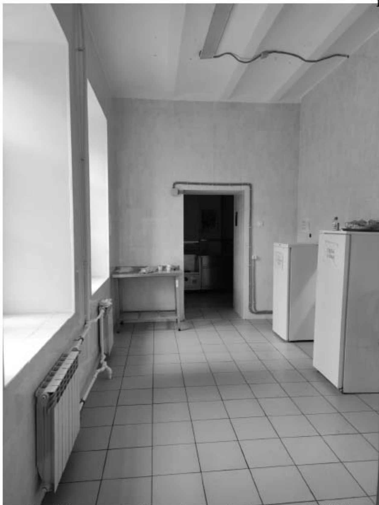
Фото 52. Помещение столовой в уровне 1-го этажа. Дата фотофиксации: 02.12.2024г.
