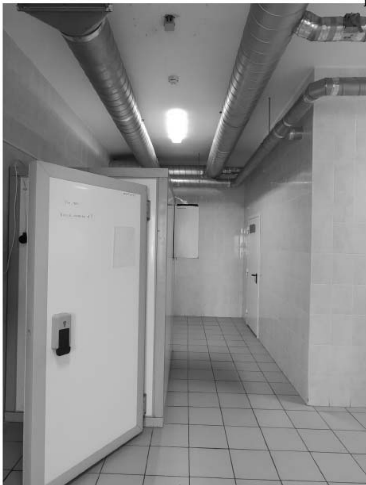
Фото 56. Помещение пищеблока в уровне 1-го этажа. Дата фотофиксации: 02.12.2024г.
