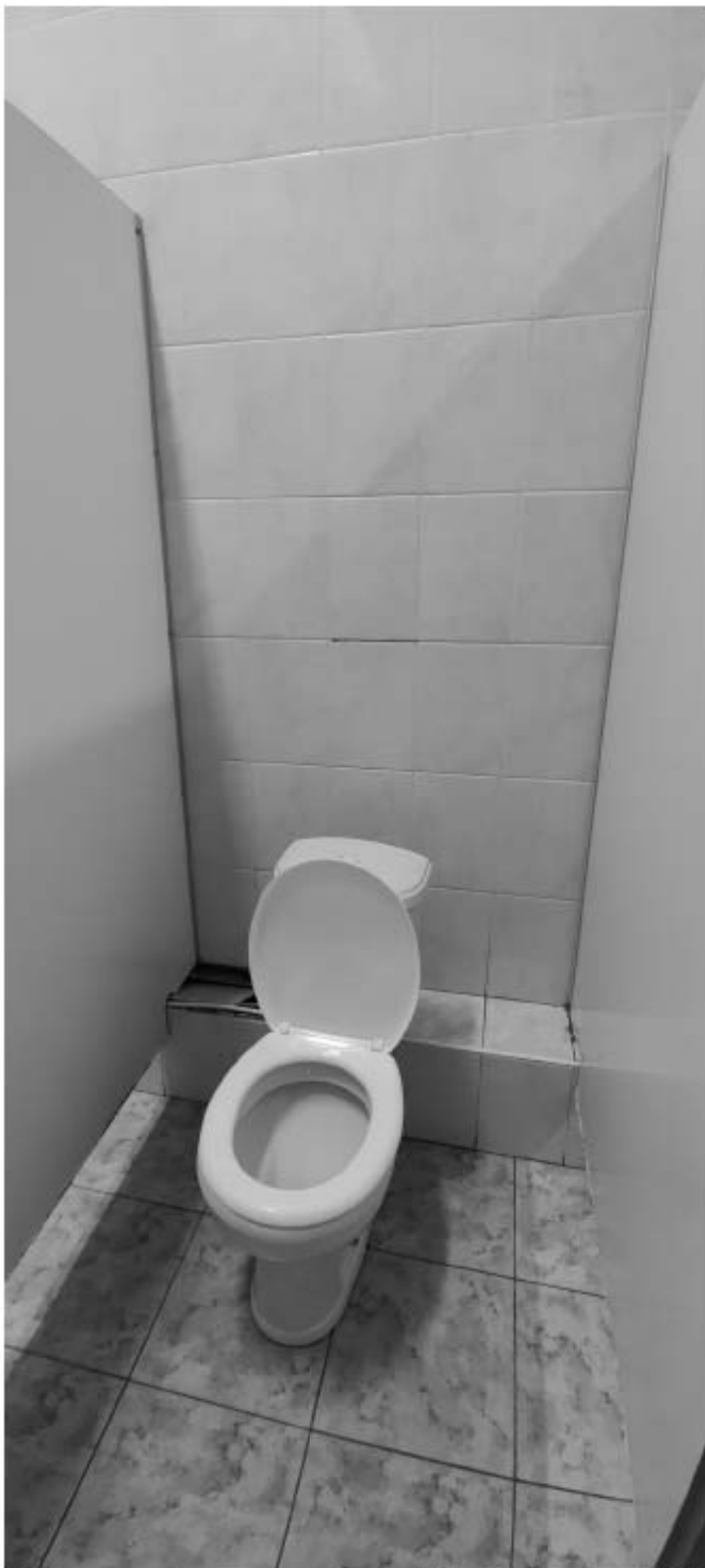
Фото 63. Помещение санузла в уровне 2-го этажа. Дата фотофиксации: 02.12.2024г.
