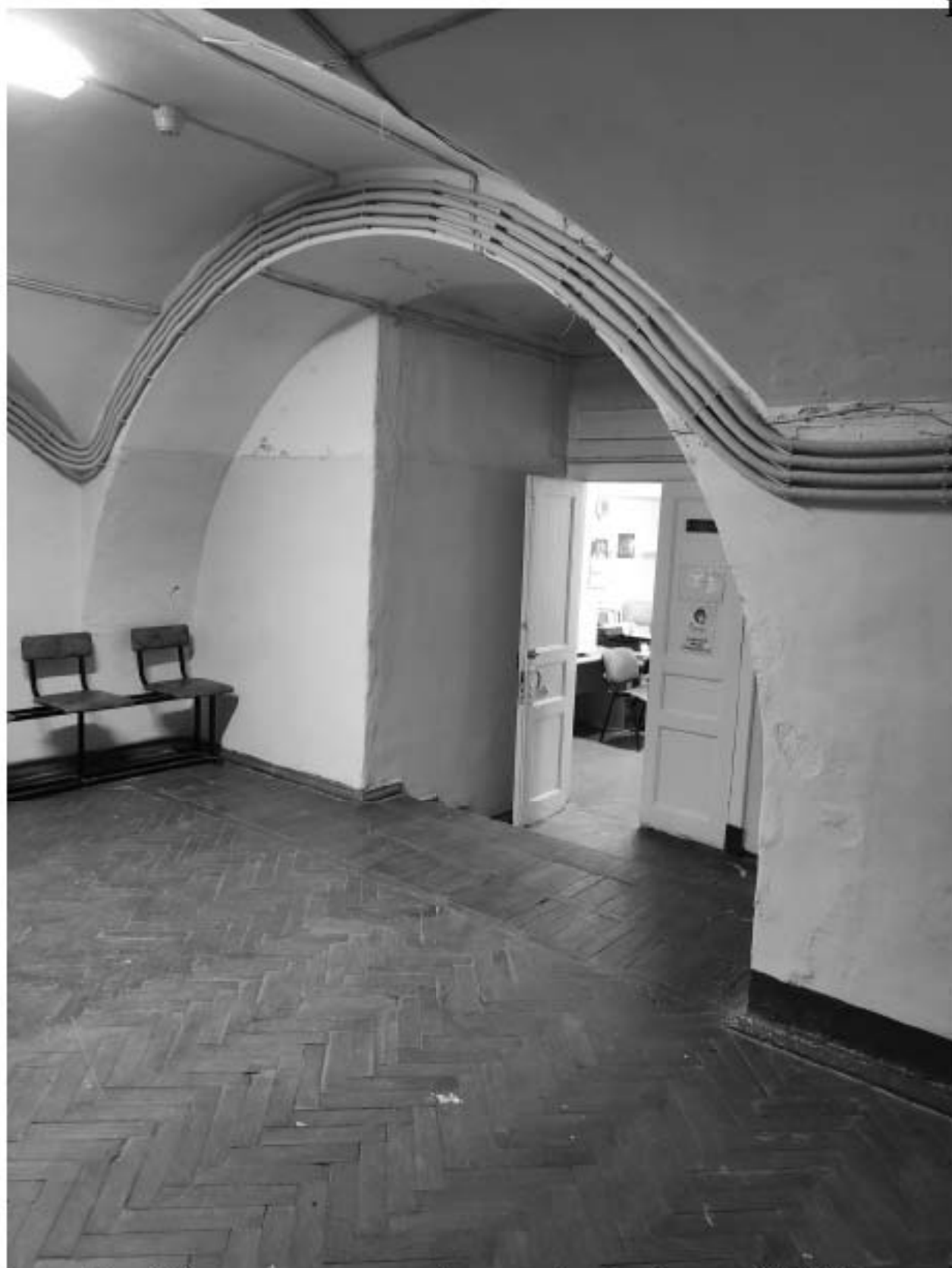
Фото 42. Помещение холла в уровне 1-го этажа. Дата фотофиксации: 02.12.2024г.
