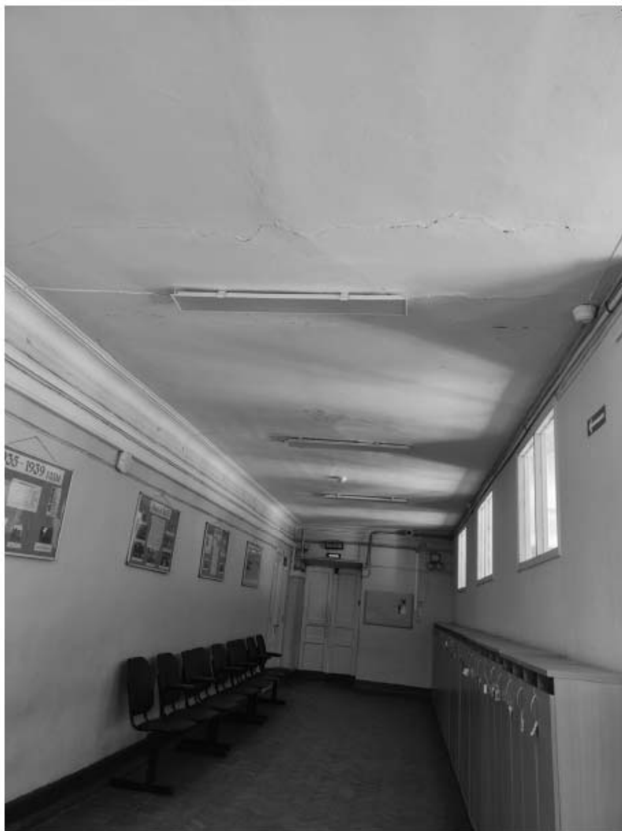
Фото 48. Помещение холла в уровне 1-го этажа. Дата фотофиксации: 02.12.2024г. .12.2024г.
