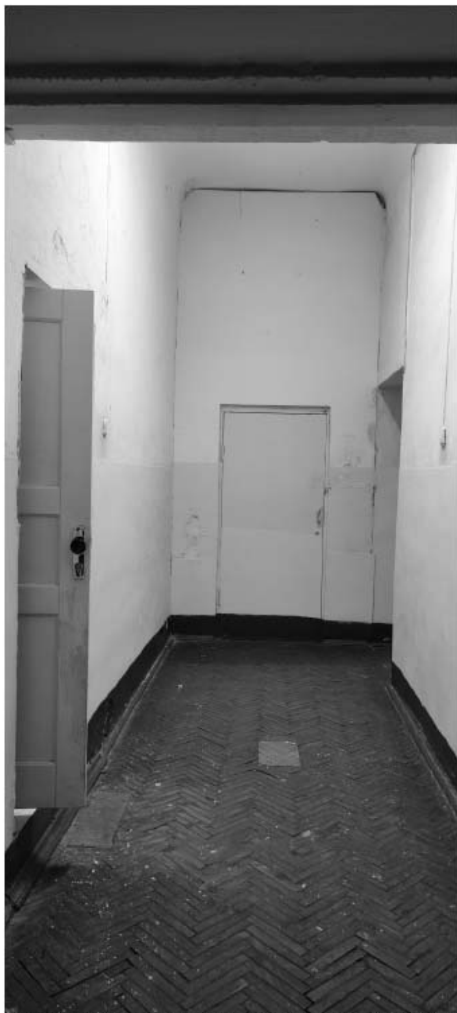
Фото 62. Коридор в уровне 2-го этажа. Дата фотофиксации: 02.12.2024г.
