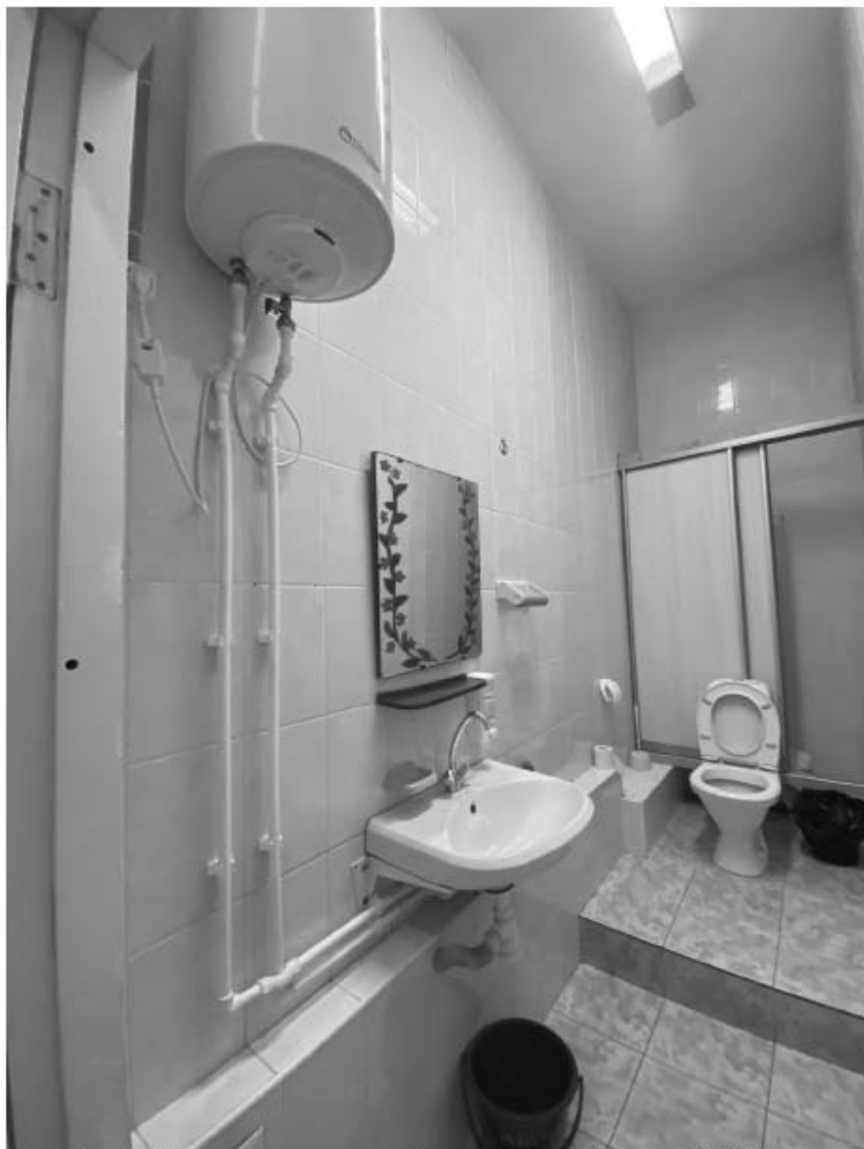
Фото 68. Помещение санузла в уровне 2-го этажа. Дата фотофиксации: 02.12.2024г.
