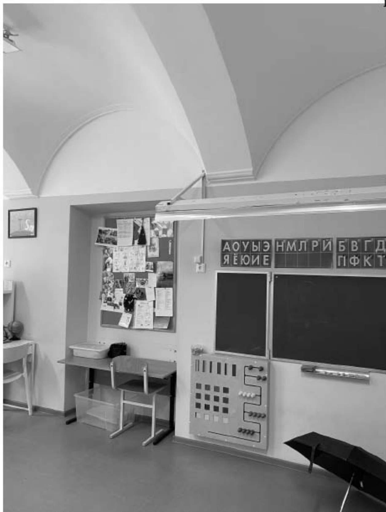
Фото 29. Помещение кабинета в уровне 1-го этажа. Дата фотофиксации: 02.12.2024г.
