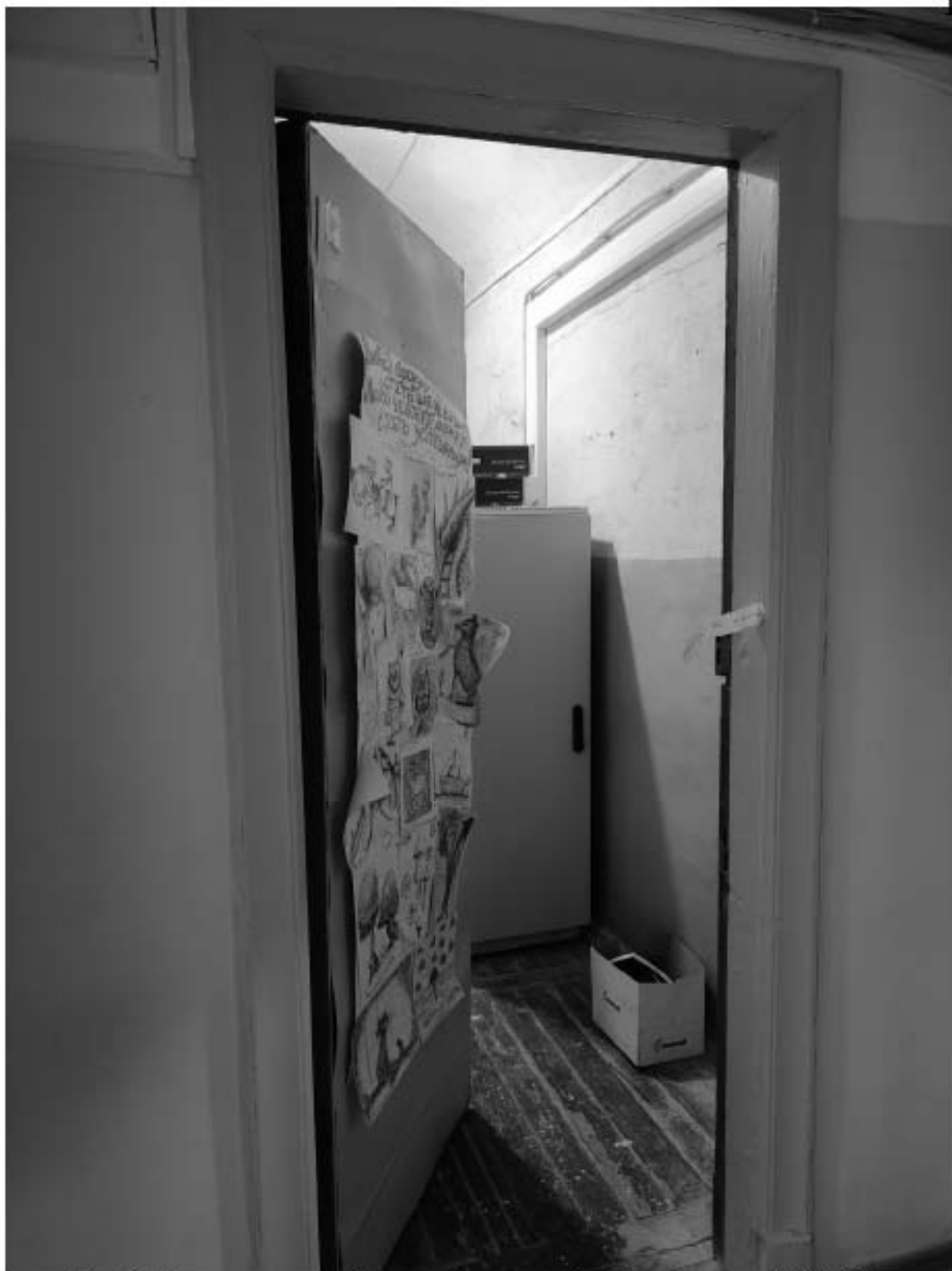
Фото 31. Помещение кладовой в уровне 1-го этажа. Дата фотофиксации: 02.12.2024г.
