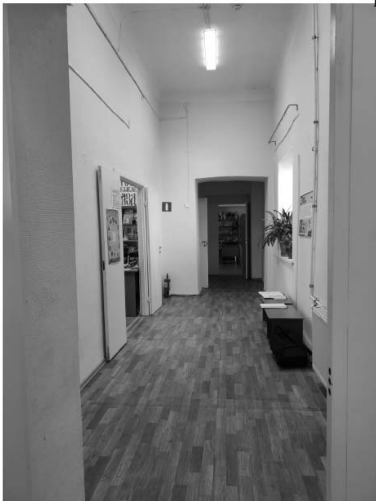
Фото 65. Коридор в уровне 2-го этажа. Дата фотофиксации: 02.12.2024г.
