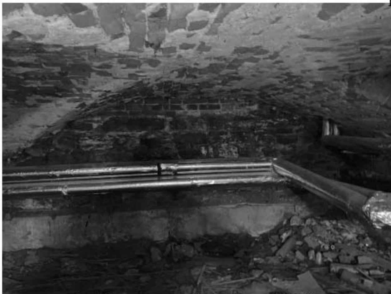
Фото 22. Помещения подвала. Дата фотофиксации: 02.12.2024г.
