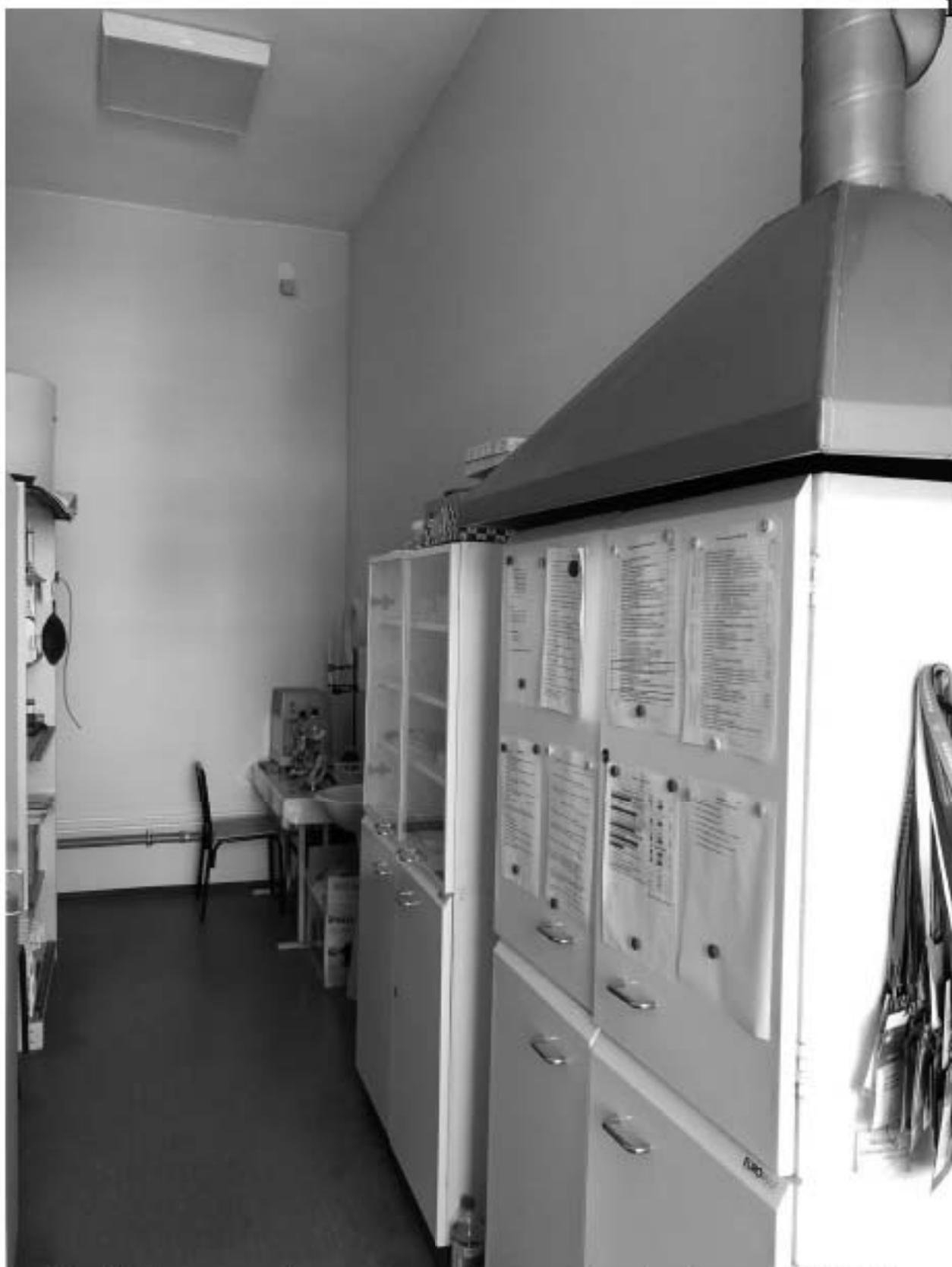
Фото 90. Помещение лаборатории в уровне 3-го этажа. Дата фотофиксации: 02.12.2024г.
