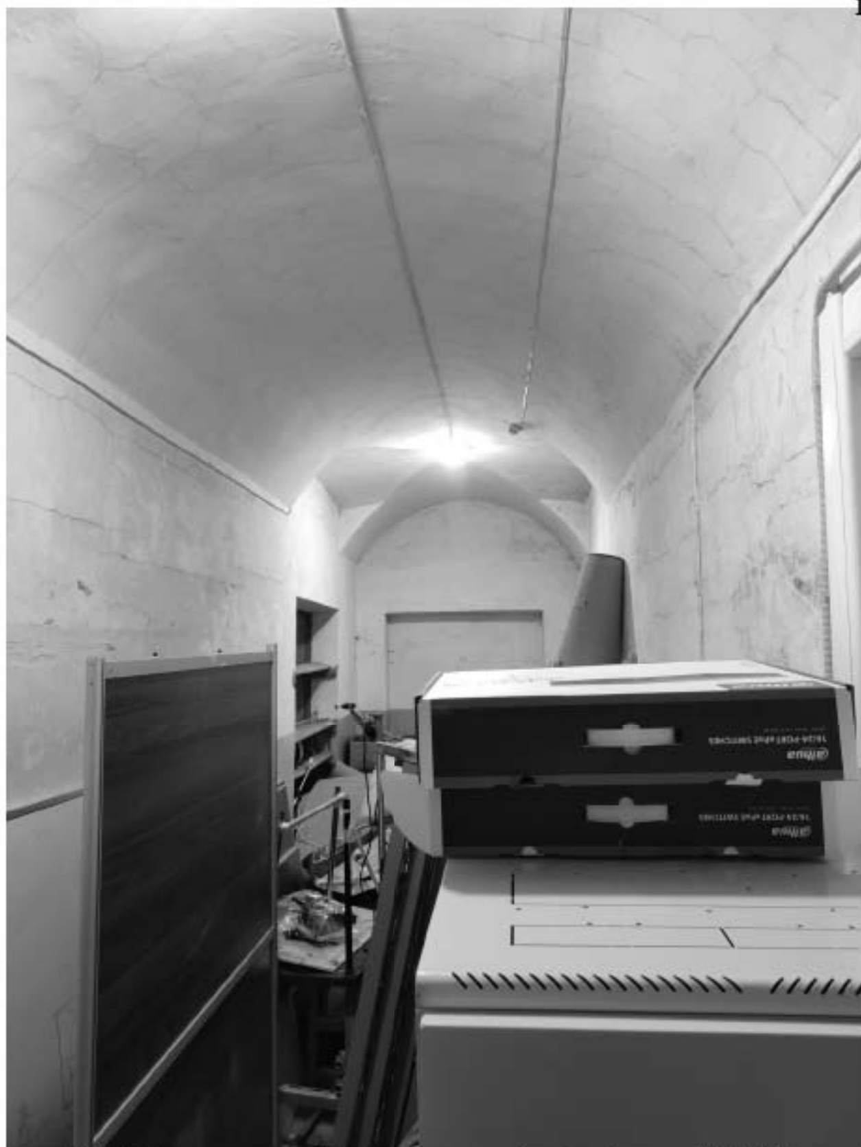
Фото 32. Помещение кладовой в уровне 1-го этажа. Дата фотофиксации: 02.12.2024г.
