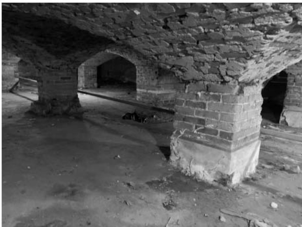
Фото 23. Помещения подвала. Дата фотофиксации: 02.12.2024г.
