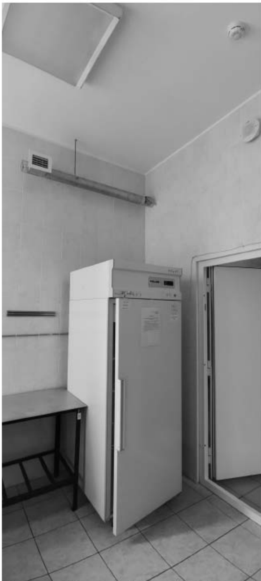
Фото 57. Помещение пищеблока в уровне 1-го этажа. Дата фотофиксации: 02.12.2024г.
