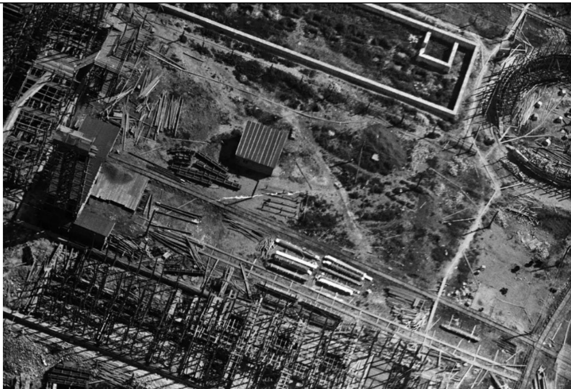
1. Строительство Кировского райсовета, фото 1931 г.
