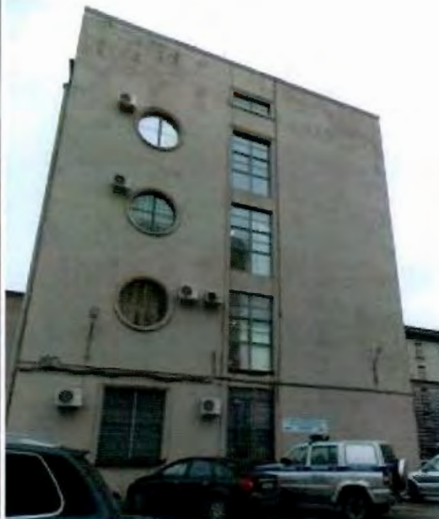
6. Основной объем. Торцевой фасад
