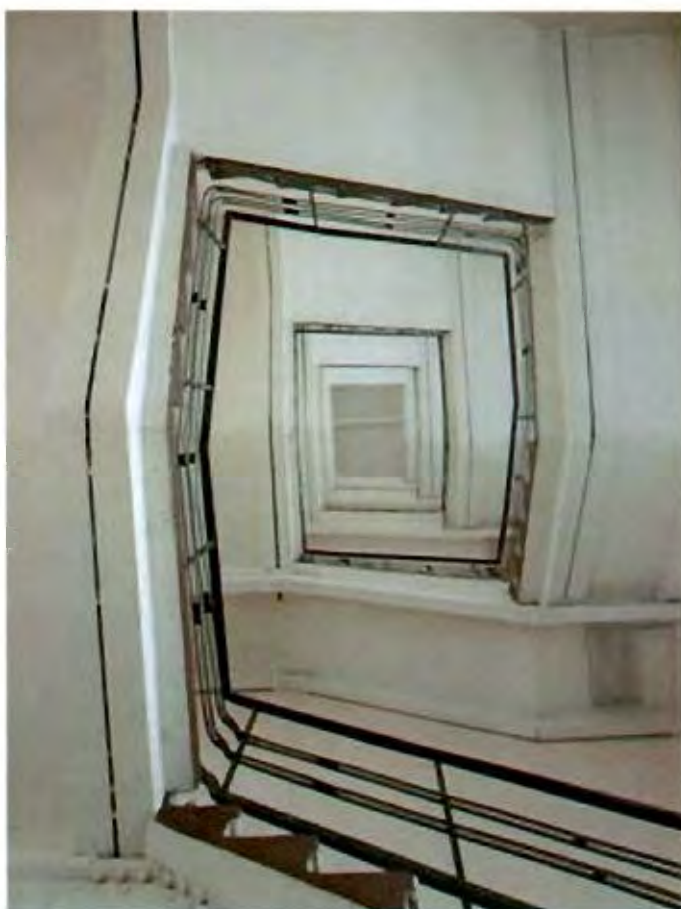
14. Угловая башня. Лестница
