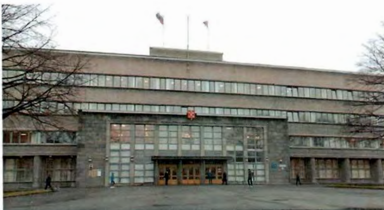
1. Лицевой фасад основного объема. Главный вход
