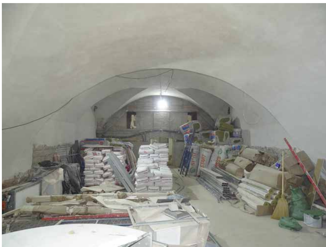
Фото 2. Помещение подвала. Съемка 01.10.2024 г. Полетайкин В.В.
