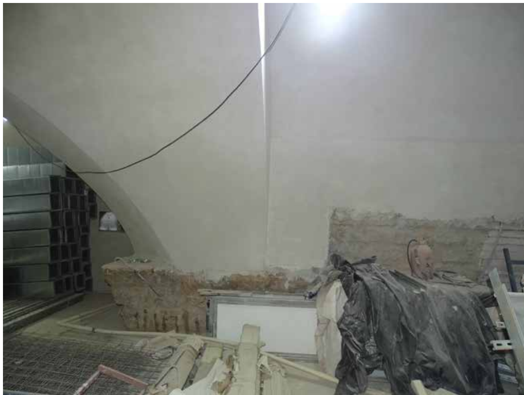
Фото 3. Помещение подвала. Съемка 01.10.2024 г. Полетайкин В.В.
