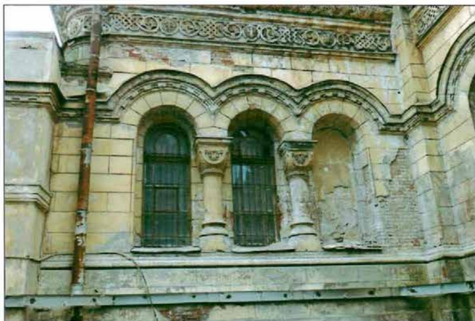
9. Западный фасад. Фрагмент.
