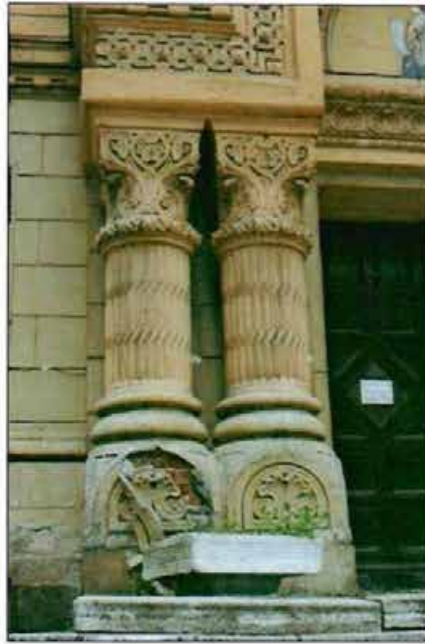
10. Западный фасад. Фрагмент.
