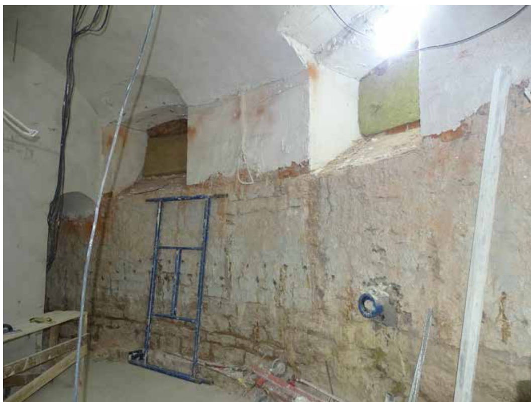
Фото 4. Помещение подвала. Съемка 01.10.2024 г. Полетайкин В.В.
