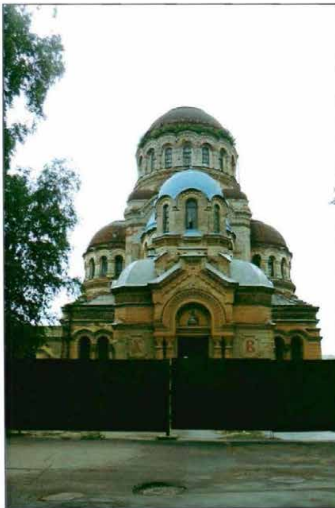
1. Западный фасад. Общий вид.
