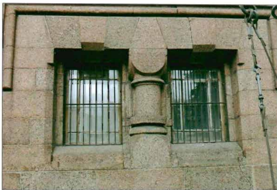
8. Южный фасад. Фрагмент. Окна притвора первого яруса.
