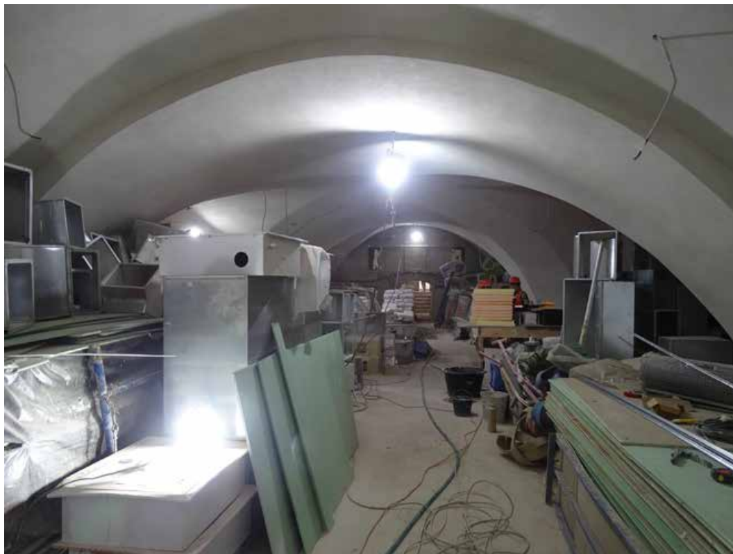
Фото 1. Помещение подвала. Съемка 01.10.2024 г. Полетайкин В.В.
