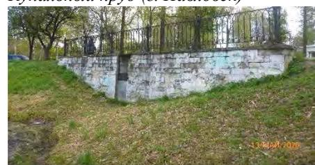
*Водосливная плотина на пруду*
