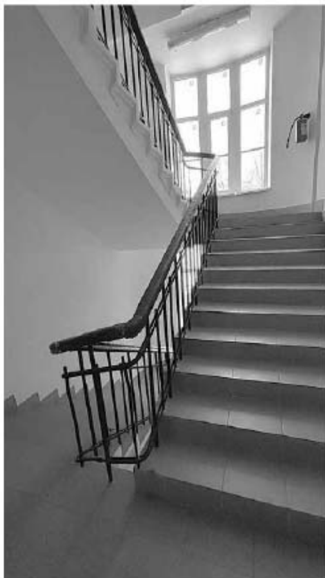
13. Лестница в северной части здания.
