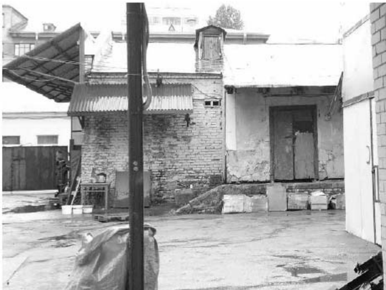
3. Восточный фасад, фрагмент. Каркасная пристройка, оштукатуренная по дражке.
