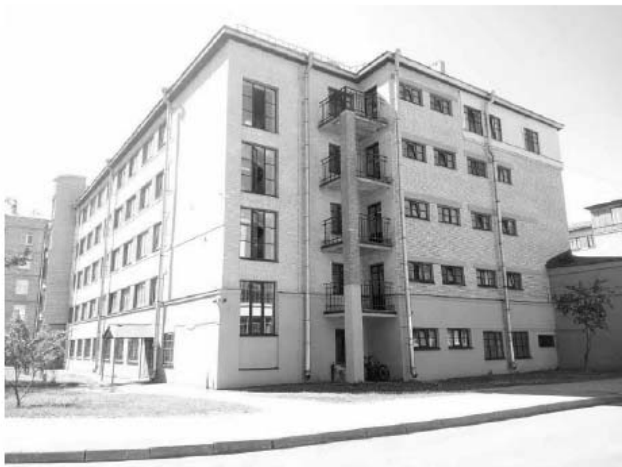
1. Общий вид с северо-востока.
