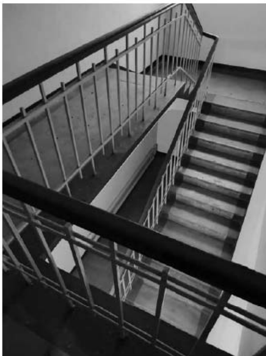
16. Лестничная клетка в центральной части здания.
