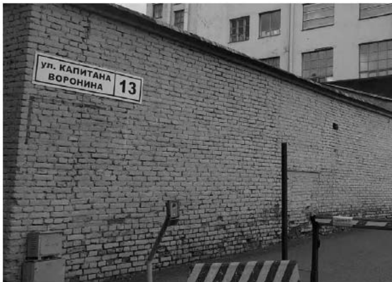
6. Фрагмент западного фасада. Трещины в кладке, перемычка заложеного в центральной части фасада.
