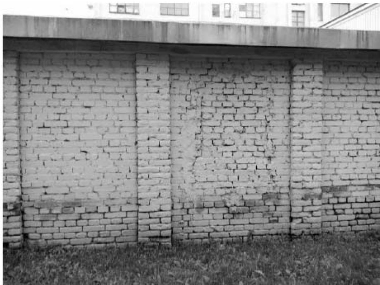
5. Северный фасад, следы закладки проёма.
