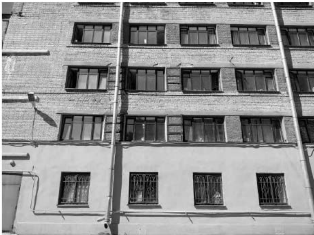
7. Фрагмент восточного фасада. Часть простенков заключена в обоймы.
