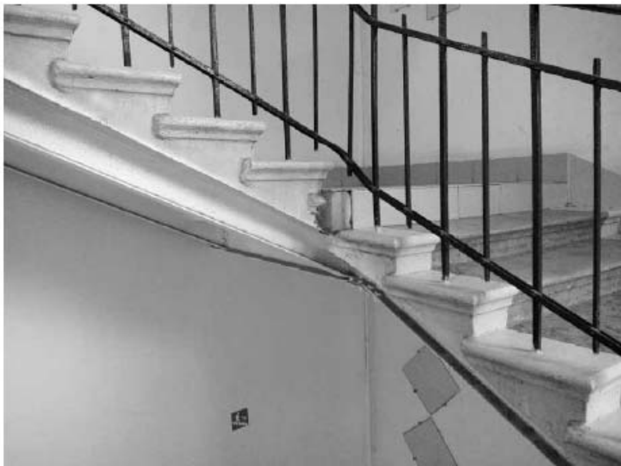
27. ЗЛК. Историческая конструкция лестницы, профиль ступеней, ограждение в уровне 3-4 этажа.
