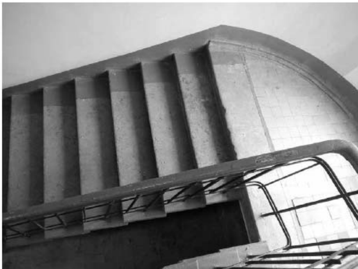
8. Южная лестница. Общий вид в уровне 1-2 этажа.
