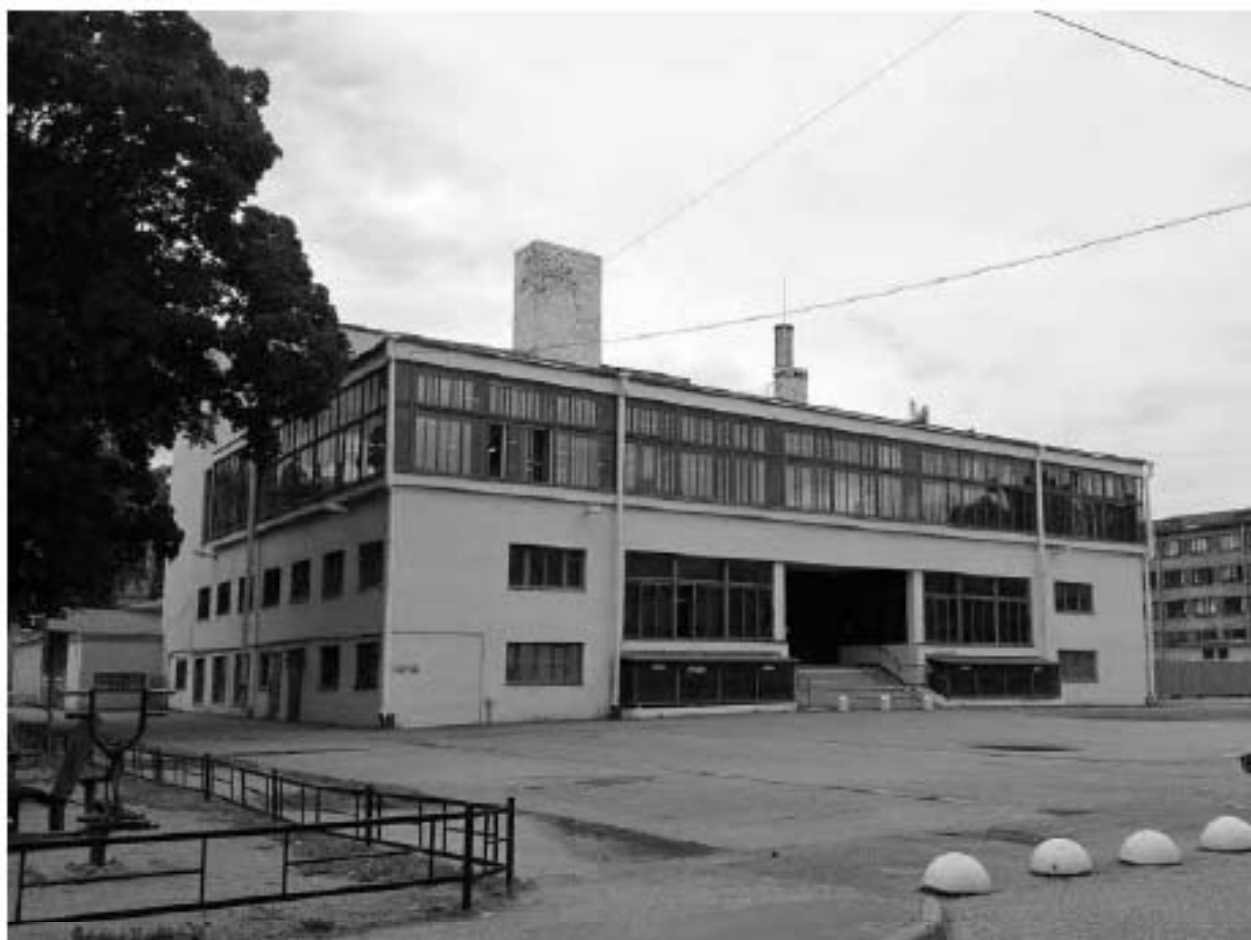
1. Общий вид здания – западный и южный фасады.
