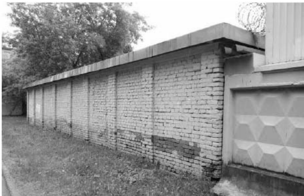
4. Северный фасад, общий вид.
