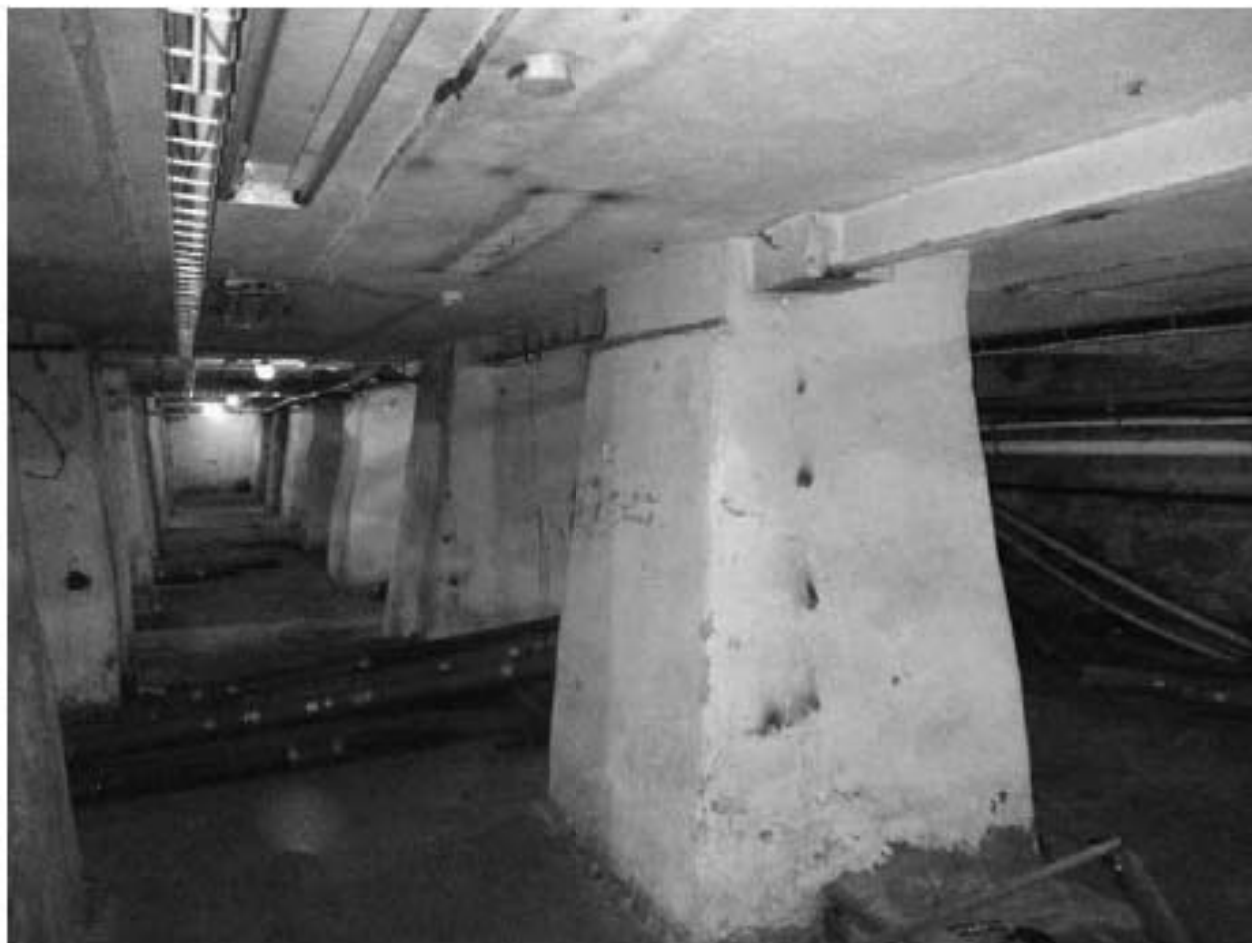
42. Южная часть корпуса. Подвал. Железобетонные опоры.
