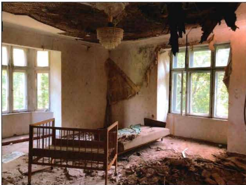
4. Пом. №1-Н(28). Общий вид.
