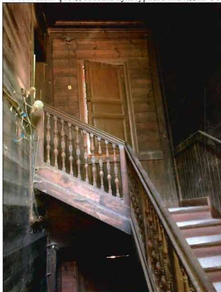
3. Лестница. Общий вид.
