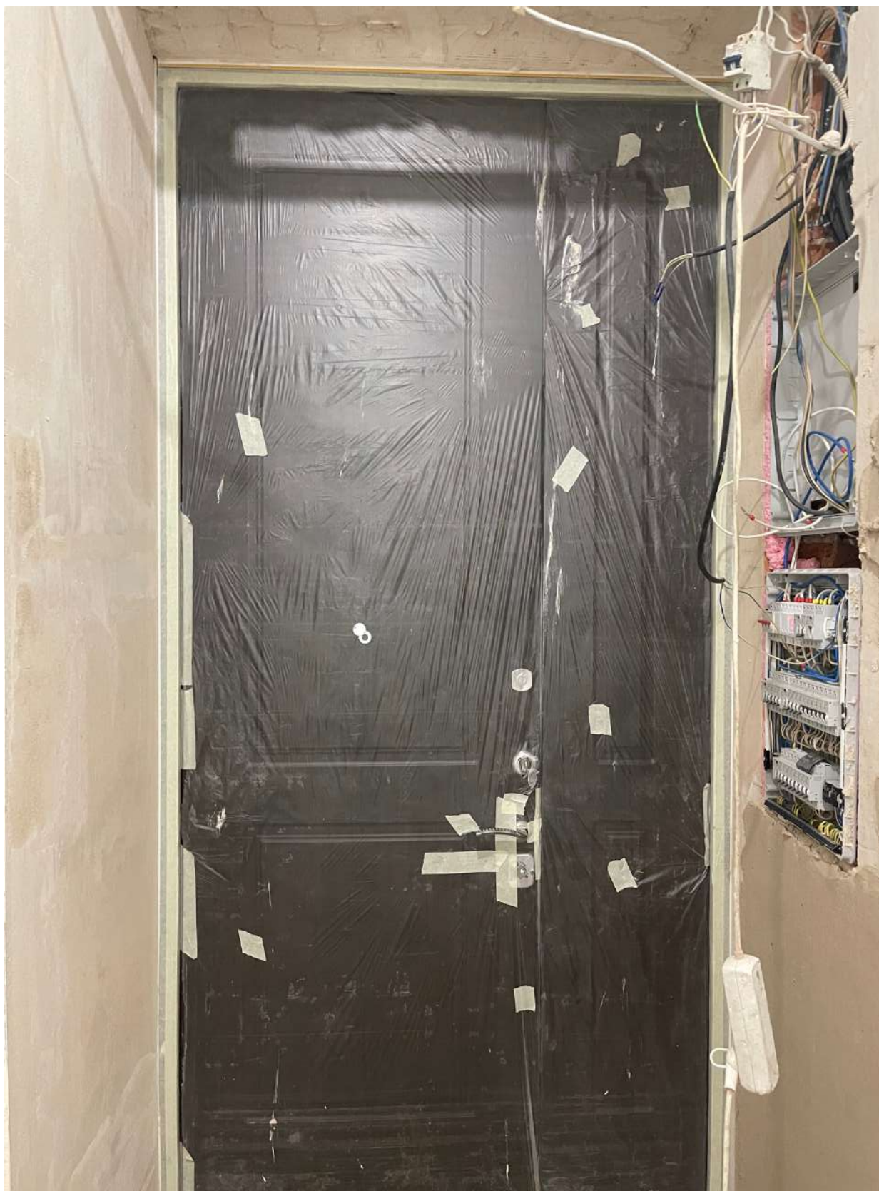
4. Вид на входную дверь в квартире;
