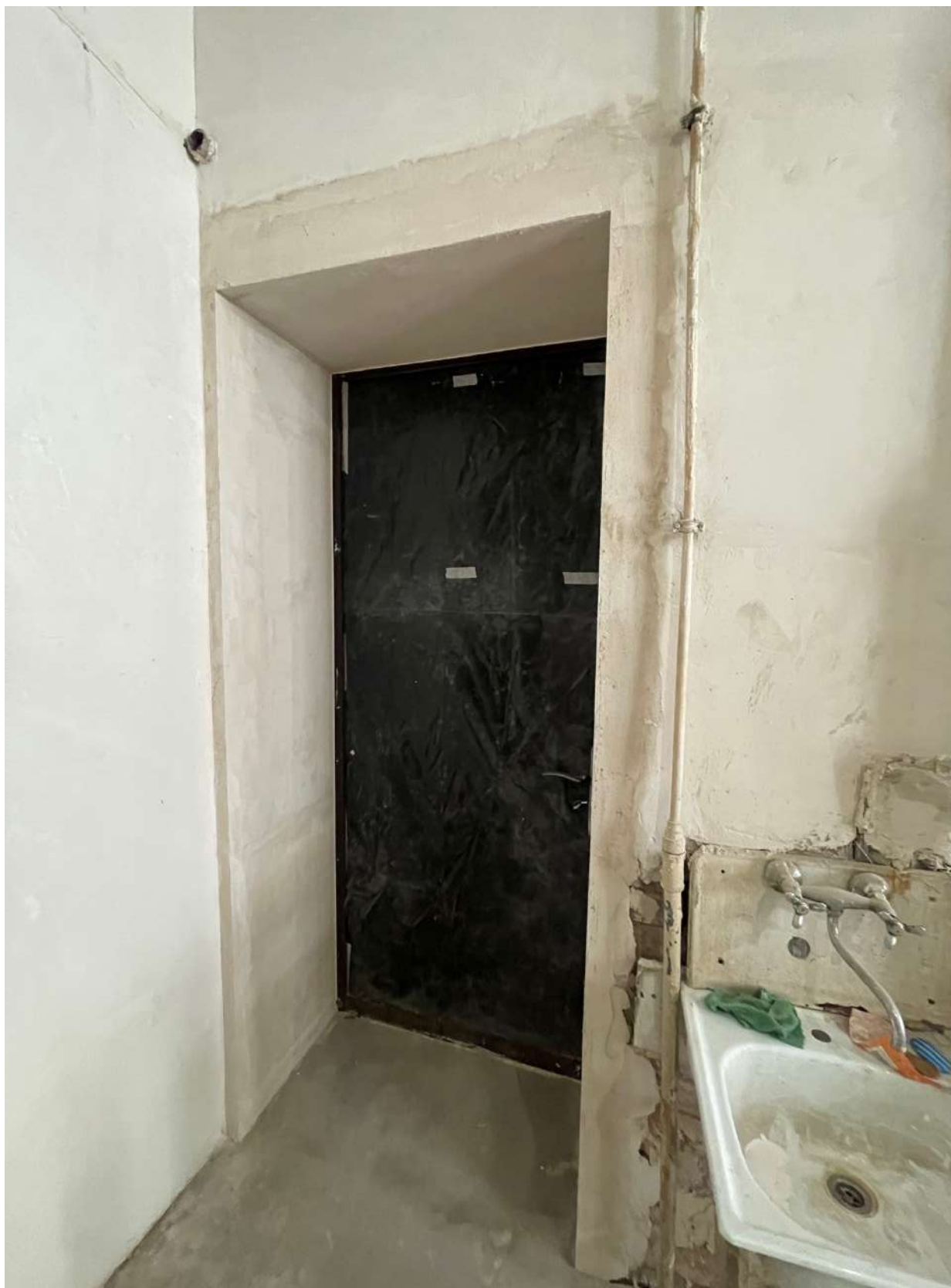
13. Вид на входную дверь в квартире;
