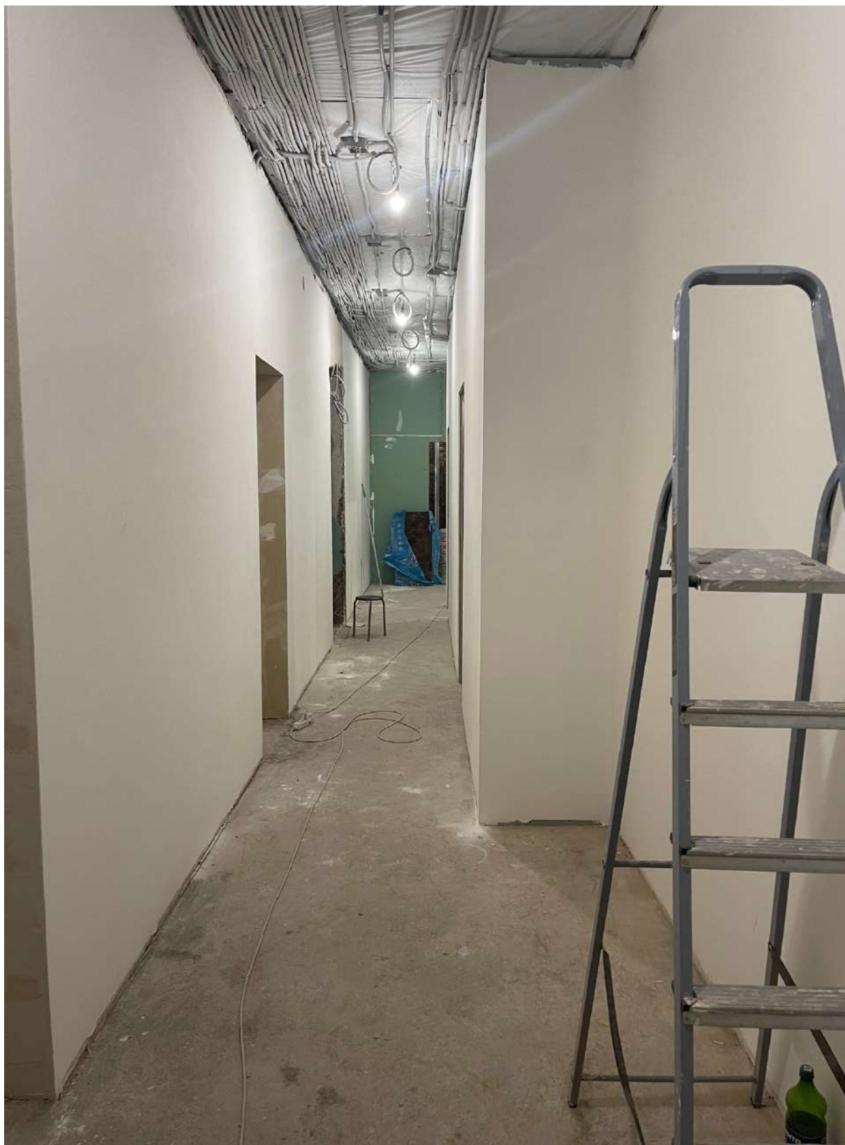
5. Фрагмент интерьера коридора (помещение 9/14.1);
