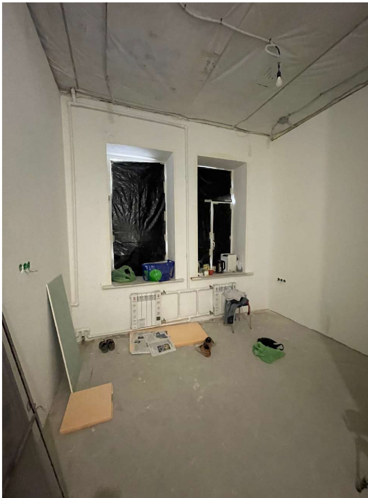
15.Фрагмент интерьера комнаты (помещение 5/17.1);
