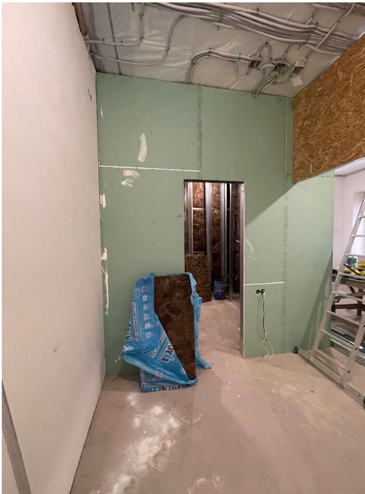
6. Фрагмент интерьера коридора (помещение 9/14.1), вид на ванную и комнату (помещения 2/3.4 и 7/6.6);
