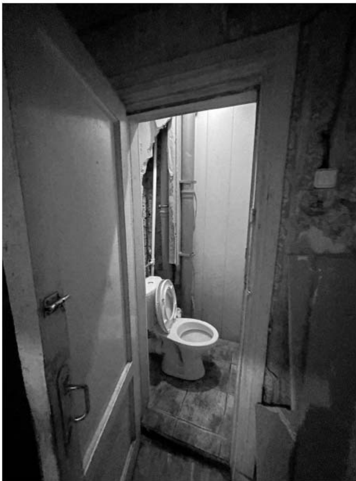
7. Фрагмент интерьера туалета (помещение 2/1.1);
