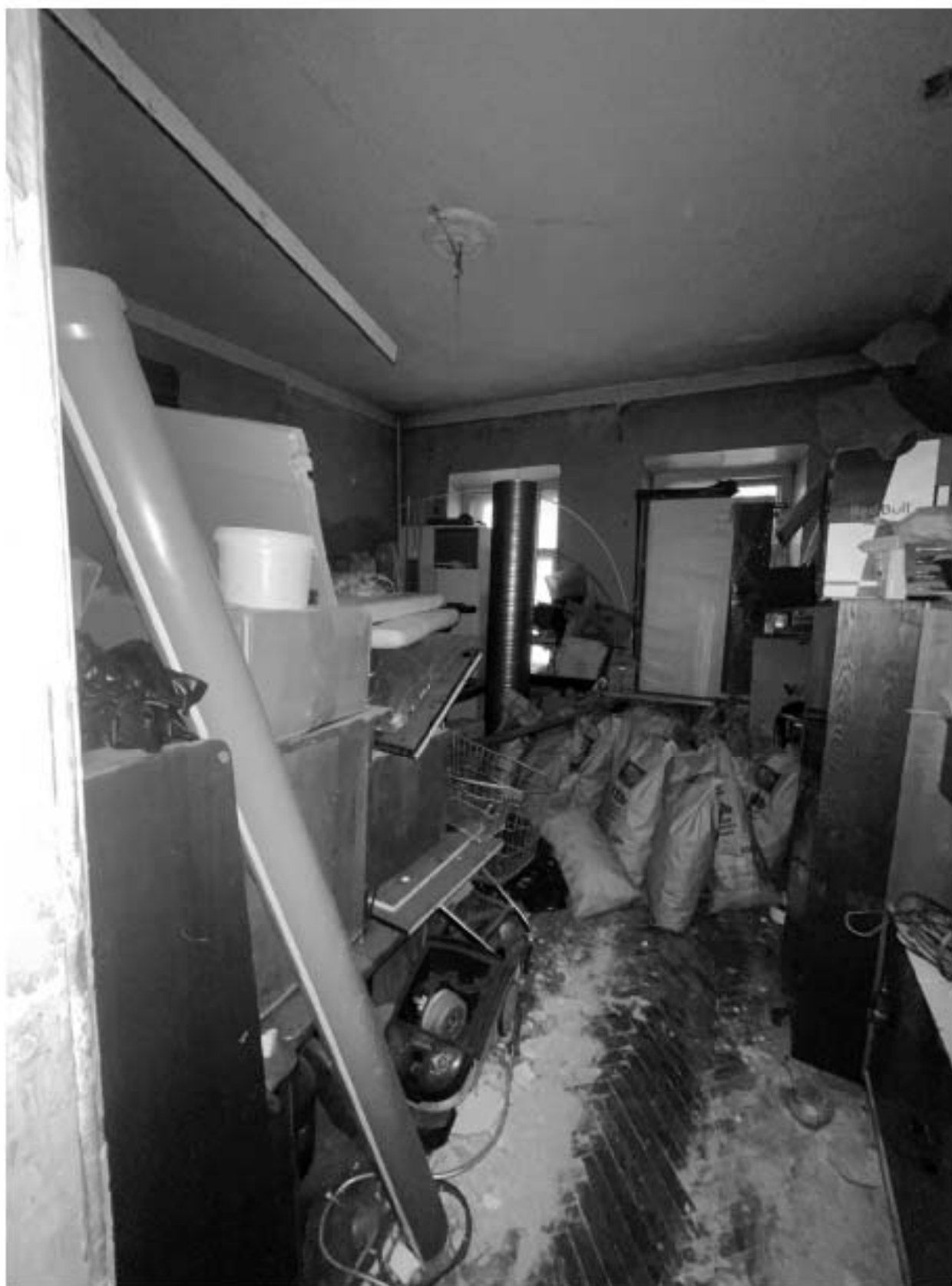
8. Фрагмент интерьера комнаты (помещение 4/24.5);
