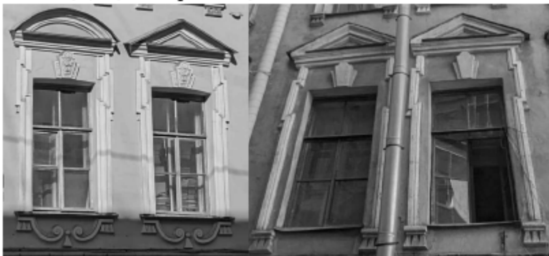
Рис. 2. Историческое оконное заполнение лицевого и дворового фасадов.
