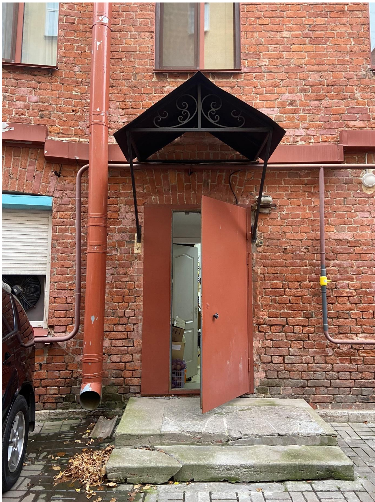
Фото 7. Вид на вход в помещение 21-Н со двора.
