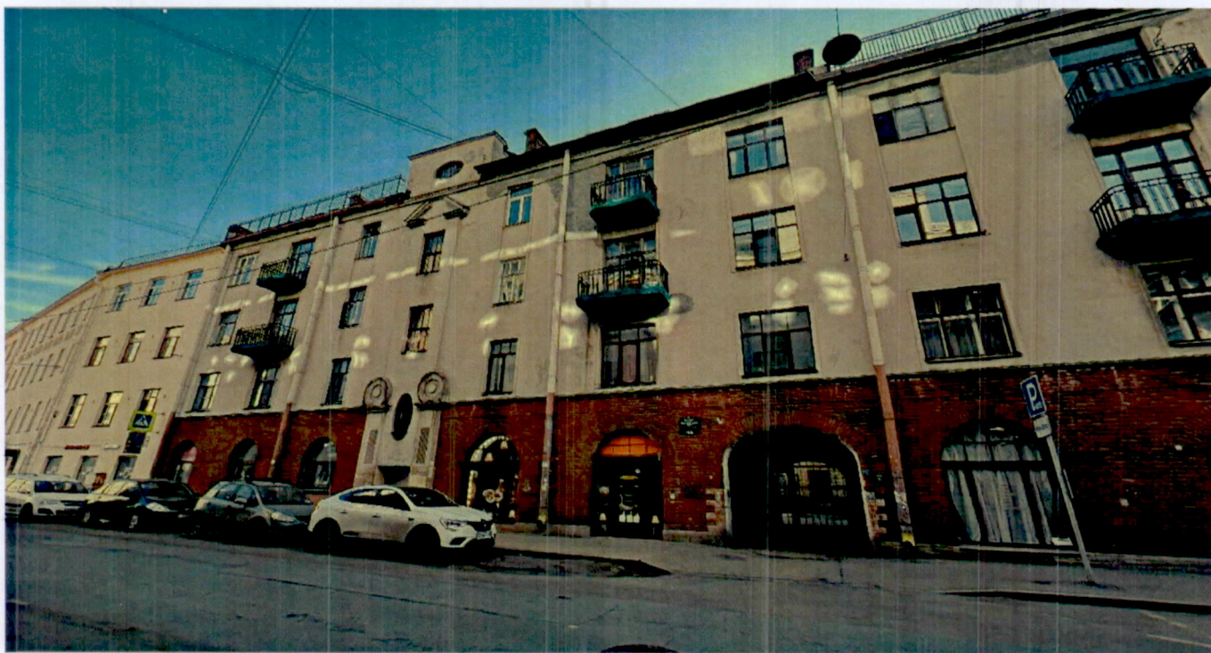
2, 3. Общий вид лицевого фасада объекта культурного наследия по Малой Посадской ул. (фотофиксация 12.03.2024).
