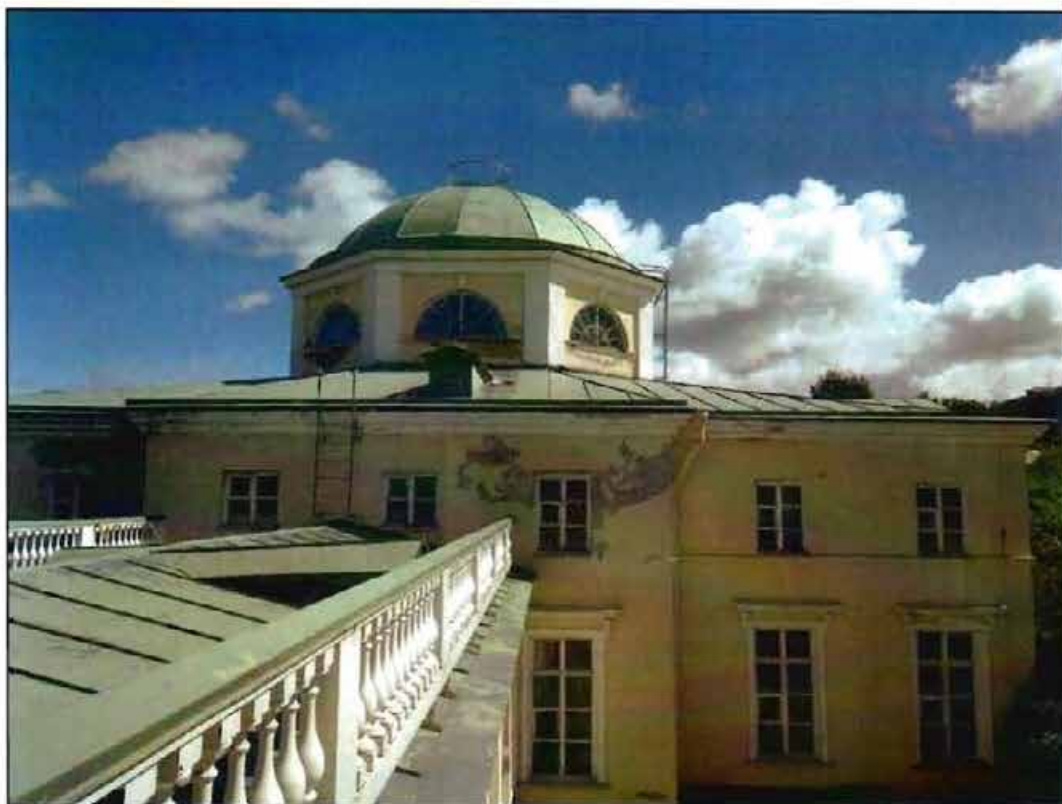
5. Фрагмент западного фасада.
