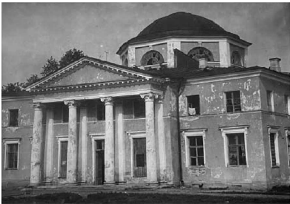
13. Вид главного корпуса усадьбы с юго-востока. 1930-е гг. // КГИОП. Инв. №: Н-13880
