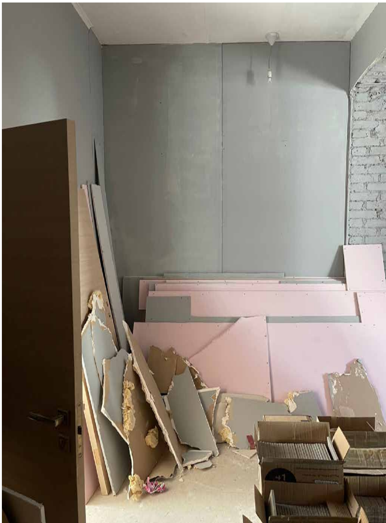
3. Фрагмент интерьера коридора (помещение 9/7.7);
