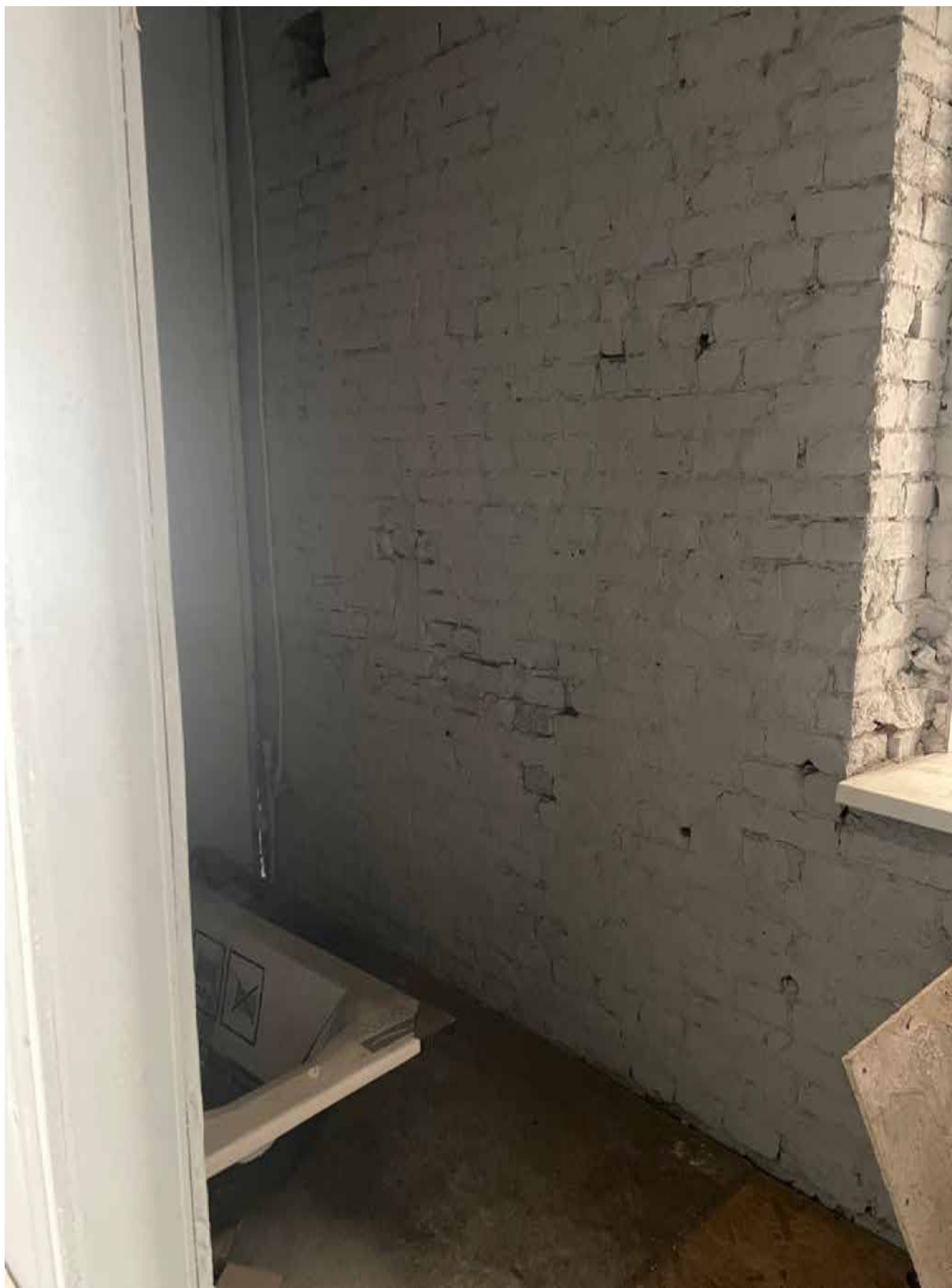
12.Фрагмент интерьера ванной (помещение 5/4.6);
