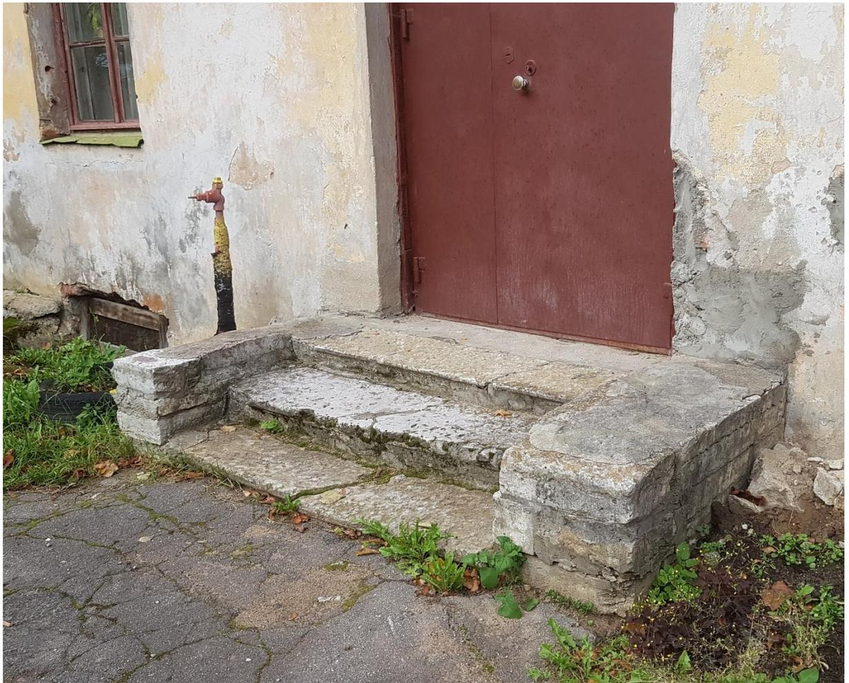
Фото 1. Известняковое крыльцо. Фасад в осях 11-12.
