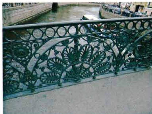
решетка ограждения фланкирована секциями глухого парапетного ограждения из блоков розового гранита рапакиви (соединенного с ограждением набережной с изгибом);
