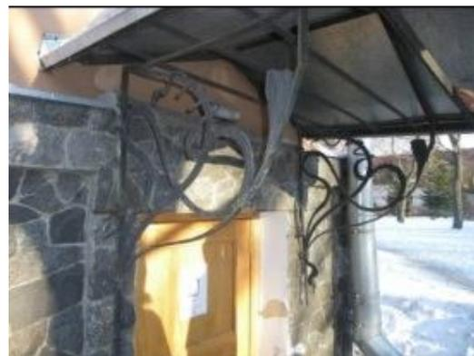
оформление дверного проема – портал с аркой параболической формы на опорах, сложенных из круглых и прямоугольных каменных блоков;
