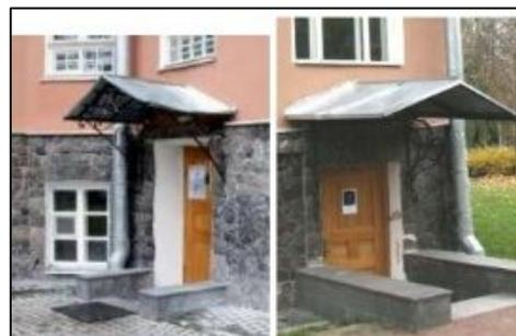
кронштейны козырька – местоположение (на лицевом фасаде по Магазиной ул.), габариты, материал (металл), техника исполнения (ковка), рисунок (в стиле модерн с растительными завитками);
