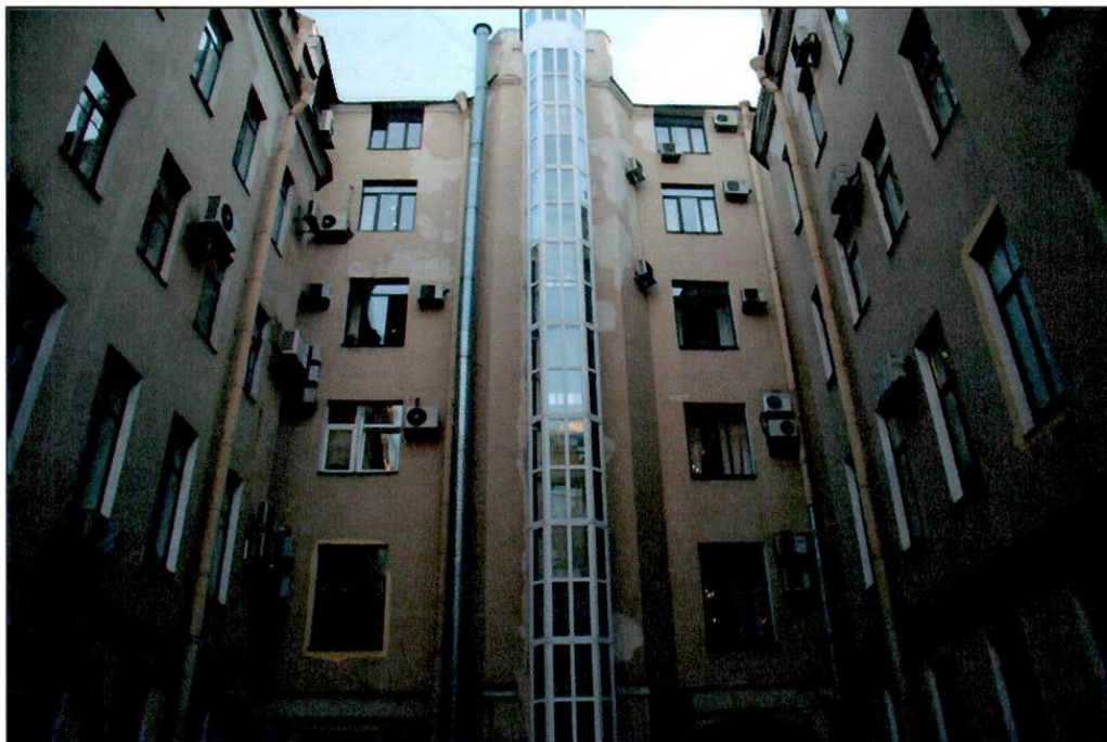
3. Общий вид. Дворовые фасады.
