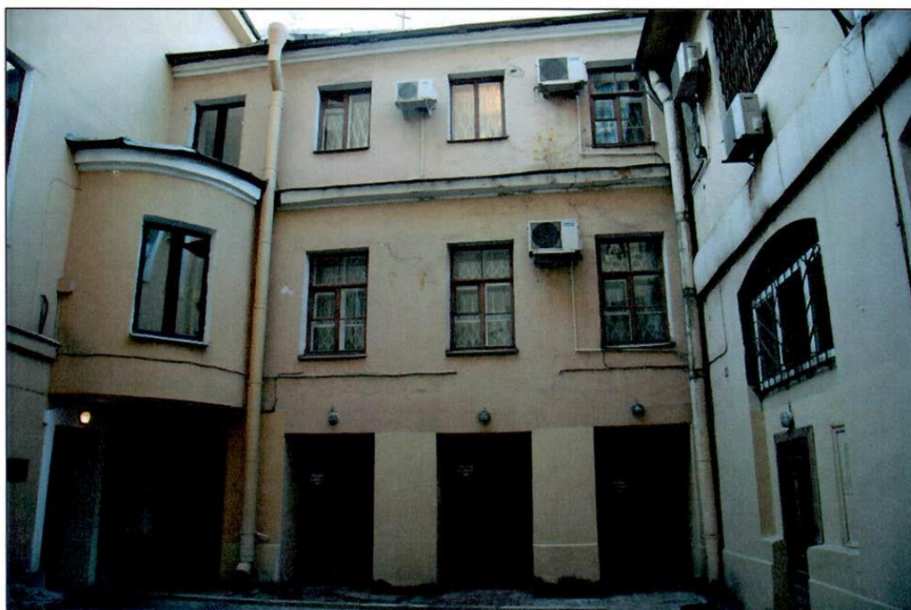
4. Общий вид. Дворовые фасады.
