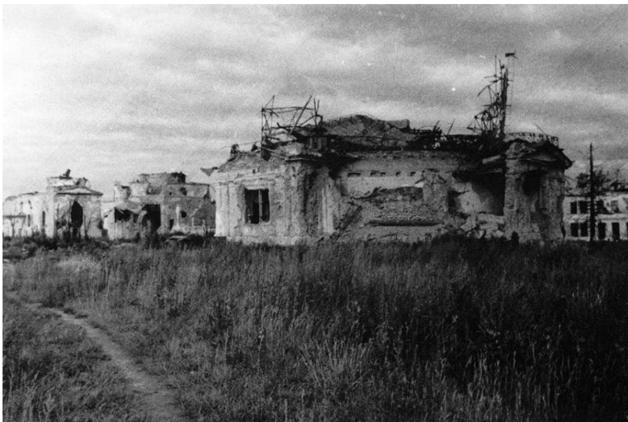
37. Вид разрушенных зданий Пулковской обсерватории. 1942–1943 гг. Фотография. Автор фото – Кудояров Б.П. // Источник: ЦГАКФФД СПб. Фотодокументы. Оп.1АР-149. Ед.хр.201615.
