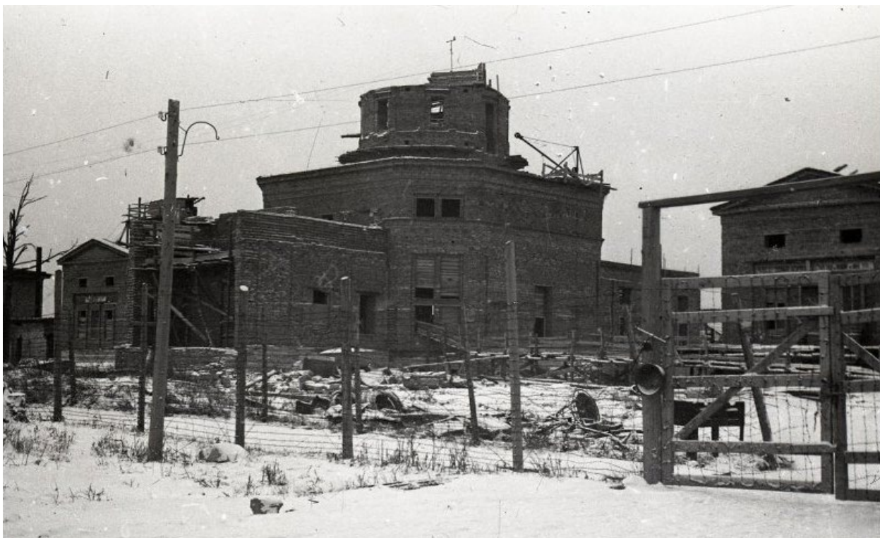
51. Восстановление здания Пулковской обсерватории (место боев за г. Ленинград 1941-1944 гг.). Фотография. Автор фото неизвестен. Январь 1949 г. // Источник: [Электронный ресурс] - URL: https://goskatalog.ru/portal/#/collections?id=40992735 (дата обращения: 09.07.2024).
