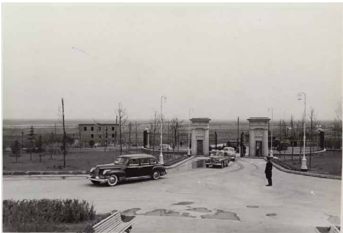
54. Открытие Пулковской обсерватории после восстановления. Фотография. Автор фото неизвестен. 1954 г. // Источник: [Электронный ресурс] - URL: https://goskatalog.ru/portal/#/collections?id=36583678 (дата обращения: 09.07.2024).
