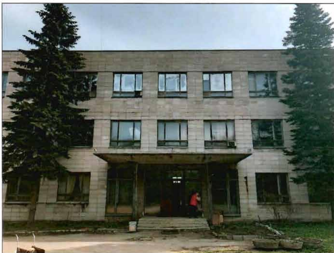
1. Западный фасад. Фрагмент.
