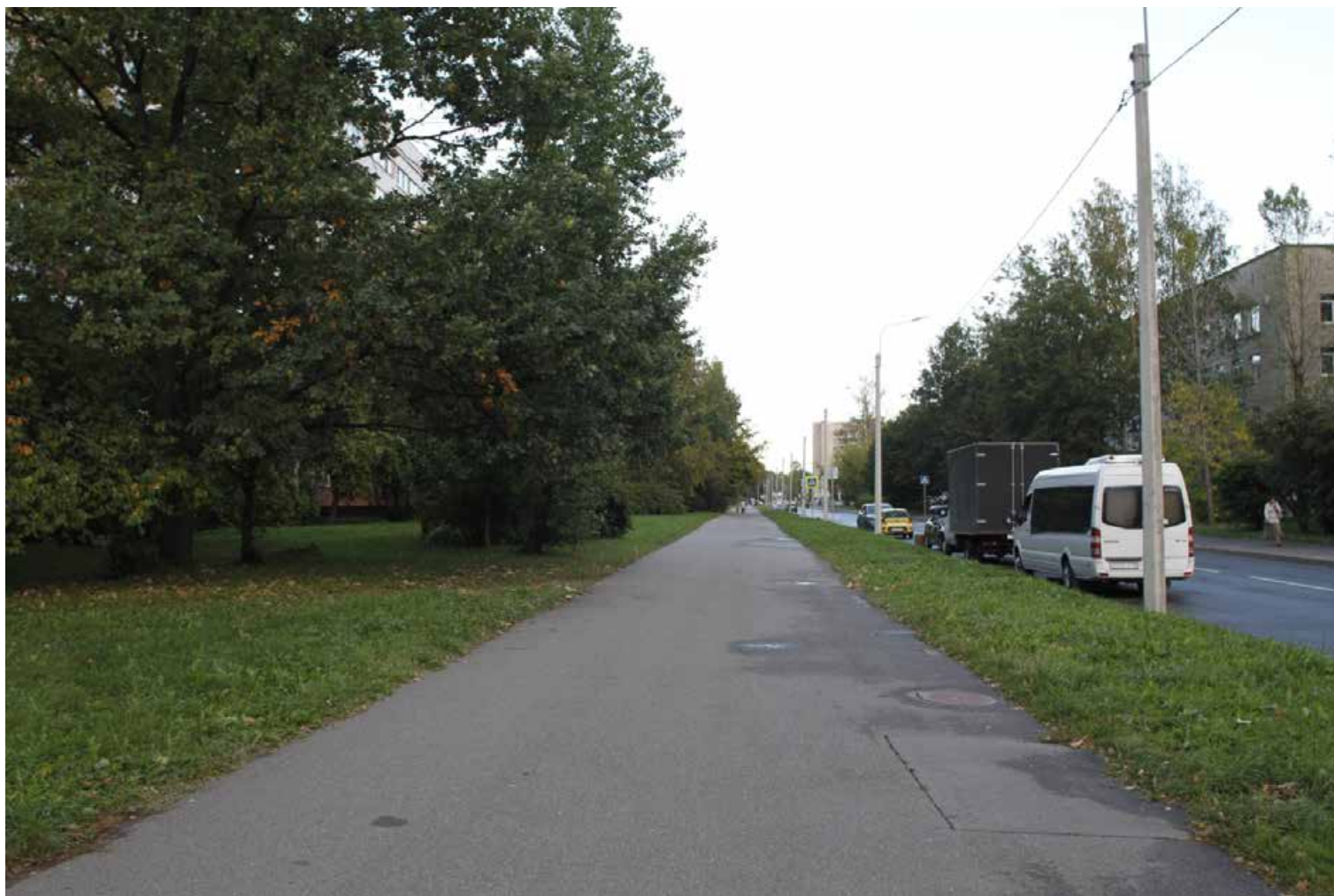
111. Трасса ул. Отважных. Фото:30.09.2024.
