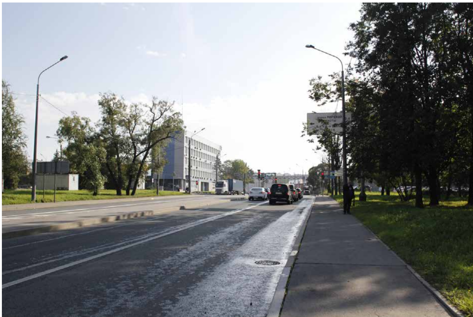
7. Вид вдоль трассы Автомобильной ул. Фото:30.09.2024.
