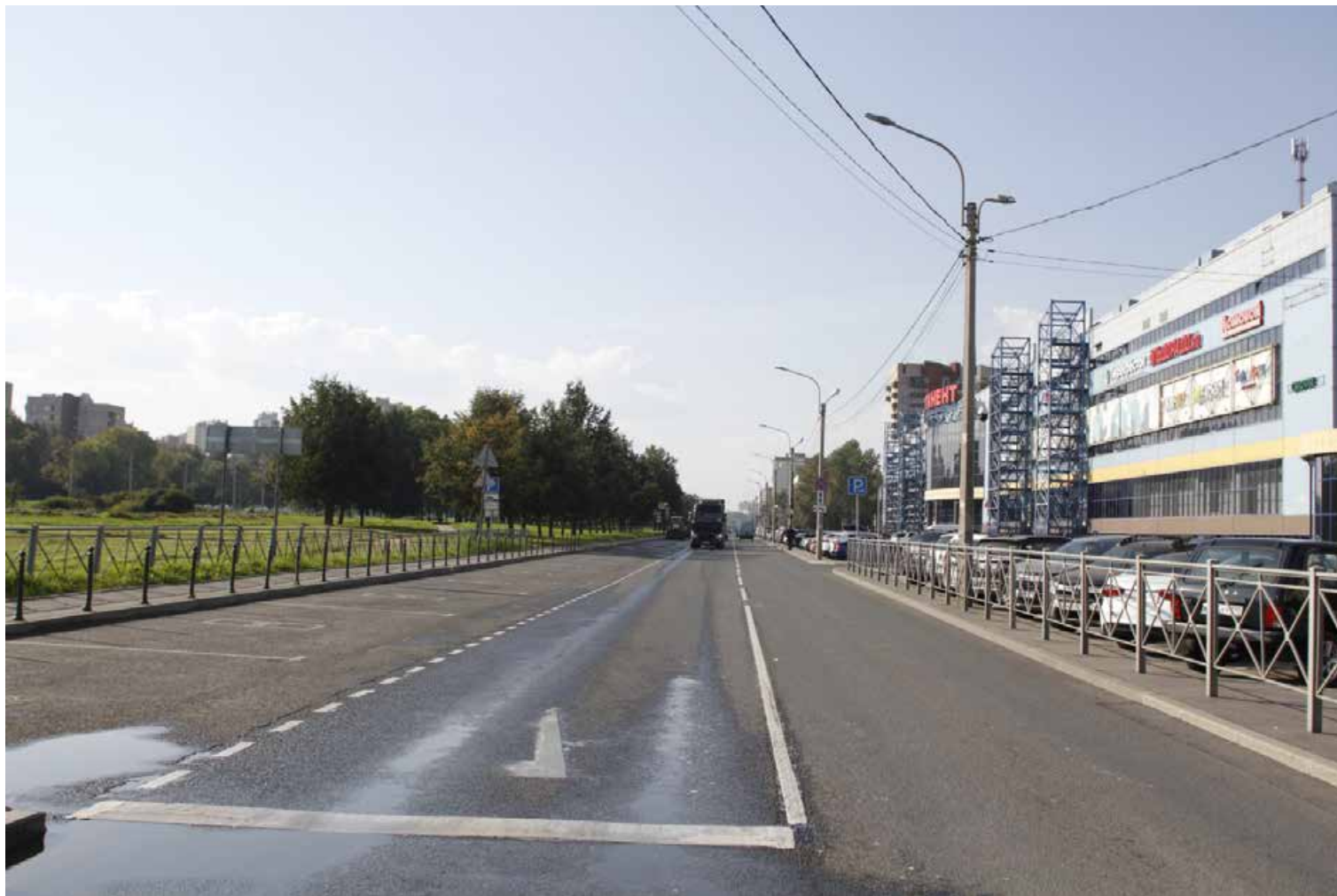
15. Вид вдоль трассы пр. Стачек. Фото:30.09.2024.
