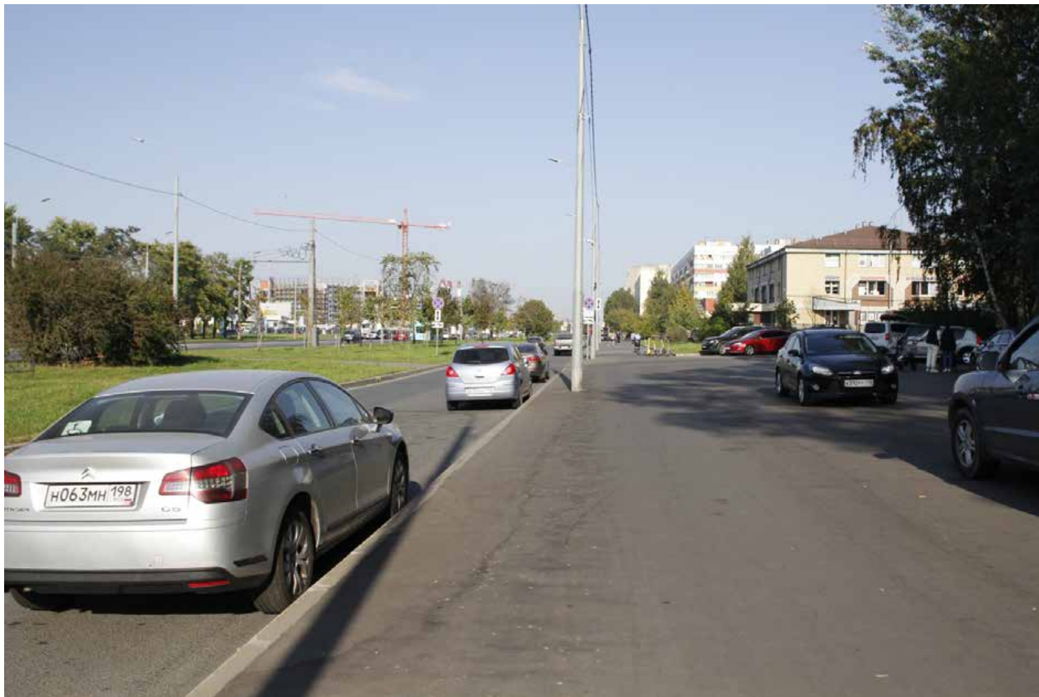
69. Вид вдоль трассы пр. Маршала Жукова. Фото:30.09.2024.
