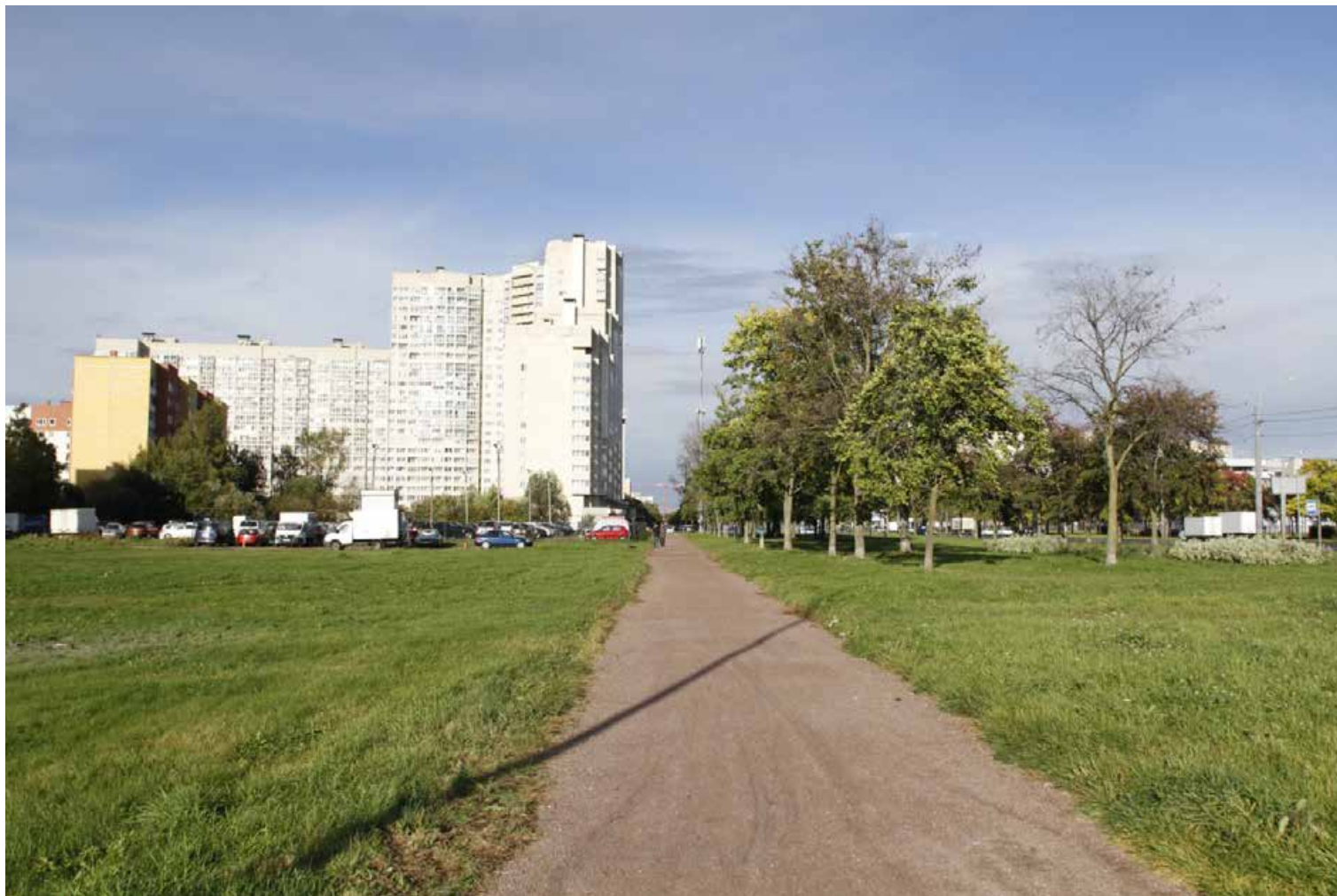
59. Вид вдоль трассы пр. Маршала Жукова. Фото:30.09.2024.
