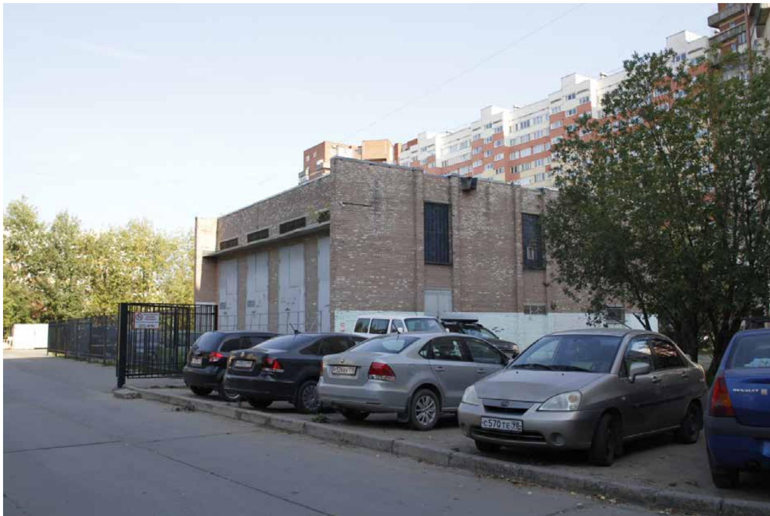
71. Внутридворовая территория. РП 36490 (п/ст №77). Фото:30.09.2024.
