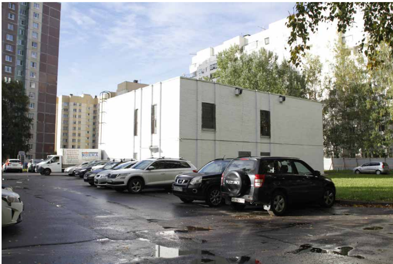
65. Внутридворовая территория. РП 36440 (п/ст №82). Фото:30.09.2024.
