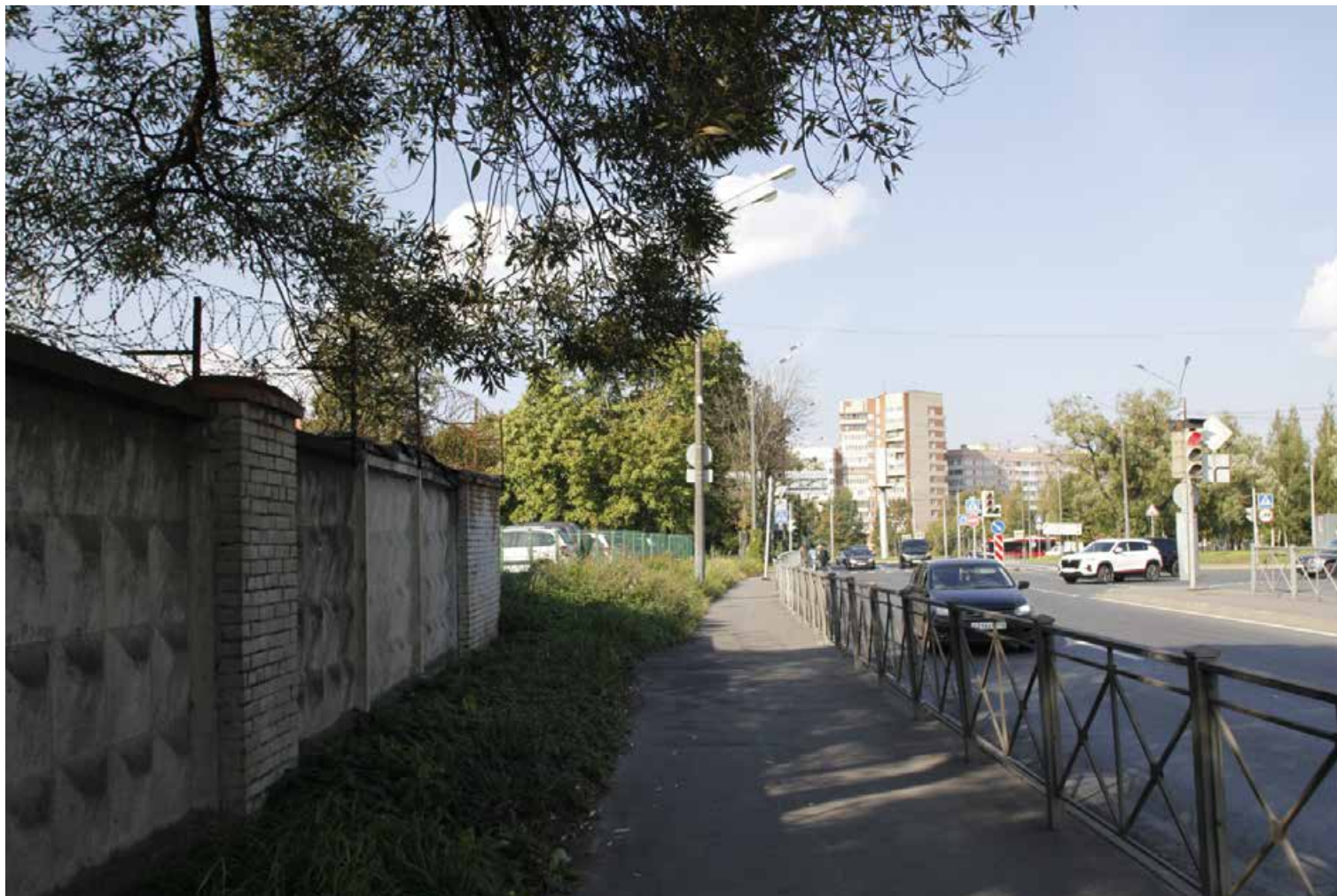
8. Вид вдоль трассы Автомобильной ул. Фото:30.09.2024.
