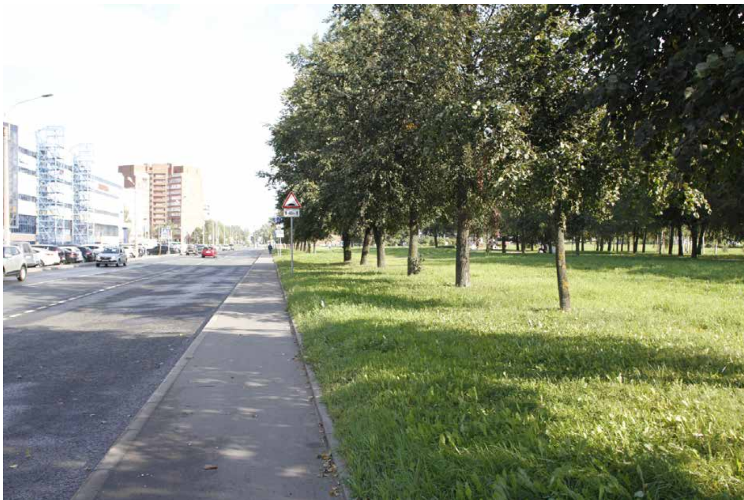
19. Вид вдоль трассы пр. Стачек. Фото:30.09.2024.
