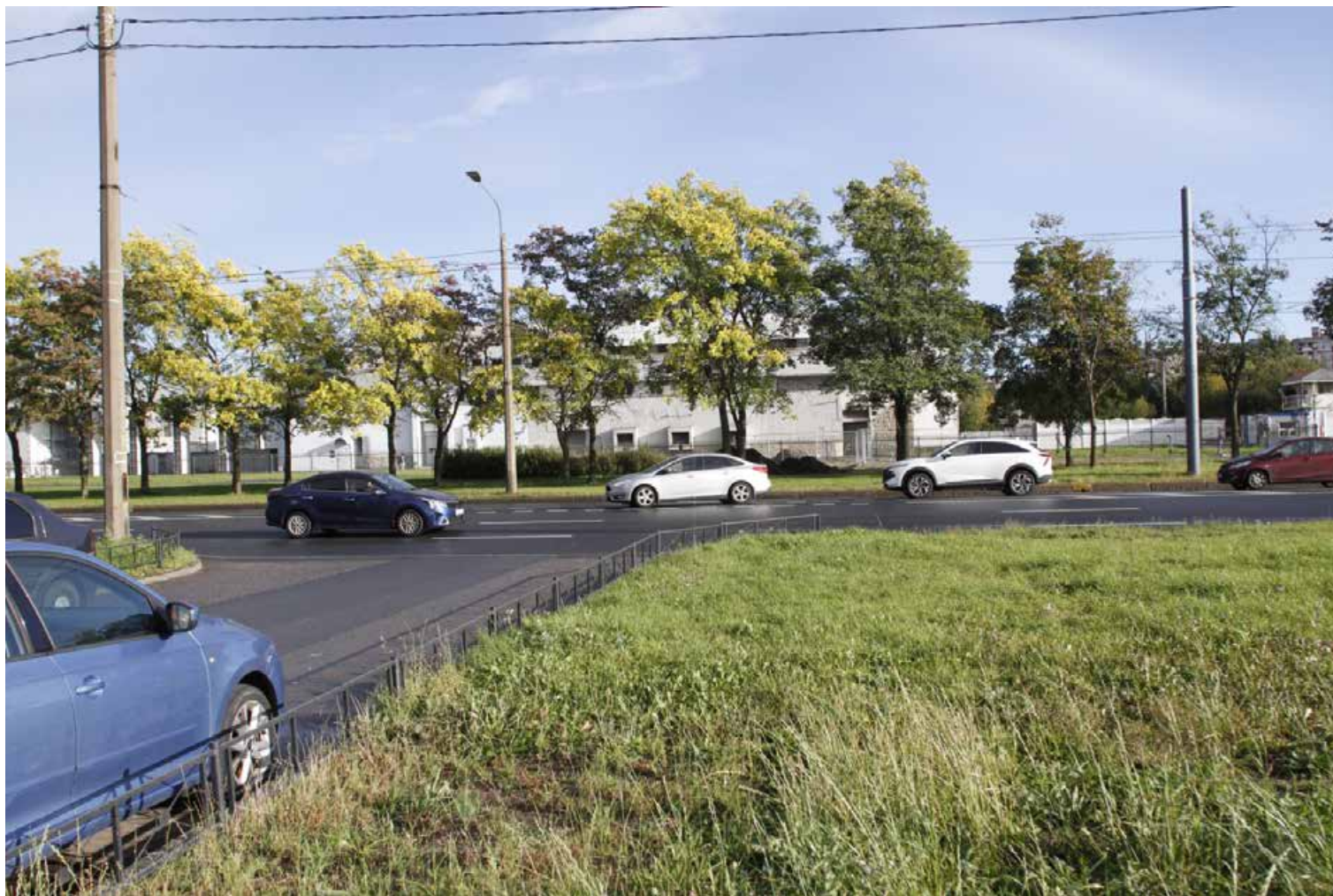
57. Вид вдоль трассы пр. Маршала Жукова. Фото:30.09.2024.
