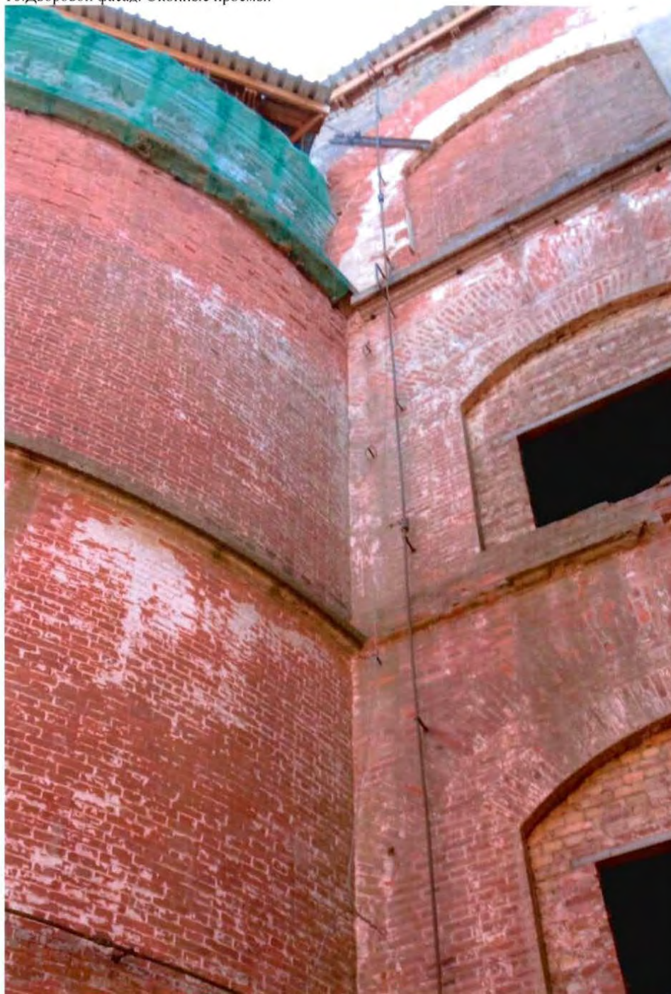
16. Дворовой фасад. Оконные проемы.
