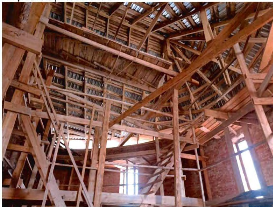
14. Временная стропильная система.
