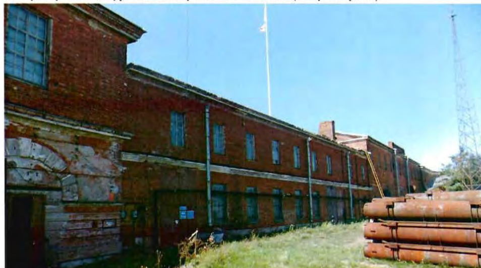
5. Правифланговая куртина с надстроенными объемами (северный фасад).
