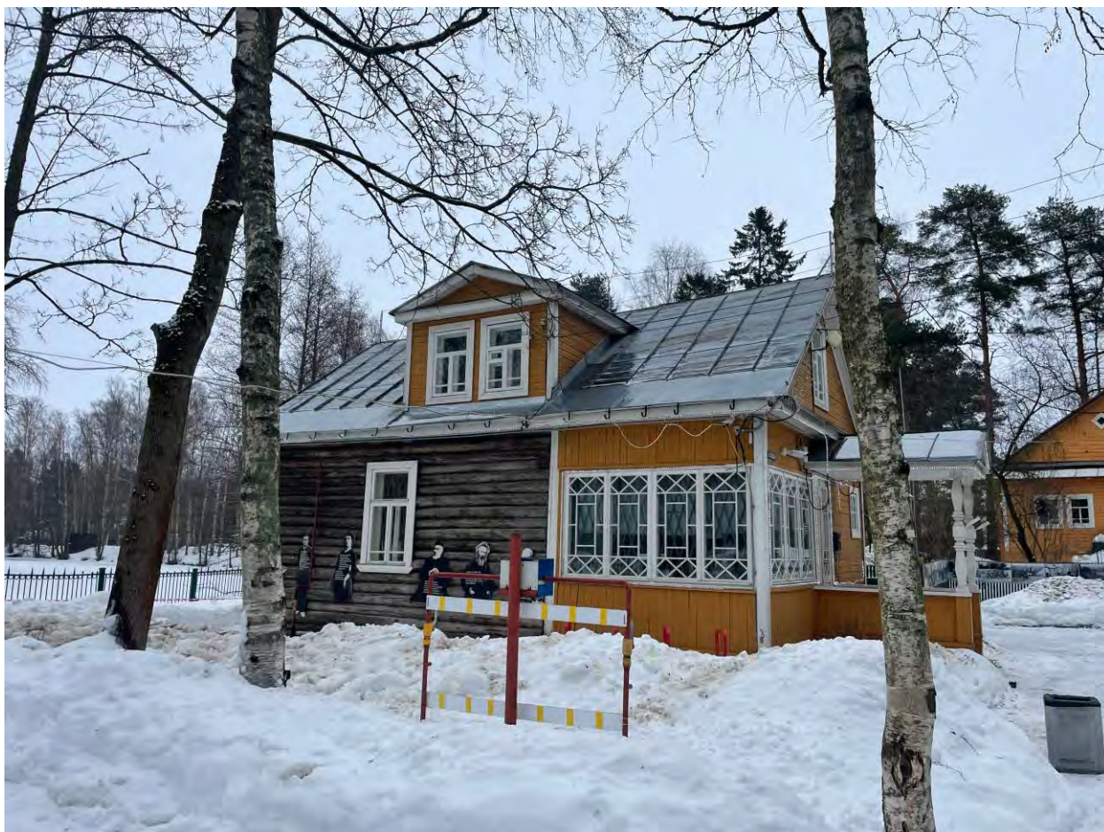
Фото 7. Административное здание музея (не объект культурного наследия).
