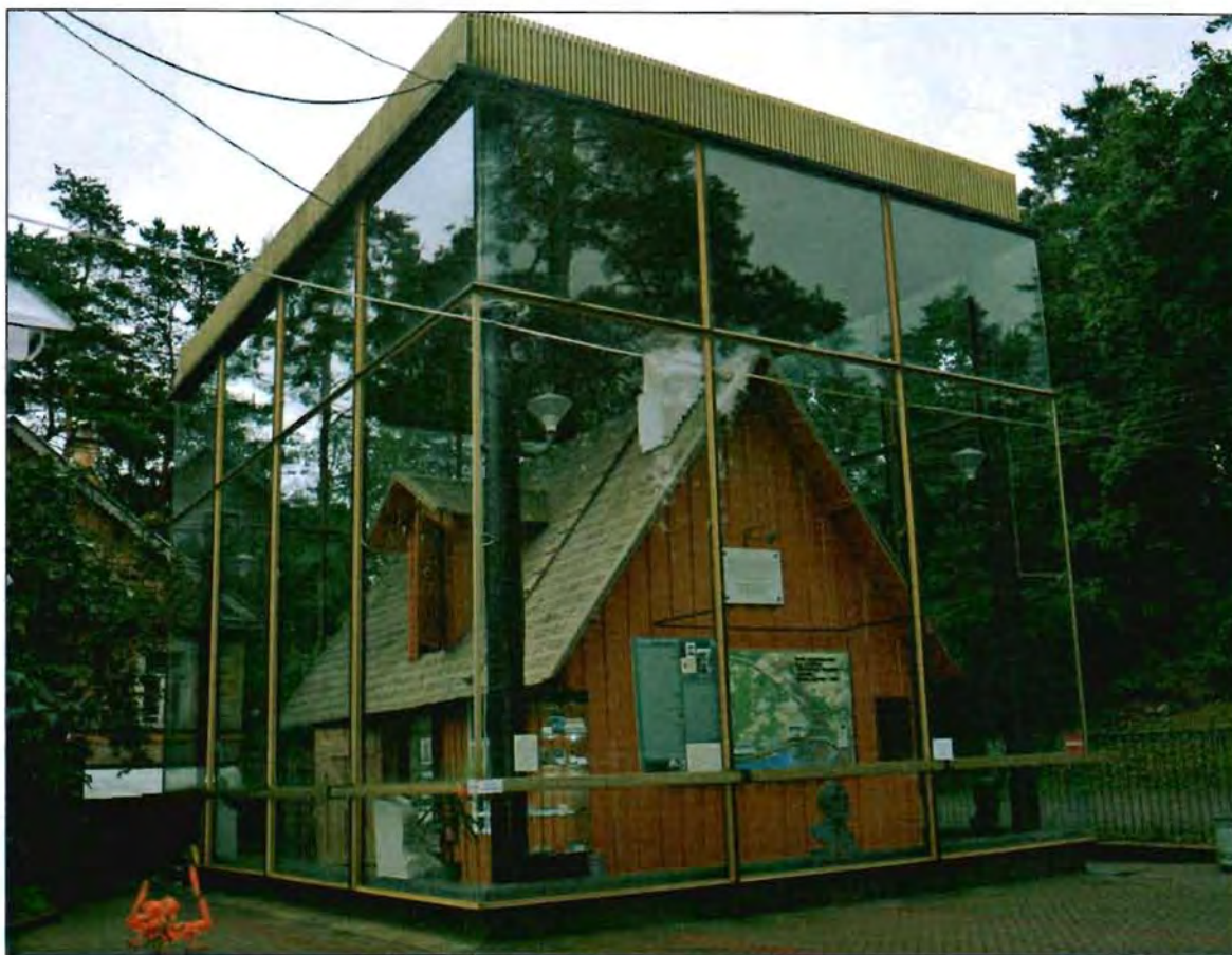
3. Общий вид с северо-запада.
