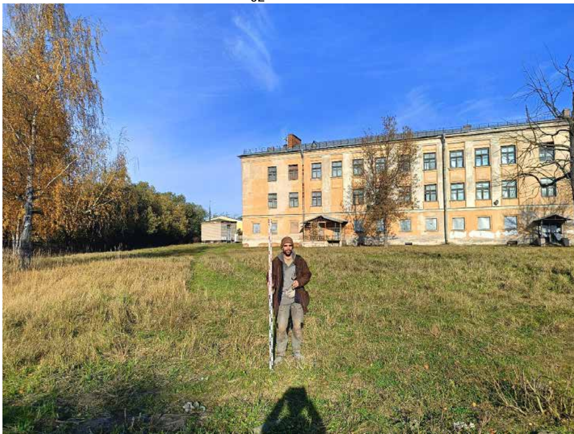
Рис. 12. Колпино-2024. Вознесенское ш., 32. Точка фотофиксации 1, вид с юга.
